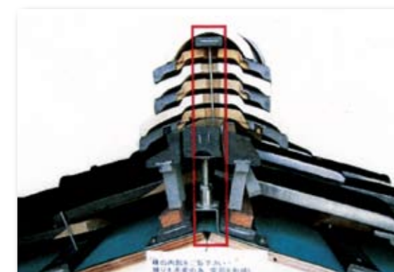
特許 第 3727931 ■瓦屋根における棟芯材の取り付け構造
