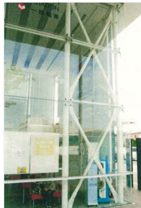
外部の柱・斜材
