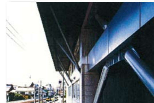
正面庇・ブレース
