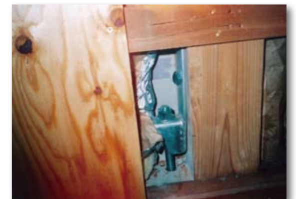
ホールインアンカー部
