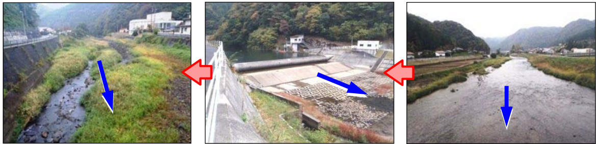
堰下流(支川合流前)
