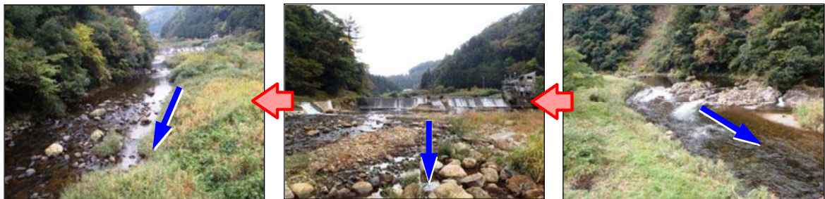
堰下流(支川合流前)
