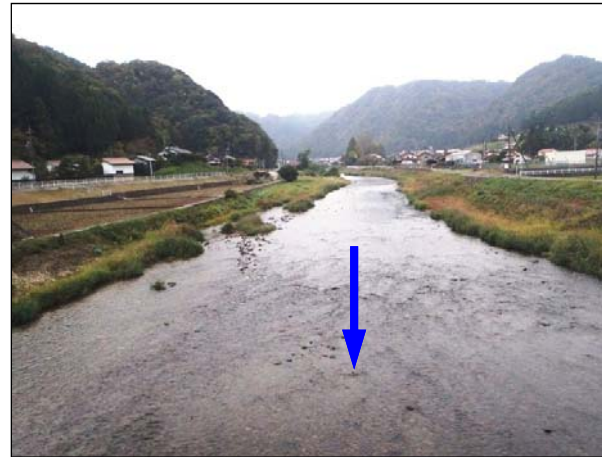
①八幡原堰の上流(川北大橋上流)
