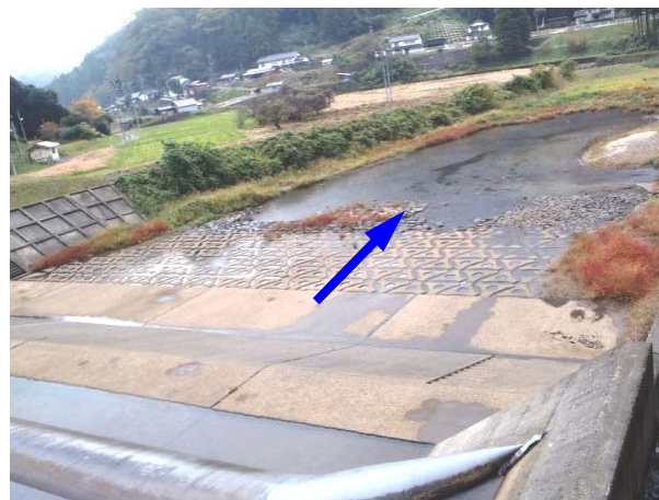
④八幡原堰の直下流
