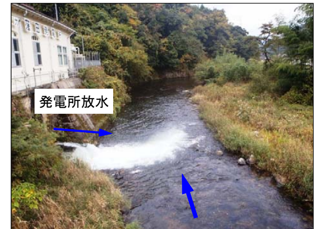
⑩窪田発電所放水口
