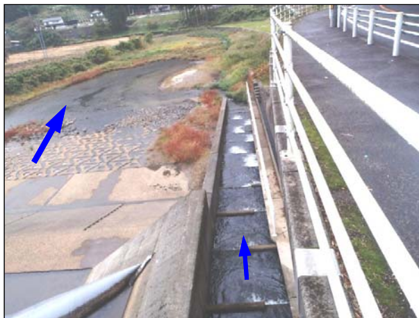
③八幡原堰の魚道
