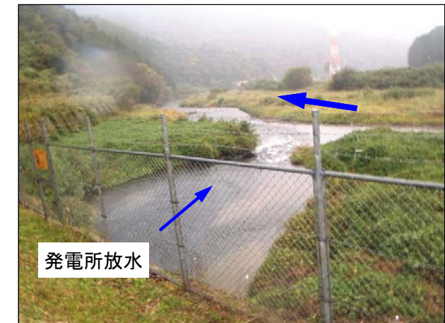
⑩乙立発電所放水口
