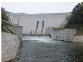
志津見ダム 16m³/s放流状況 (H25.4.17 16:20撮影) 発電放流及び放流用ゲートからの放流による減勢工越流状況
