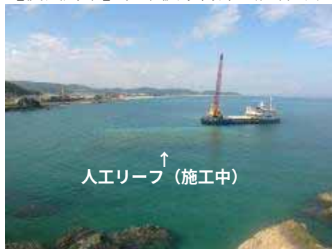
【侵食対策】和木波子海岸（江津市）
