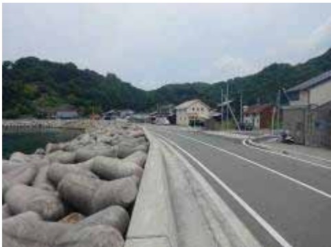
【侵食対策】浜田港日脚海岸（浜田市）
