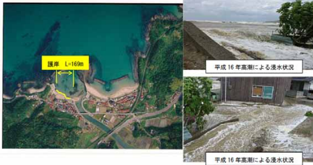
写真- 1.9 高潮による浸水被害の事例
