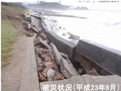
写真- 1.8 越波状況と高潮・波浪による施設被害の事例
