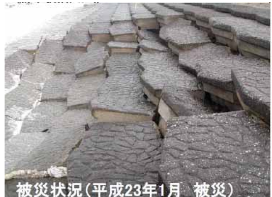
写真- 1.8 越波状況と高潮・波浪による施設被害の事例
