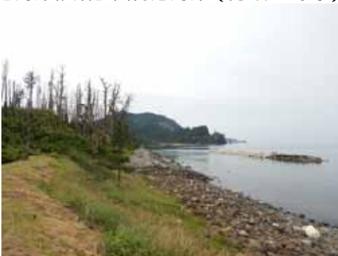
【海岸修繕】西村港海岸（隠岐の島町）
