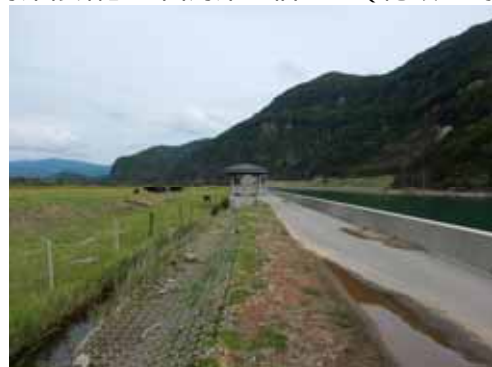
【海岸修繕】五箇海岸重栖地区（隠岐の島町）
