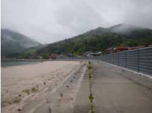
【高潮対策】別府港海岸（西ノ島町）
