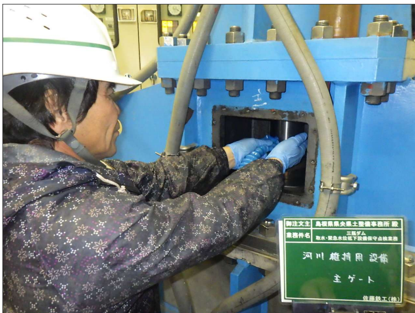
写真区分: 施工状況写真 工種: 河川維持用放流設備 種別: 主ゲート 細別: 開閉装置 写真タイトル: 給脂状況 撮影箇所: シリンダーロッド
