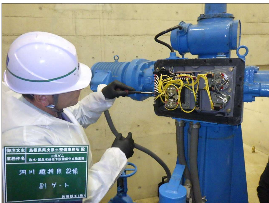
写真区分: 施工状況写真 工種: 河川維持用放流設備 種別: 副バルブ 細別: 開閉装置 写真タイトル: 端子緩み点検 状況 撮影箇所: 制限開閉器
