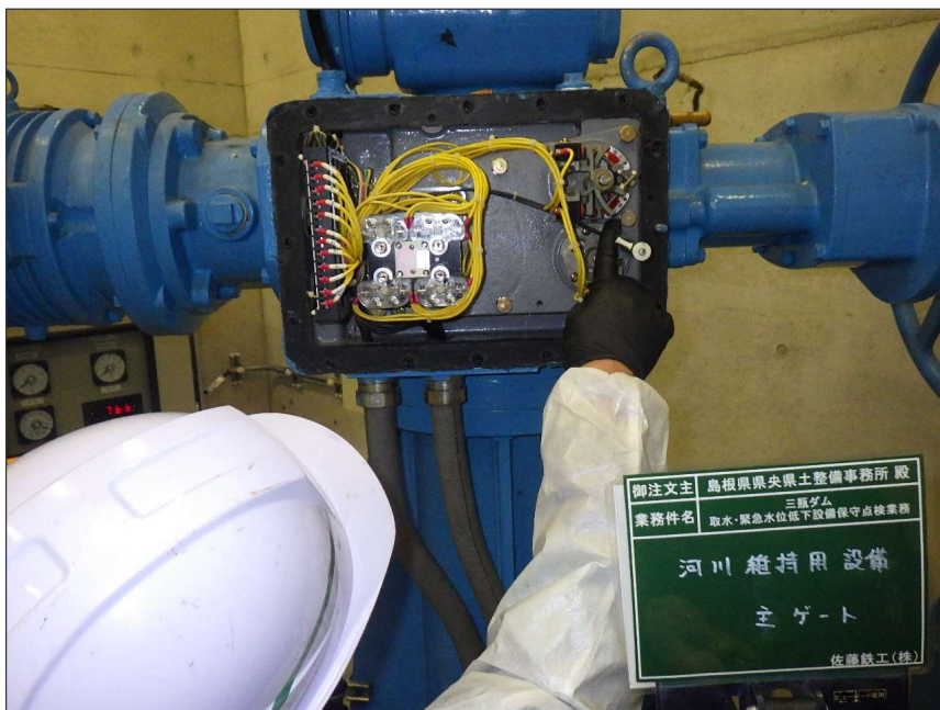
写真区分: 施工状況写真 工種: 河川維持用放流設備 種別: 主ゲート 細別: 開閉装置 写真タイトル: 外観点検状況 撮影箇所: 制限開閉器
