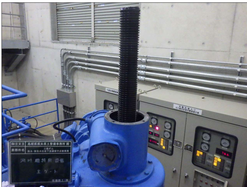
写真区分: 施工状況写真 工種: 河川維持用放流設備 種別: 主ゲート 細別: 開閉装置 写真タイトル: 清掃前 撮影箇所: スピンドル
