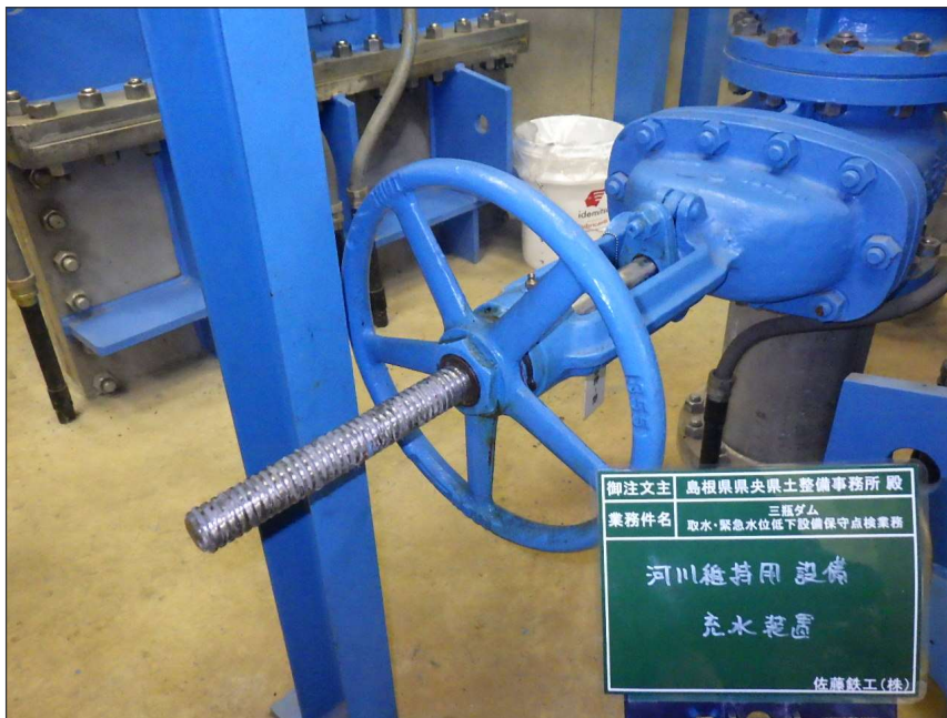
写真区分: 施工状況写真 工種: 河川維持用放流設備 種別: 充水装置 写真タイトル: 給脂完了 撮影箇所: スピンドル
