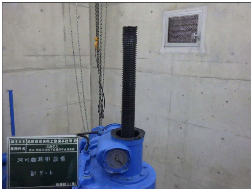
写真区分: 施工状況写真 工種: 河川維持用放流設備 種別: 副バルブ 細別: 開閉装置 写真タイトル: 清掃前 撮影箇所: スピンドル
