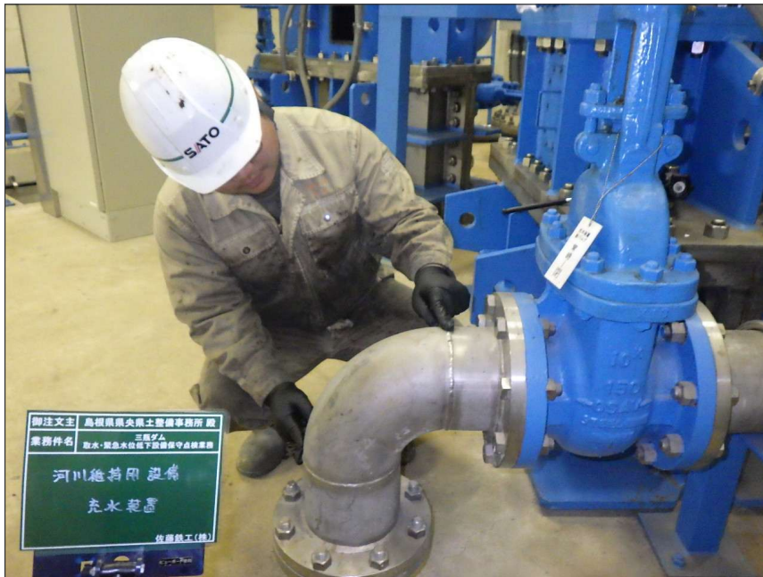
写真区分: 施工状況写真 工種: 河川維持用放流設備 種別: 充水装置 写真タイトル: 外観点検状況 撮影箇所: 充水管
