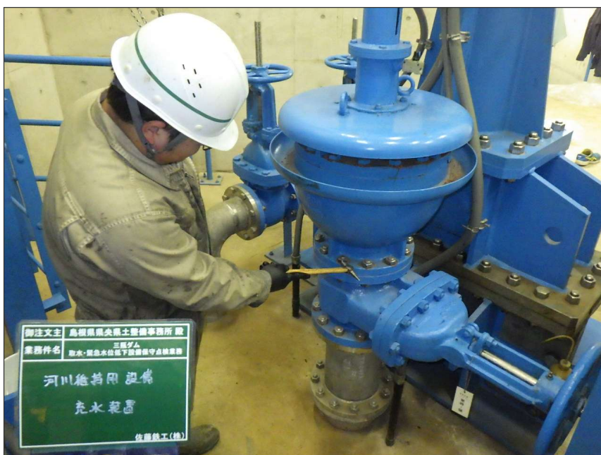
写真区分: 施工状況写真 工種: 河川維持用放流設備 種別: 充水装置 写真タイトル: ボルト緩み点 検状況 撮影箇所: 充水管
