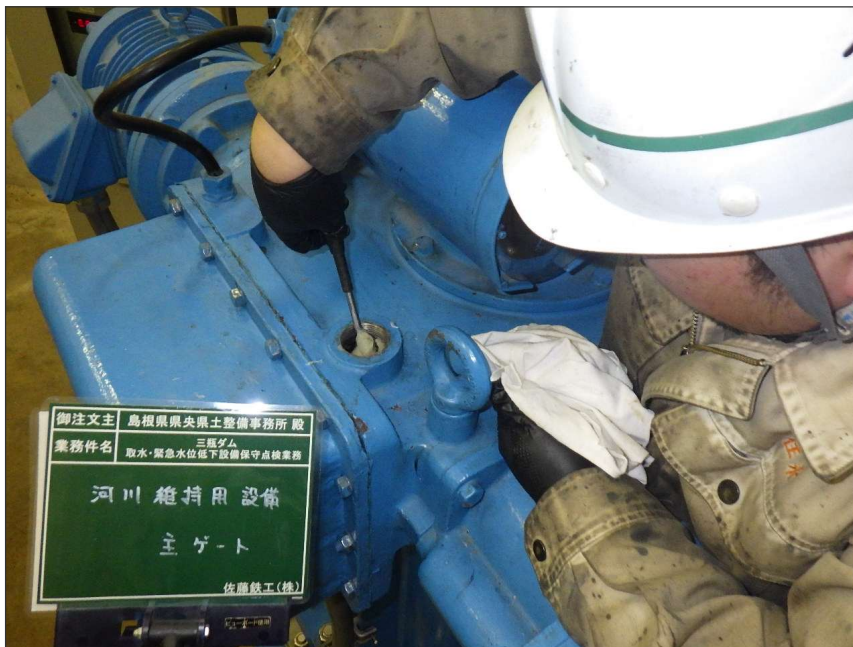
写真区分: 施工状況写真 工種: 河川維持用放流設備 種別: 主ゲート 細別: 開閉装置 写真タイトル: 内部状態確認 撮影箇所: バルブコントロール内
