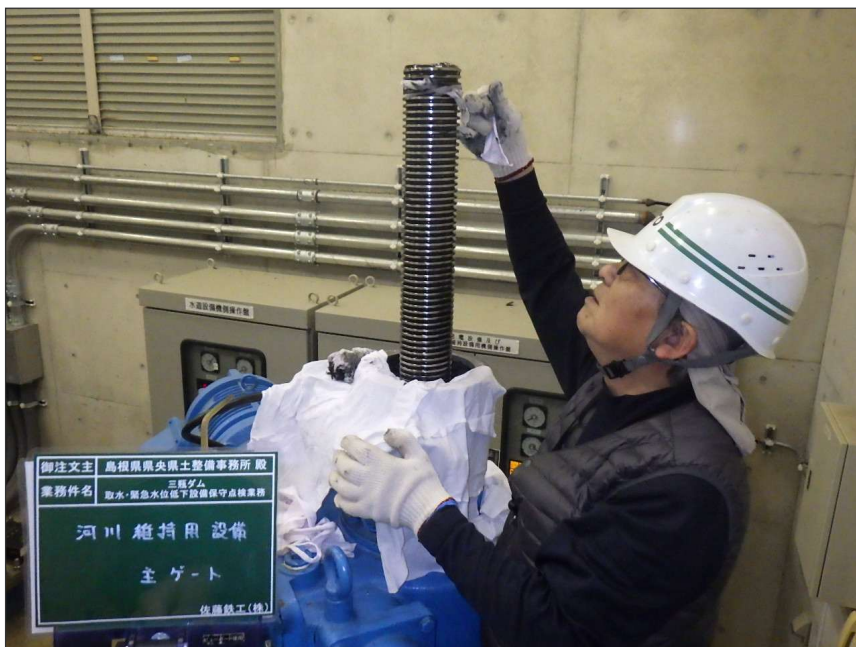
写真区分: 施工状況写真 工種: 河川維持用放流設備 種別: 主ゲート 細別: 開閉装置 写真タイトル: 清掃状況 撮影箇所: スピンドル
