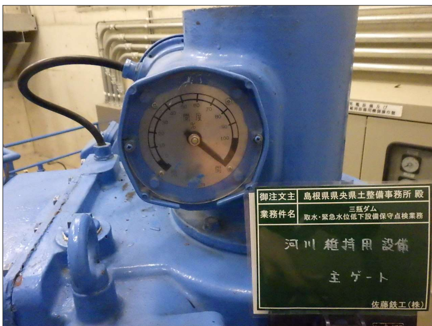
写真区分: 施工状況写真 工種: 河川維持用放流設備 種別: 主ゲート 細別: 開閉装置 写真タイトル: 全開確認 撮影箇所: 開度計
