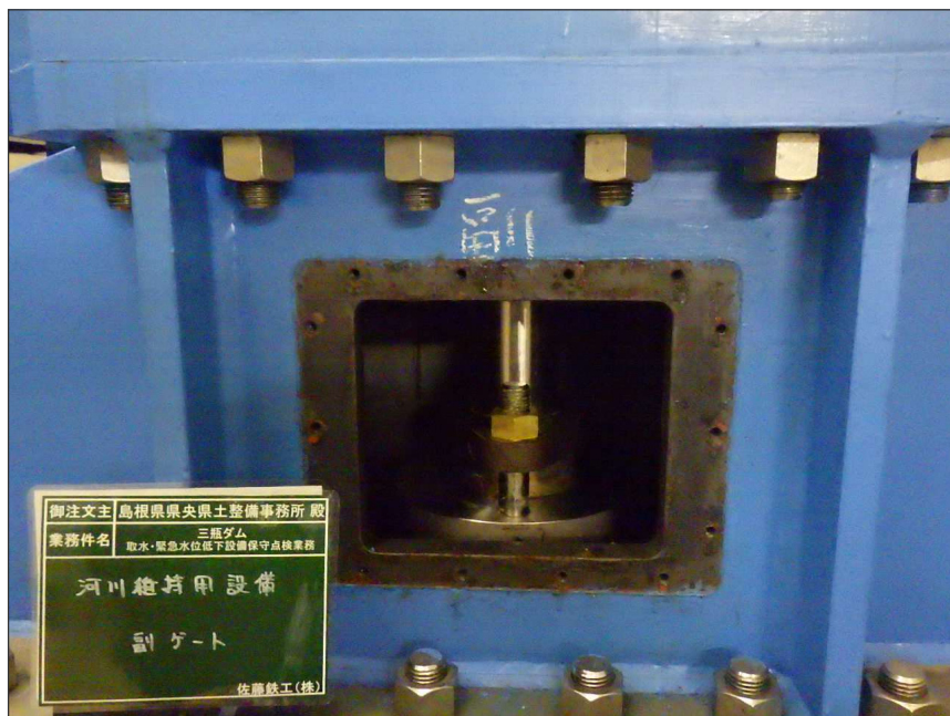
写真区分: 施工状況写真 工種: 河川維持用放流設備 種別: 副バルブ 細別: 開閉装置 写真タイトル: 清掃前 撮影箇所: シリンダーロッド
