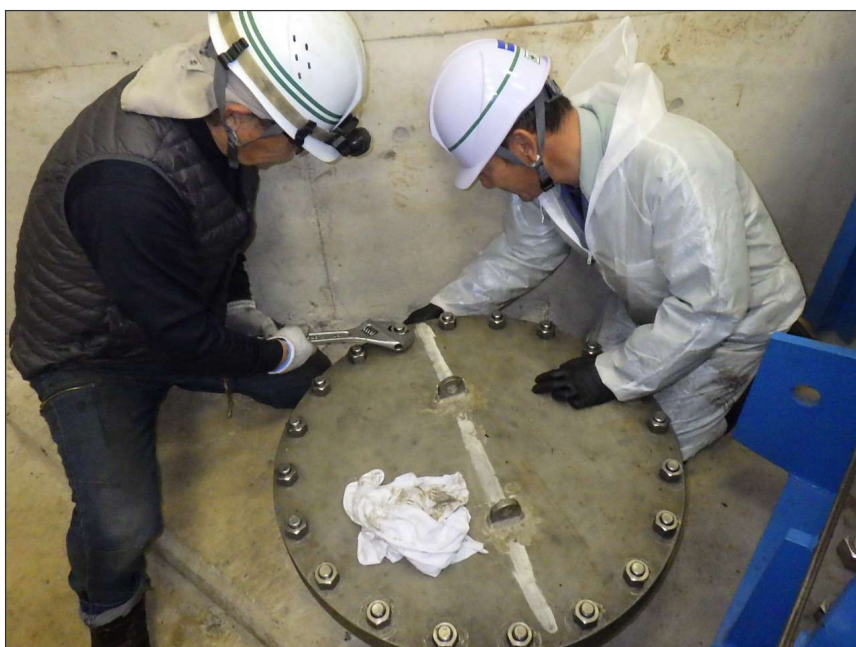
写真区分: 施工状況写真 工種: 河川維持用放流設備 種別: 主ゲート 細別: 扉体 写真タイトル: ボルト緩み点 検状況 撮影箇所: 点検口
