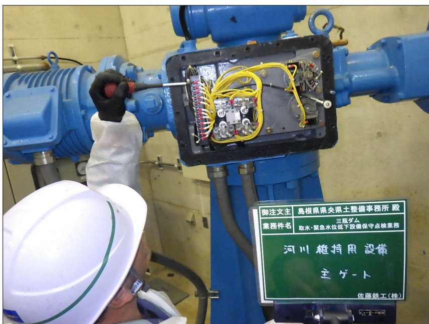
写真区分: 施工状況写真 工種: 河川維持用放流設備 種別: 主ゲート 細別: 開閉装置 写真タイトル: 端子緩み点検 状況 撮影箇所: 制限開閉器
