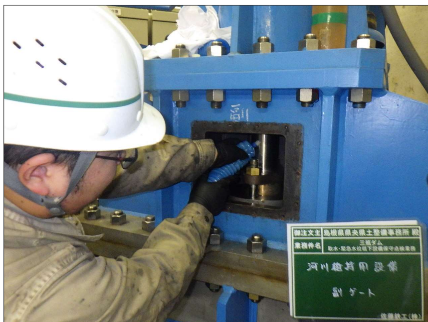
写真区分: 施工状況写真 工種: 河川維持用放流設備 種別: 副バルブ 細別: 開閉装置 写真タイトル: 給脂状況 撮影箇所: シリンダーロッド
