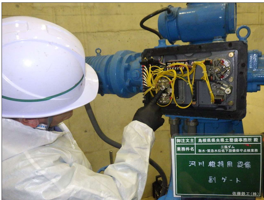
写真区分: 施工状況写真 工種: 河川維持用放流設備 種別: 副バルブ 細別: 開閉装置 写真タイトル: 外観点検状況 撮影箇所: 制限開閉器
