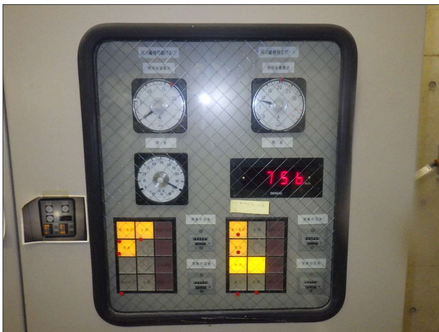
写真区分: 施工状況写真 工種: 河川維持用放流設備 種別: 主ゲート 細別: 開閉装置 写真タイトル: 管理運転状況 撮影箇所: 機側操作盤
