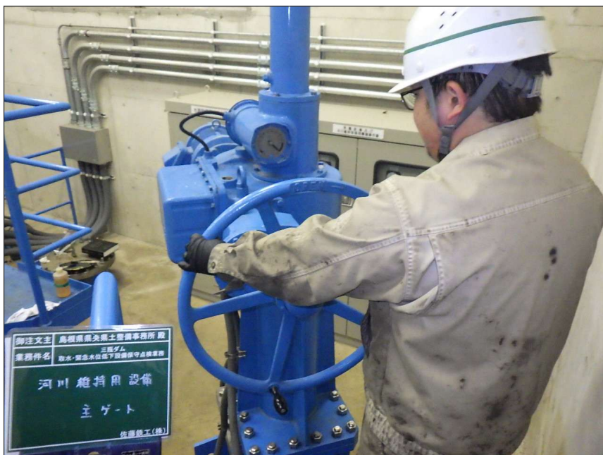
写真区分: 施工状況写真 工種: 河川維持用放流設備 種別: 主ゲート 細別: 開閉装置 写真タイトル: 機能確認 撮影箇所: 手動ハンドル
