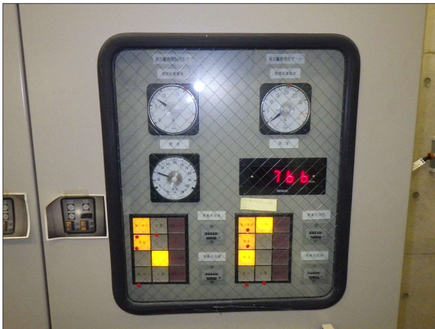
写真区分: 施工状況写真 工種: 河川維持用放流設備 種別: 副バルブ 細別: 開閉装置 写真タイトル: 管理運転状況 撮影箇所: 機側操作盤
