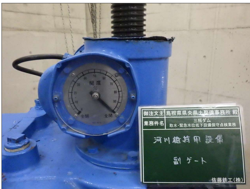
写真区分: 施工状況写真 工種: 河川維持用放流設備 種別: 副バルブ 細別: 開閉装置 写真タイトル: 全開確認 撮影箇所: 開度計
