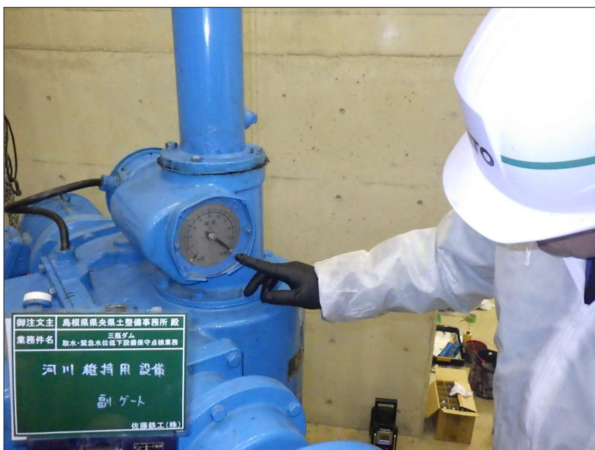
写真区分: 施工状況写真 工種: 河川維持用放流設備 種別: 副バルブ 細別: 開閉装置 写真タイトル: 外観点検状況 撮影箇所: 開度計
