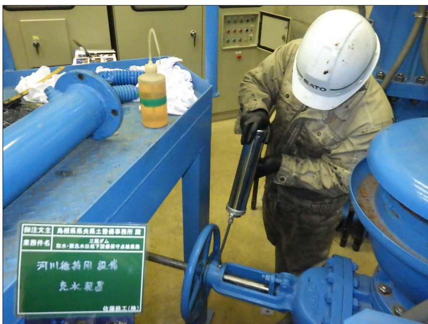
写真区分: 施工状況写真 工種: 河川維持用放流設備 種別: 充水装置 写真タイトル: 給脂状況 撮影箇所: バルブハンドル
