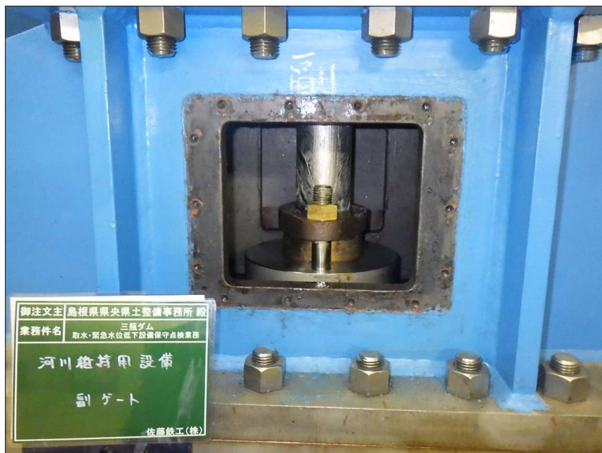
写真区分: 施工状況写真 工種: 河川維持用放流設備 種別: 副バルブ 細別: 開閉装置 写真タイトル: 給脂完了 撮影箇所: シリンダーロッド
