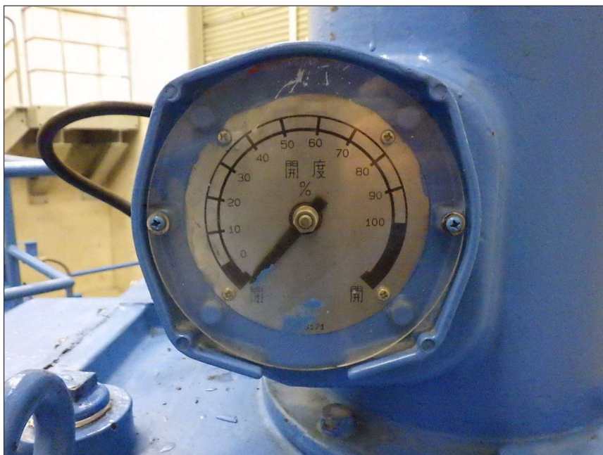
写真区分: 施工状況写真 工種: 河川維持用放流設備 種別: 主ゲート 細別: 開閉装置 写真タイトル: 全閉確認 撮影箇所: 開度計
