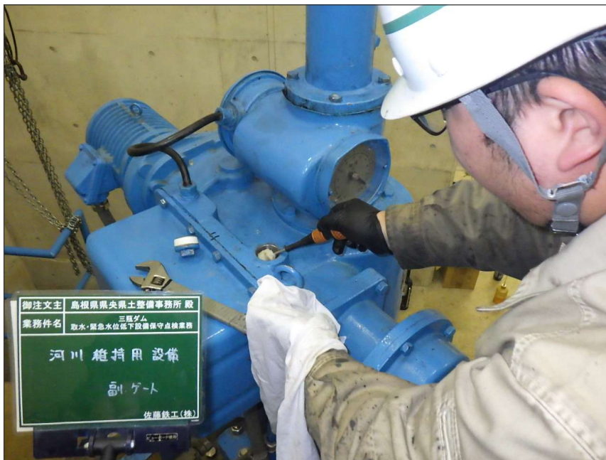
写真区分: 施工状況写真 工種: 河川維持用放流設備 種別: 副バルブ 細別: 開閉装置 写真タイトル: 内部状態確認 撮影箇所: バルブコントロール内
