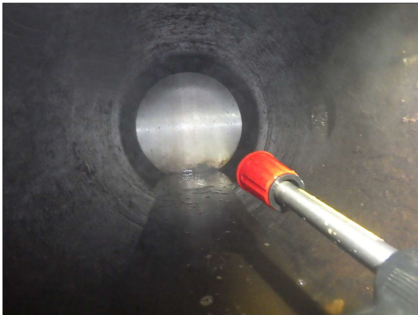
写真区分: 施工状況写真 工種: 河川維持用放流設備 種別: 主ゲート 細別: 扉体 写真タイトル: 清掃状況 撮影箇所: スキンプレート
