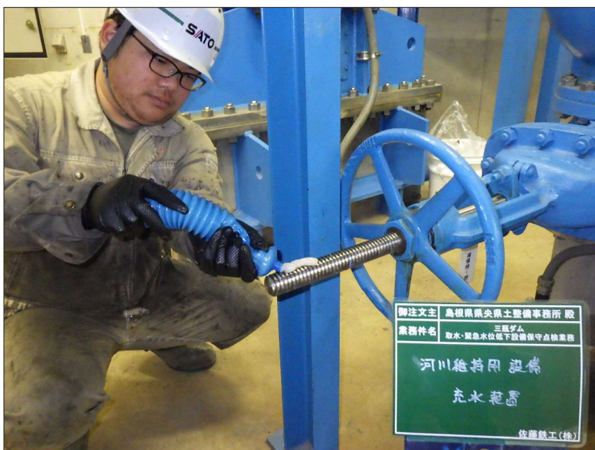
写真区分: 施工状況写真 工種: 河川維持用放流設備 種別: 充水装置 写真タイトル: 給脂状況 撮影箇所: スピンドル
