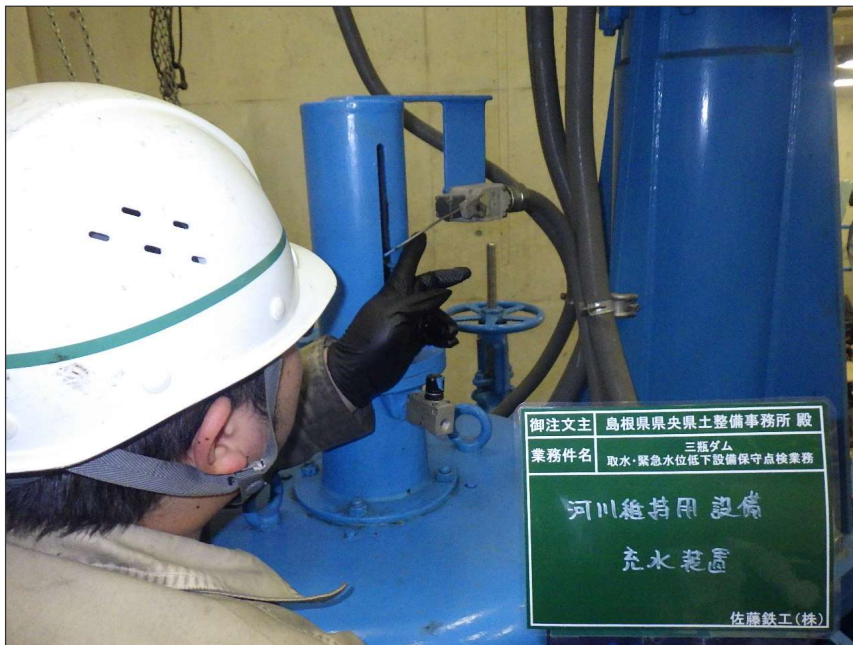
写真区分: 施工状況写真 工種: 河川維持用放流設備 種別: 充水装置 写真タイトル: 機能確認 撮影箇所: リミットスイッチ
