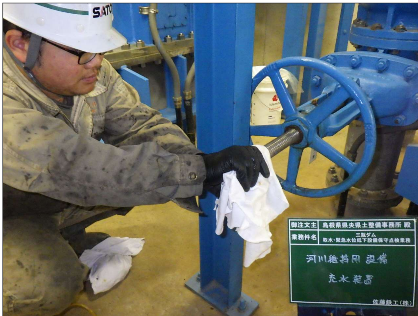
写真区分: 施工状況写真 工種: 河川維持用放流設備 種別: 充水装置 写真タイトル: 清掃状況 撮影箇所: スピンドル
