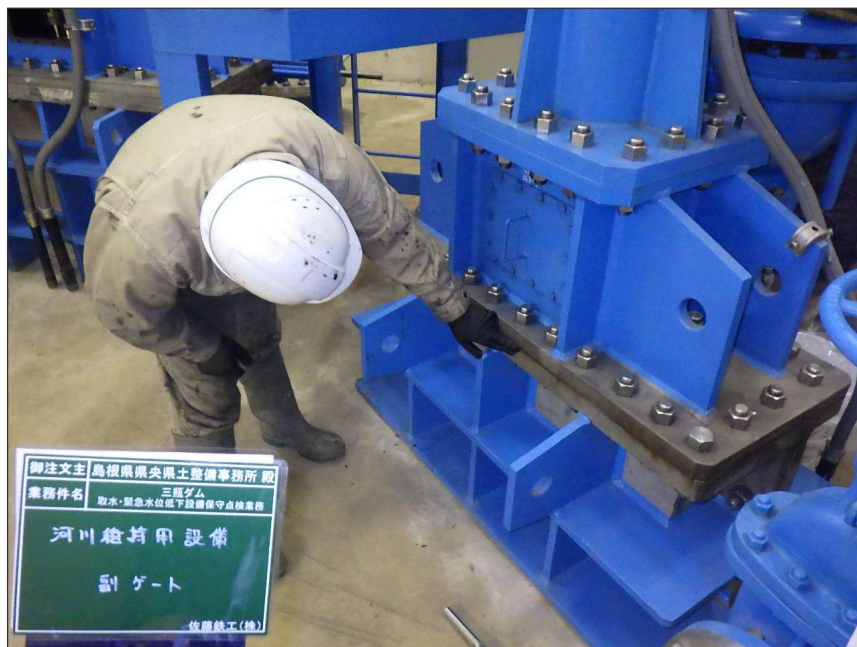
写真区分: 施工状況写真 工種: 河川維持用放流設備 種別: 副バルブ 細別: 開閉装置 写真タイトル: 外観点検状況 撮影箇所: ボンネット
