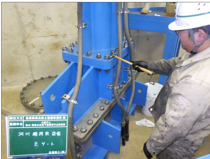
写真区分: 施工状況写真 工種: 河川維持用放流設備 種別: 主ゲート 細別: 開閉装置 写真タイトル: ボルト緩み点 検状況 撮影箇所: ボンネット
