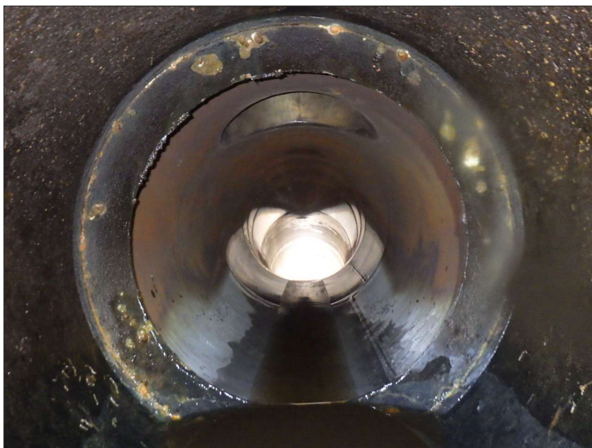
写真区分: 施工状況写真 工種: 河川維持用放流設備 種別: 主ゲート 細別: 扉体 写真タイトル: 外観点検状況 撮影箇所: シールリング・戸 当り
