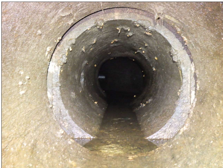
写真区分: 施工状況写真 工種: 河川維持用放流設備 種別: 副バルブ 細別: 扉体 写真タイトル: 外観点検状況 撮影箇所: シールリング・戸 当り
