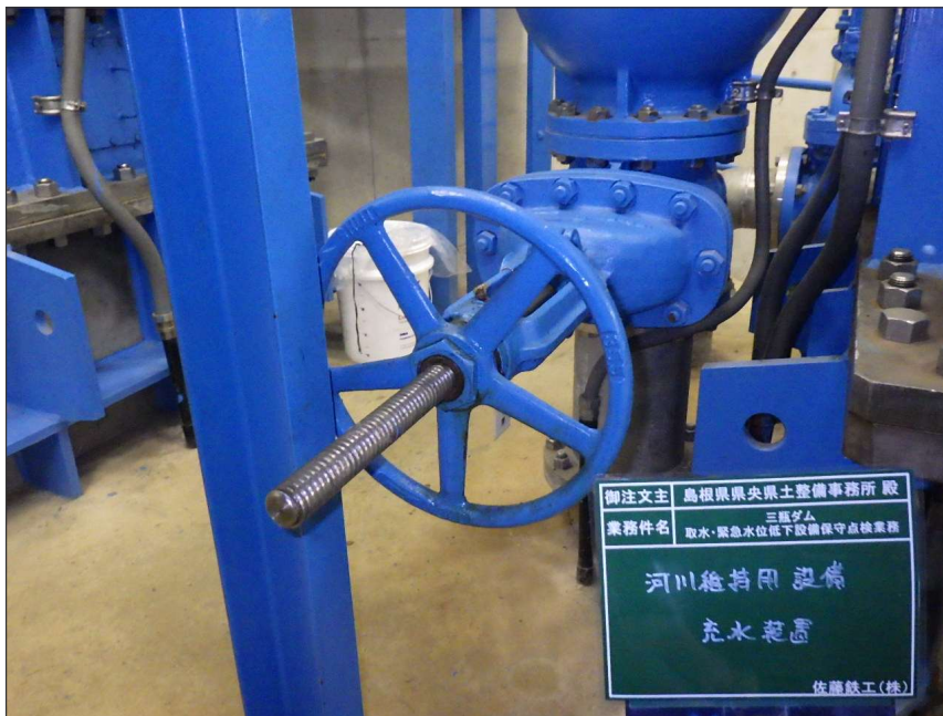
写真区分: 施工状況写真 工種: 河川維持用放流設備 種別: 充水装置 写真タイトル: 清掃前 撮影箇所: スピンドル
