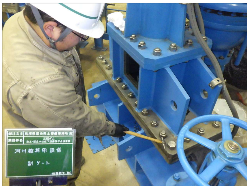
写真区分: 施工状況写真 工種: 河川維持用放流設備 種別: 副バルブ 細別: 開閉装置 写真タイトル: ボルト緩み点 検状況 撮影箇所: ボンネット
