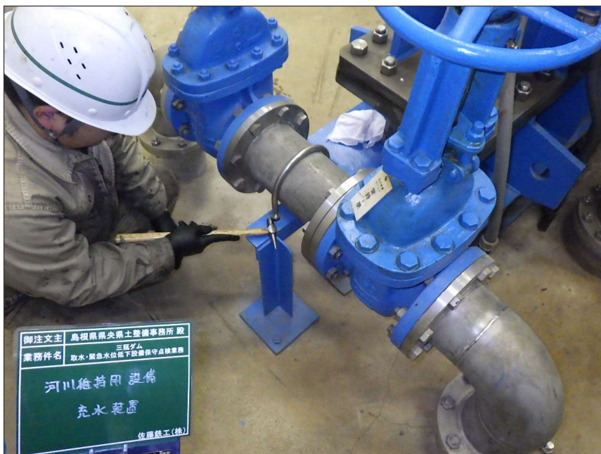
写真区分: 施工状況写真 工種: 河川維持用放流設備 種別: 充水装置 写真タイトル: ボルト緩み点 検状況 撮影箇所: 充水管架台
