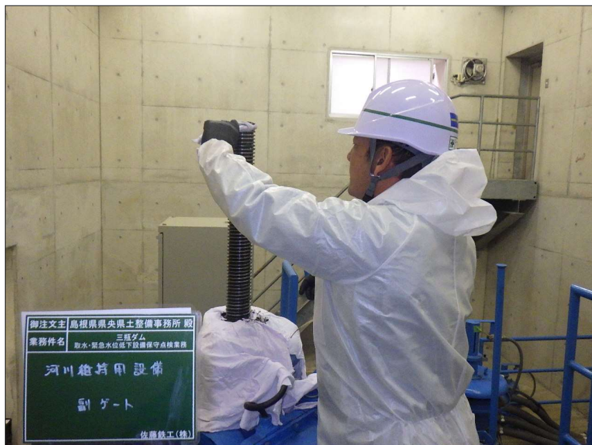
写真区分: 施工状況写真 工種: 河川維持用放流設備 種別: 副バルブ 細別: 開閉装置 写真タイトル: 清掃状況 撮影箇所: スピンドル
