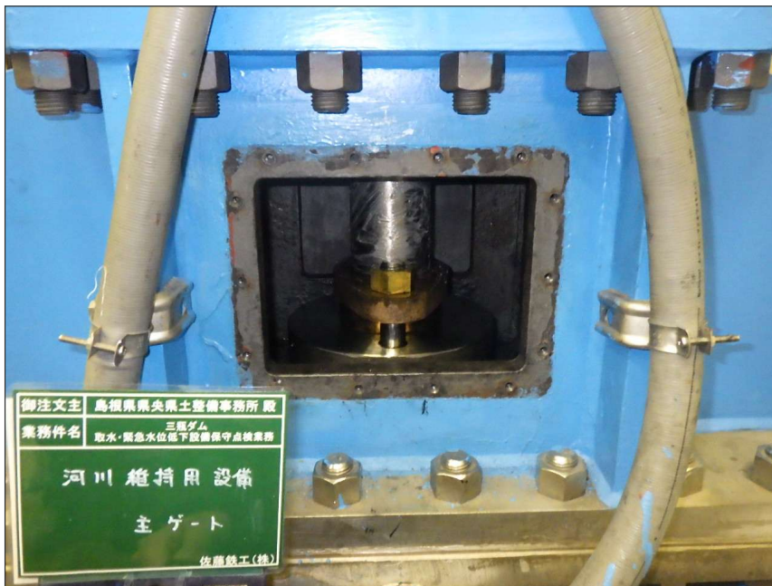
写真区分: 施工状況写真 工種: 河川維持用放流設備 種別: 主ゲート 細別: 開閉装置 写真タイトル: 給脂完了 撮影箇所: シリンダーロッド
