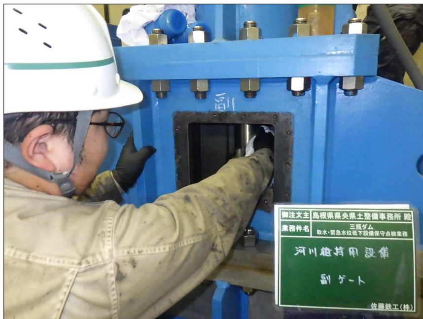
写真区分: 施工状況写真 工種: 河川維持用放流設備 種別: 副バルブ 細別: 開閉装置 写真タイトル: 清掃状況 撮影箇所: シリンダーロッド
