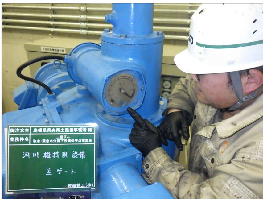
写真区分: 施工状況写真 工種: 河川維持用放流設備 種別: 主ゲート 細別: 開閉装置 写真タイトル: 外観点検状況 撮影箇所: 開度計
