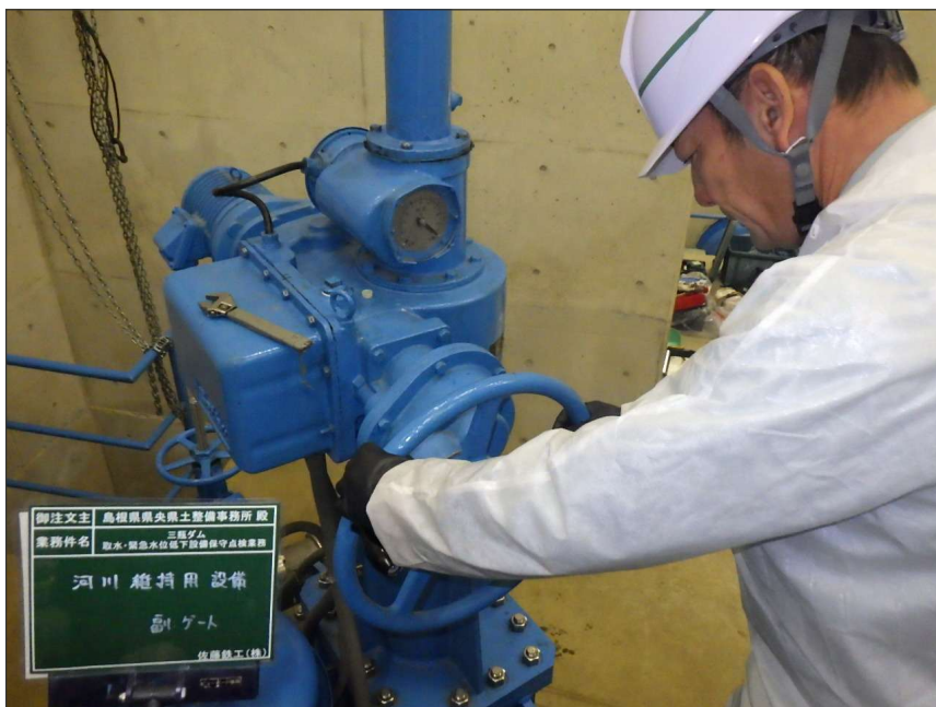
写真区分: 施工状況写真 工種: 河川維持用放流設備 種別: 副バルブ 細別: 開閉装置 写真タイトル: 機能確認 撮影箇所: 手動ハンドル
