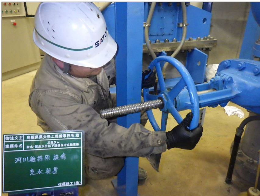
写真区分: 施工状況写真 工種: 河川維持用放流設備 種別: 充水装置 写真タイトル: 機能確認 撮影箇所: バルブハンドル
