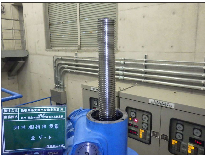
写真区分: 施工状況写真 工種: 河川維持用放流設備 種別: 主ゲート 細別: 開閉装置 写真タイトル: 清掃完了 撮影箇所: スピンドル
