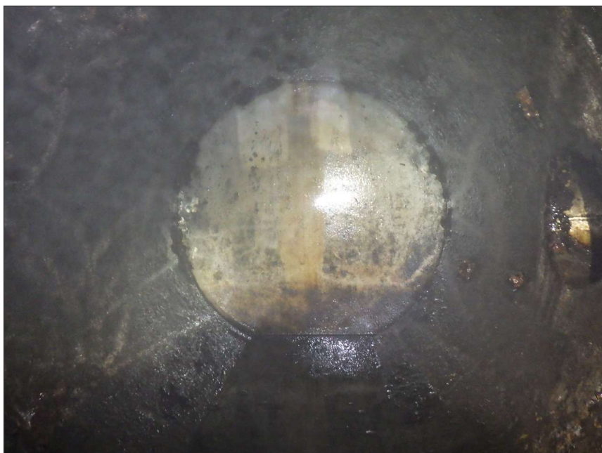
写真区分: 施工状況写真 工種: 河川維持用放流設備 種別: 副バルブ 細別: 扉体 写真タイトル: 清掃完了 撮影箇所: スキンプレート
