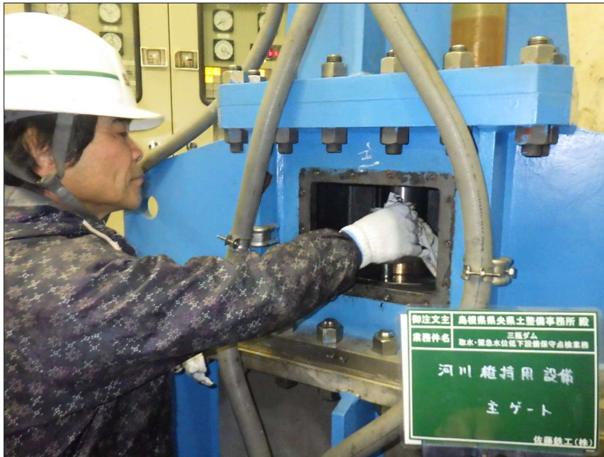
写真区分: 施工状況写真 工種: 河川維持用放流設備 種別: 主ゲート 細別: 開閉装置 写真タイトル: 清掃状況 撮影箇所: シリンダーロッド
