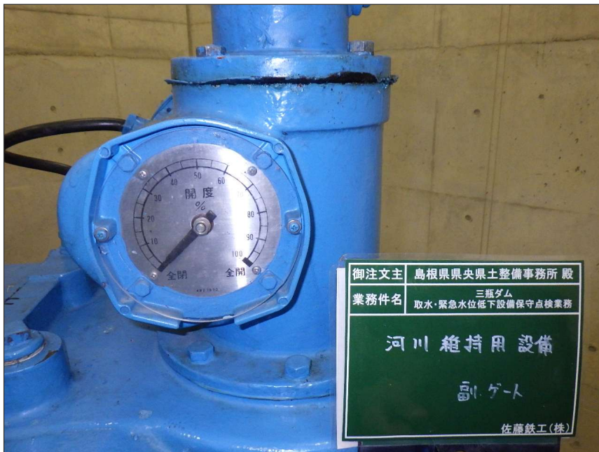
写真区分: 施工状況写真 工種: 河川維持用放流設備 種別: 副バルブ 細別: 開閉装置 写真タイトル: 全閉確認 撮影箇所: 開度計
