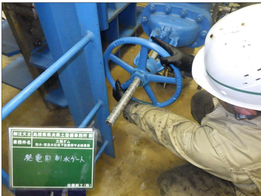
写真区分: 施工状況写真 工種: 発電用制水バルブ 種別: 充水装置 写真タイトル: 機能確認 撮影箇所: バルブハンドル
