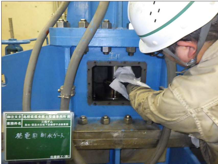
写真区分: 施工状況写真 工種: 発電用制水バルブ 種別: 開閉装置 写真タイトル: 清掃状況 撮影箇所: シリンダーロッド
