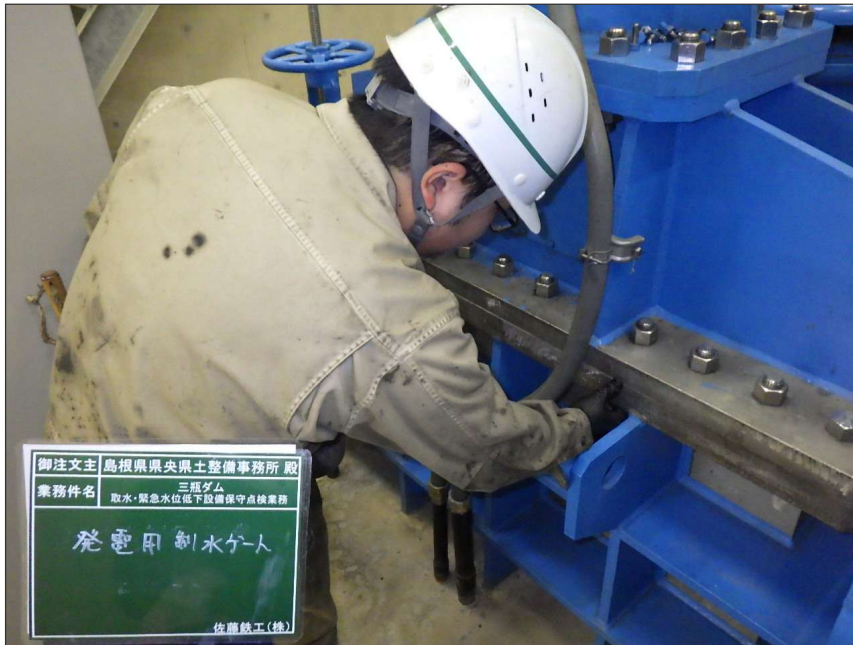
写真区分: 施工状況写真 工種: 発電用制水バルブ 種別: 開閉装置 写真タイトル: 外観点検状況 撮影箇所: ボンネット
