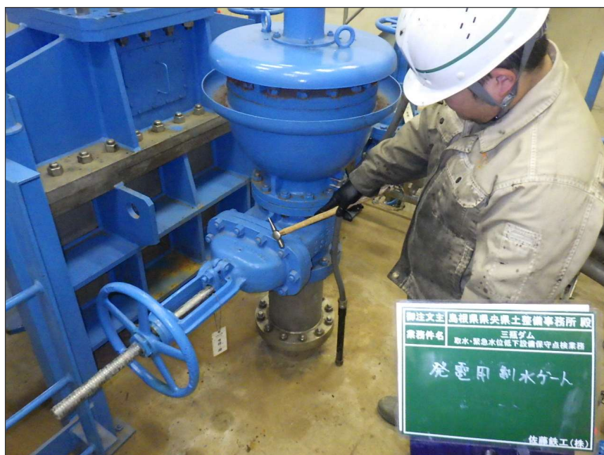
写真区分: 施工状況写真 工種: 発電用制水バルブ 種別: 充水装置 写真タイトル: ボルト緩み点 検状況 撮影箇所: 充水管
