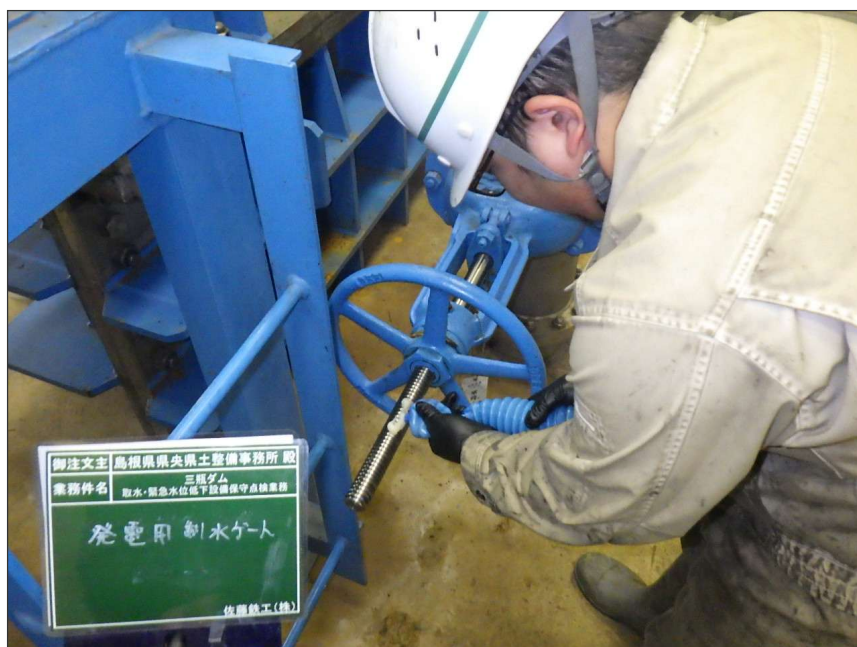
写真区分: 施工状況写真 工種: 発電用制水バルブ 種別: 充水装置 写真タイトル: 給脂状況 撮影箇所: スピンドル
