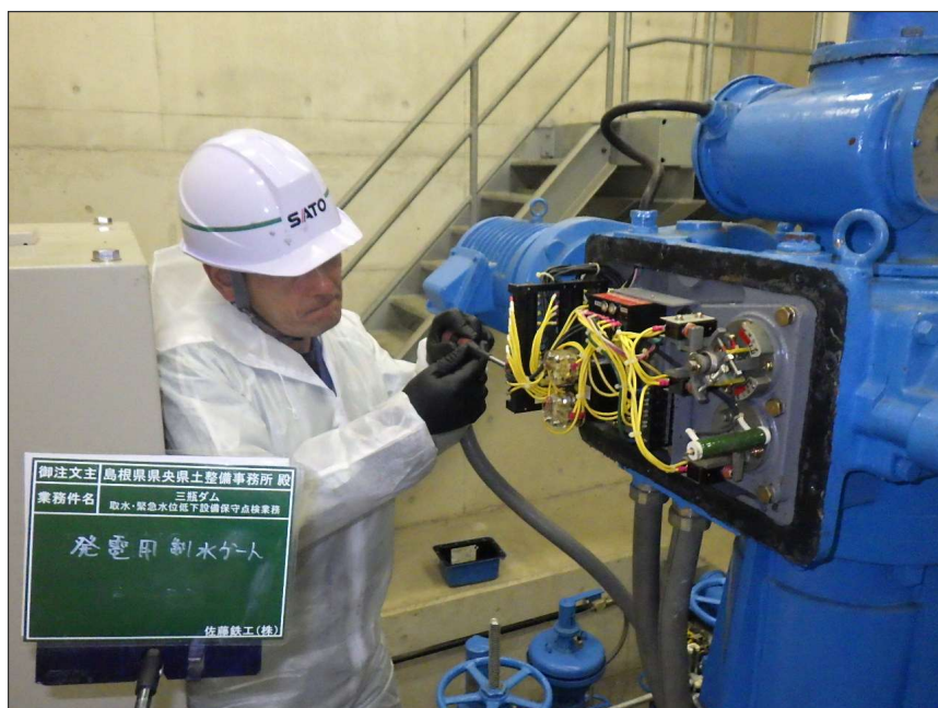
写真区分: 施工状況写真 工種: 発電用制水バルブ 種別: 開閉装置 写真タイトル: 端子緩み点検 状況 撮影箇所: 制限開閉器
