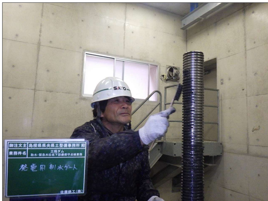
写真区分: 施工状況写真 工種: 発電用制水バルブ 種別: 開閉装置 写真タイトル: 給脂状況 撮影箇所: スピンドル
