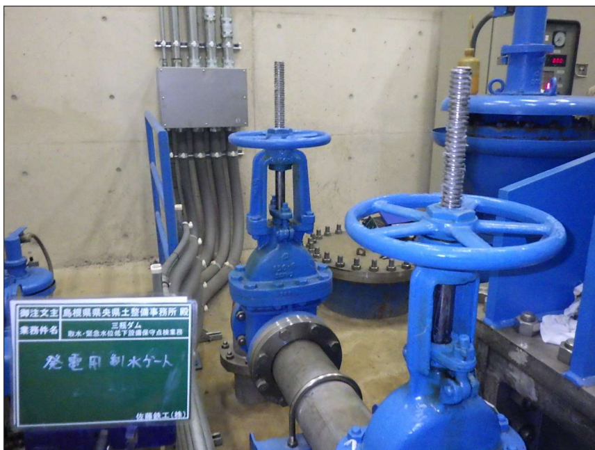
写真区分: 施工状況写真 工種: 発電用制水バルブ 種別: 充水装置 写真タイトル: 給脂完了 撮影箇所: スピンドル
