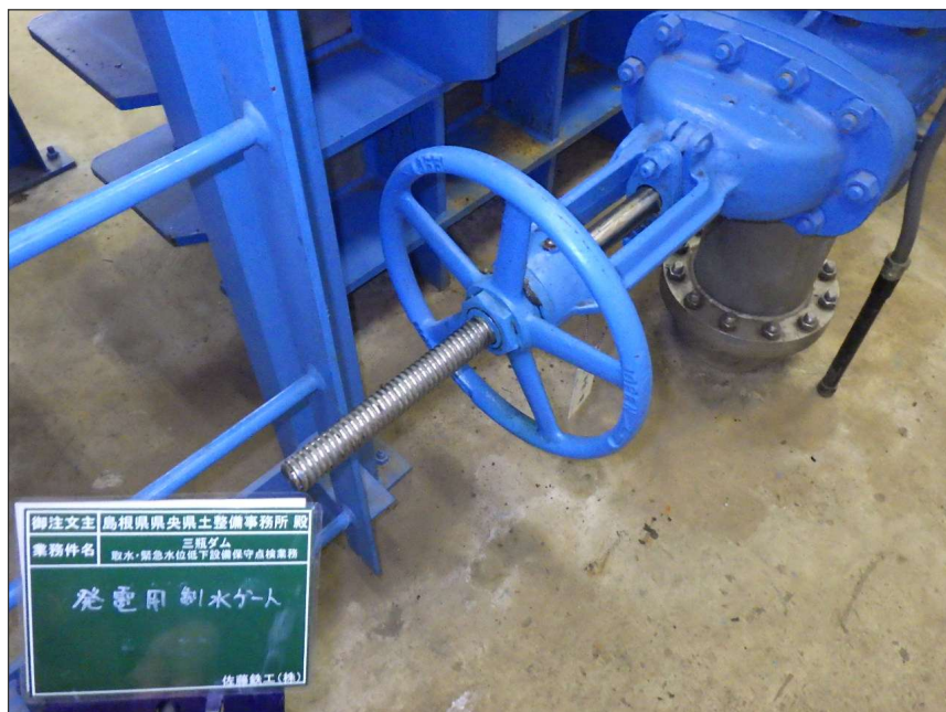
写真区分: 施工状況写真 工種: 発電用制水バルブ 種別: 充水装置 写真タイトル: 清掃前 撮影箇所: スピンドル
