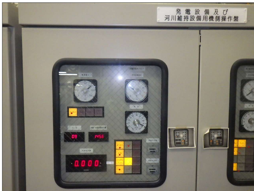
写真区分: 施工状況写真 工種: 発電用制水バルブ 種別: 開閉装置 写真タイトル: 管理運転状況 撮影箇所: 機側操作盤
