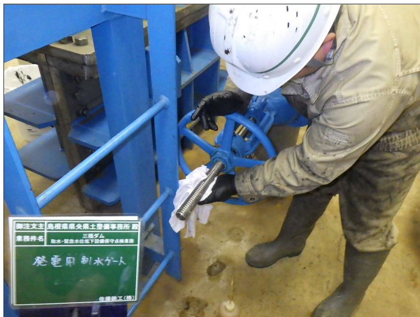
写真区分: 施工状況写真 工種: 発電用制水バルブ 種別: 充水装置 写真タイトル: 清掃状況 撮影箇所: スピンドル
