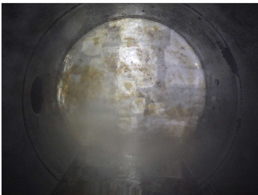
写真区分: 施工状況写真 工種: 発電用制水バルブ 種別: 扉体 写真タイトル: 清掃完了 撮影箇所: スキンプレート
