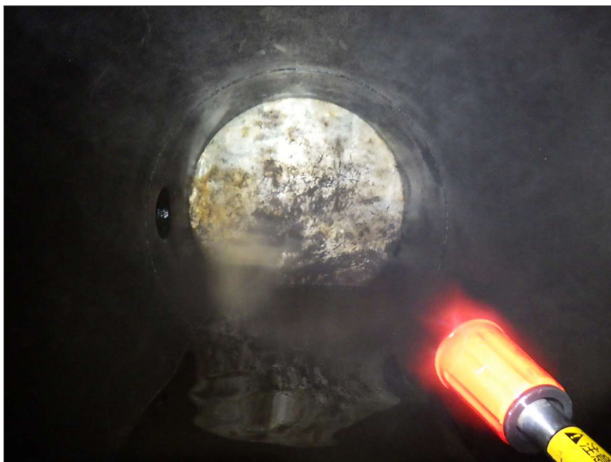
写真区分: 施工状況写真 工種: 発電用制水バルブ 種別: 扉体 写真タイトル: 清掃状況 撮影箇所: スキンプレート
