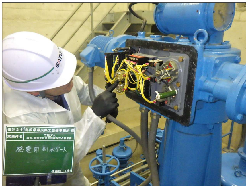
写真区分: 施工状況写真 工種: 発電用制水バルブ 種別: 開閉装置 写真タイトル: 外観点検状況 撮影箇所: 制限開閉器
