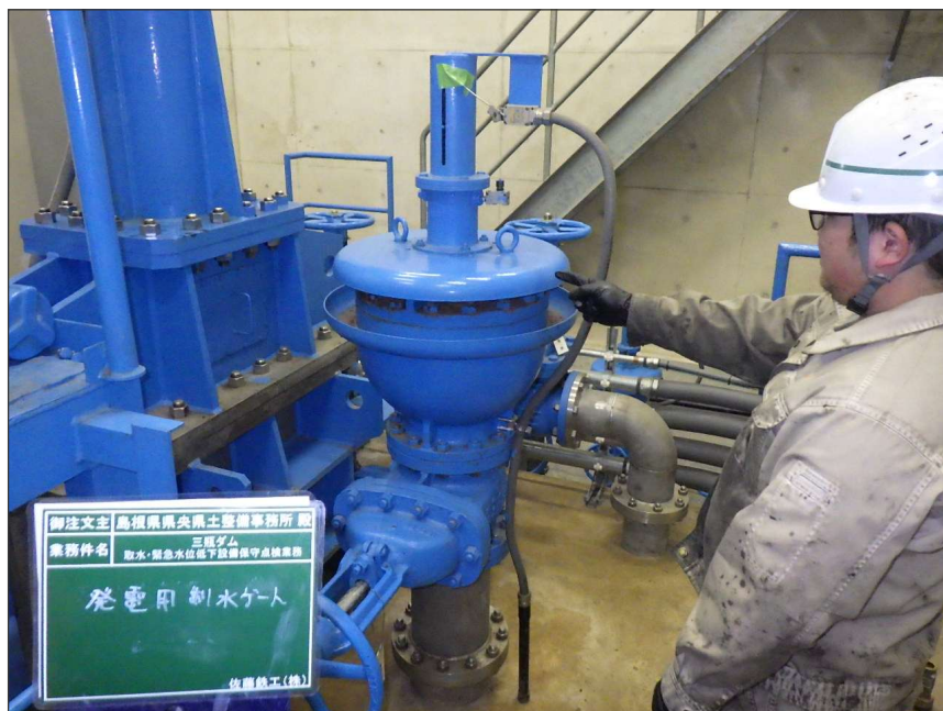
写真区分: 施工状況写真 工種: 発電用制水バルブ 種別: 充水装置 写真タイトル: 外観点検状況 撮影箇所: 充水管
