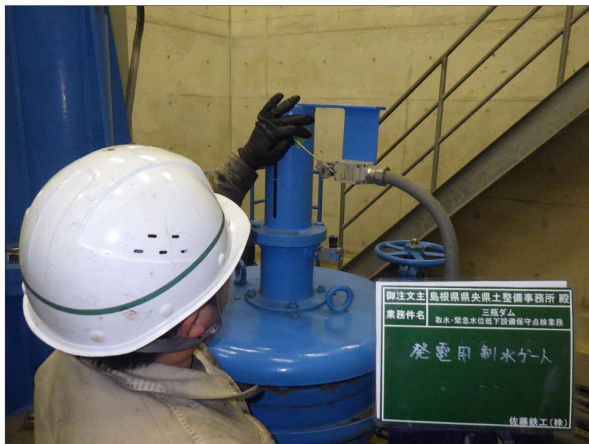
写真区分: 施工状況写真 工種: 発電用制水バルブ 種別: 充水装置 写真タイトル: 機能確認 撮影箇所: リミットスイッチ
