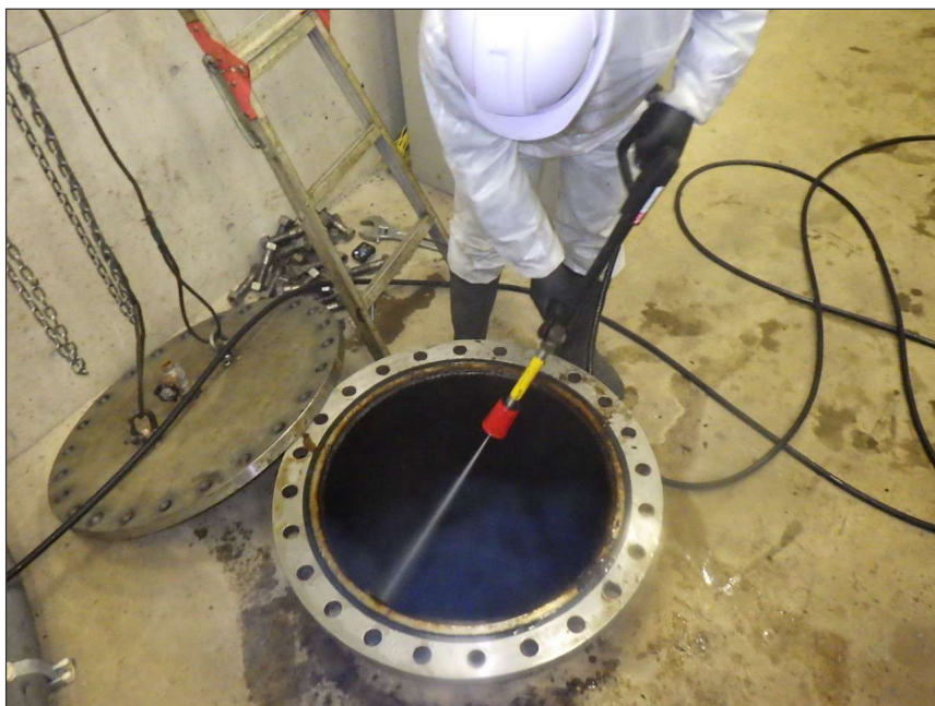
写真区分: 施工状況写真 工種: 発電用制水バルブ 種別: 扉体 写真タイトル: 清掃状況 撮影箇所: 点検口
