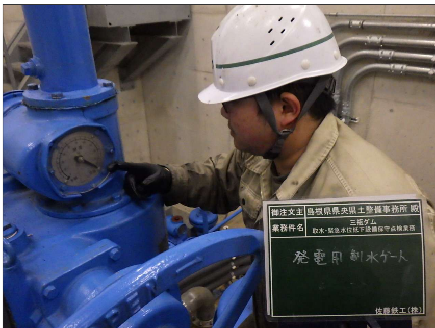
写真区分: 施工状況写真 工種: 発電用制水バルブ 種別: 開閉装置 写真タイトル: 外観点検状況 撮影箇所: 開度計
