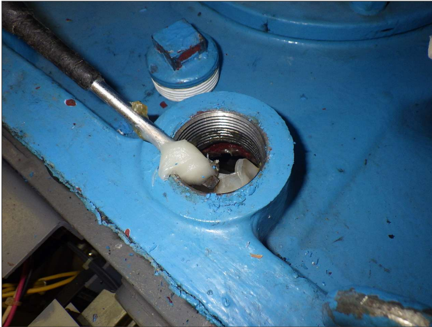
写真区分: 施工状況写真 工種: 発電用制水バルブ 種別: 開閉装置 写真タイトル: 内部状態確認 撮影箇所: バルブコントロール内
