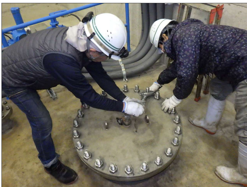
写真区分: 施工状況写真 工種: 発電用制水バルブ 種別: 扉体 写真タイトル: ボルト緩み点 検状況 撮影箇所: 点検口
