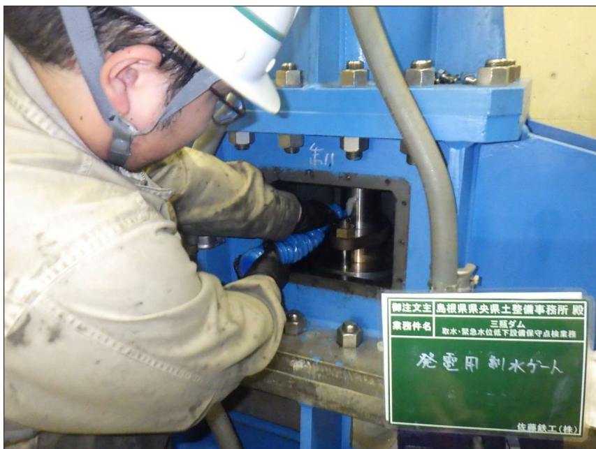
写真区分: 施工状況写真 工種: 発電用制水バルブ 種別: 開閉装置 写真タイトル: 給脂状況 撮影箇所: シリンダーロッド
