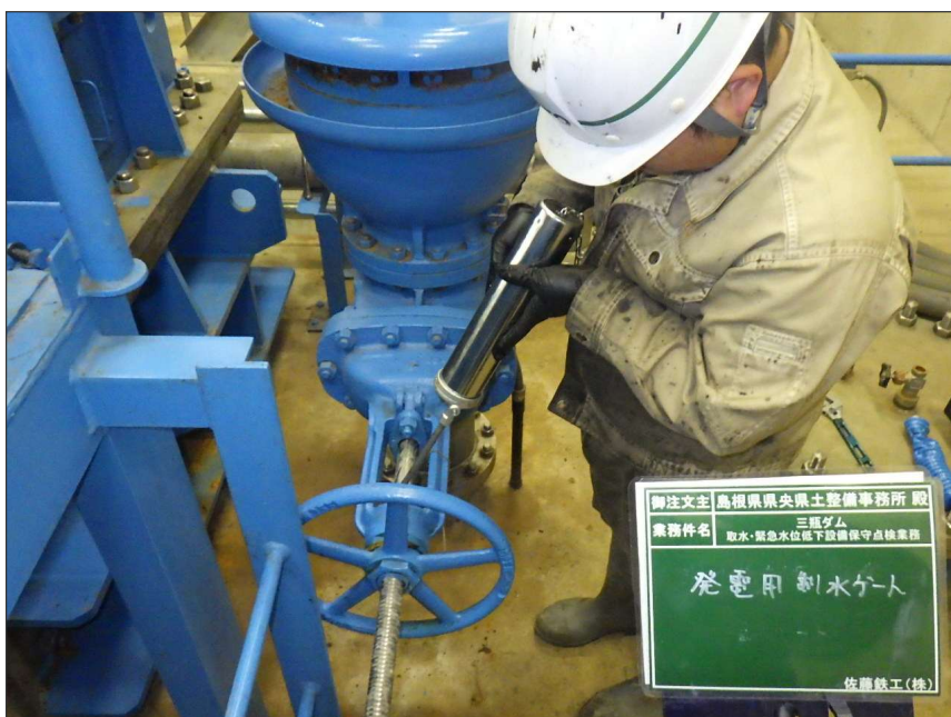
写真区分: 施工状況写真 工種: 発電用制水バルブ 種別: 充水装置 写真タイトル: 給脂状況 撮影箇所: バルブハンドル
