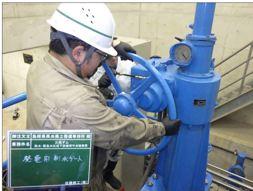
写真区分: 施工状況写真 工種: 発電用制水バルブ 種別: 開閉装置 写真タイトル: 機能確認 撮影箇所: 手動ハンドル
