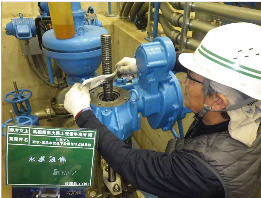
写真区分: 施工状況写真 工種: 水道設備 種別: 副バルブ 写真タイトル: 清掃状況 撮影箇所: スピンドル
