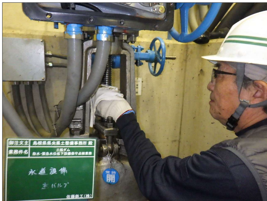
写真区分: 施工状況写真 工種: 水道設備 種別: 主バルブ 写真タイトル: 清掃状況 撮影箇所: スピンドル
