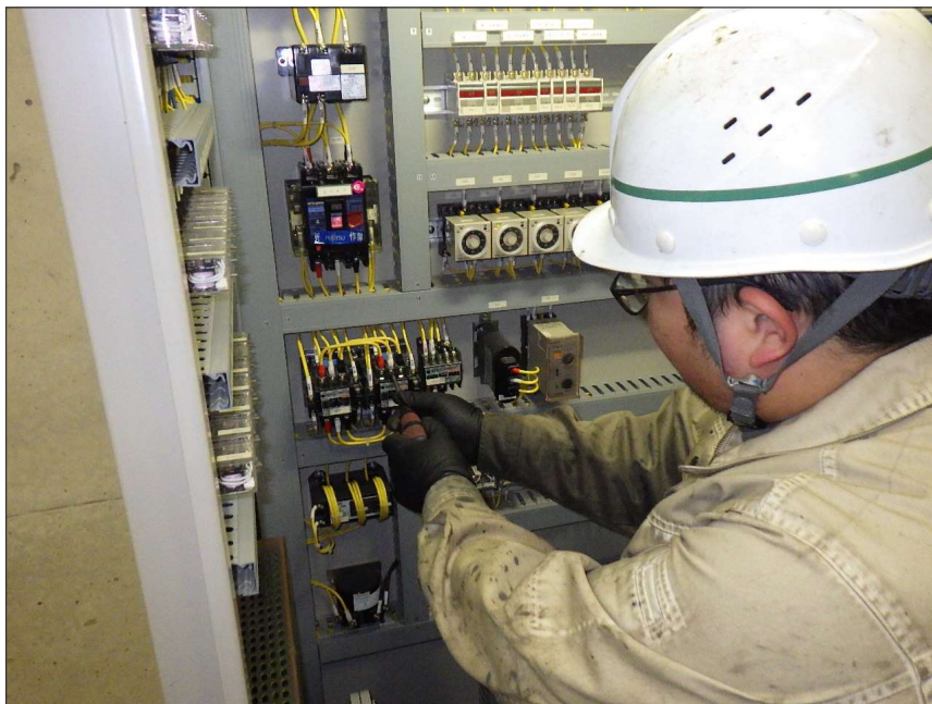
写真区分: 施工状況写真 工種: 水道設備 種別: 機側操作盤 写真タイトル: 端子緩み点検 状況 撮影箇所: 機側操作盤
