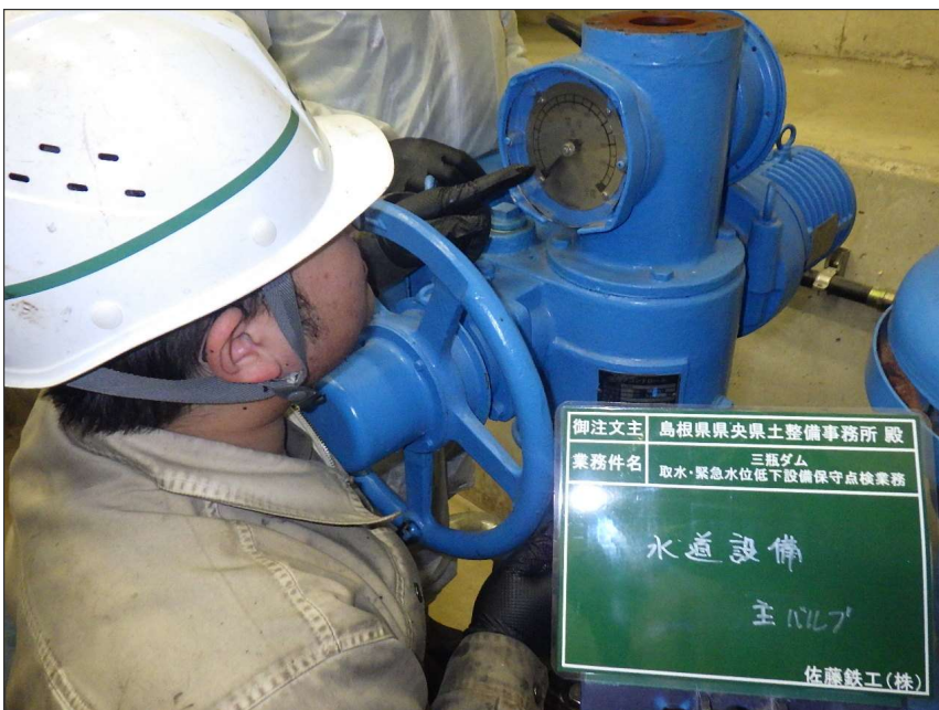
写真区分: 施工状況写真 工種: 水道設備 種別: 主バルブ 写真タイトル: 外観点検状況 撮影箇所: 開度計
