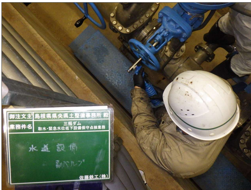
写真区分: 施工状況写真 工種: 水道設備 種別: 副バルブ 細別: 充水装置 写真タイトル: 給脂状況 撮影箇所: スピンドル
