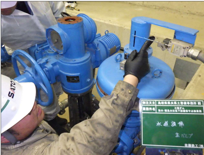
写真区分: 施工状況写真 工種: 水道設備 種別: 主バルブ 細別: 充水装置 写真タイトル: 機能確認 撮影箇所: リミットスイッチ
