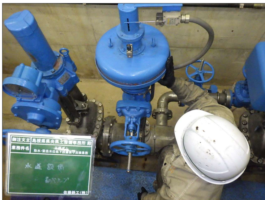
写真区分: 施工状況写真 工種: 水道設備 種別: 副バルブ 細別: 充水装置 写真タイトル: 外観点検状況 撮影箇所: 充水管
