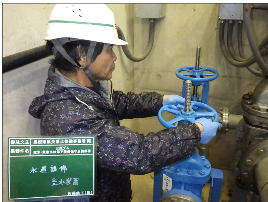
写真区分: 施工状況写真 工種: 水道設備 種別: 充水装置 写真タイトル: 機能確認 撮影箇所: バルブハンドル
