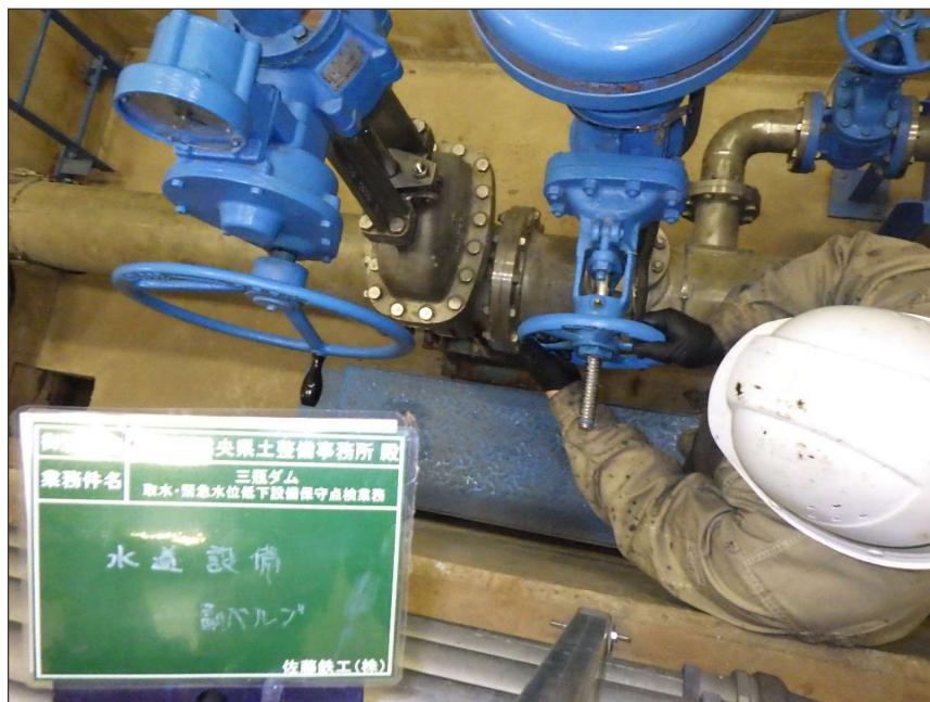
写真区分: 施工状況写真 工種: 水道設備 種別: 副バルブ 細別: 充水装置 写真タイトル: 機能確認 撮影箇所: バルブハンドル
