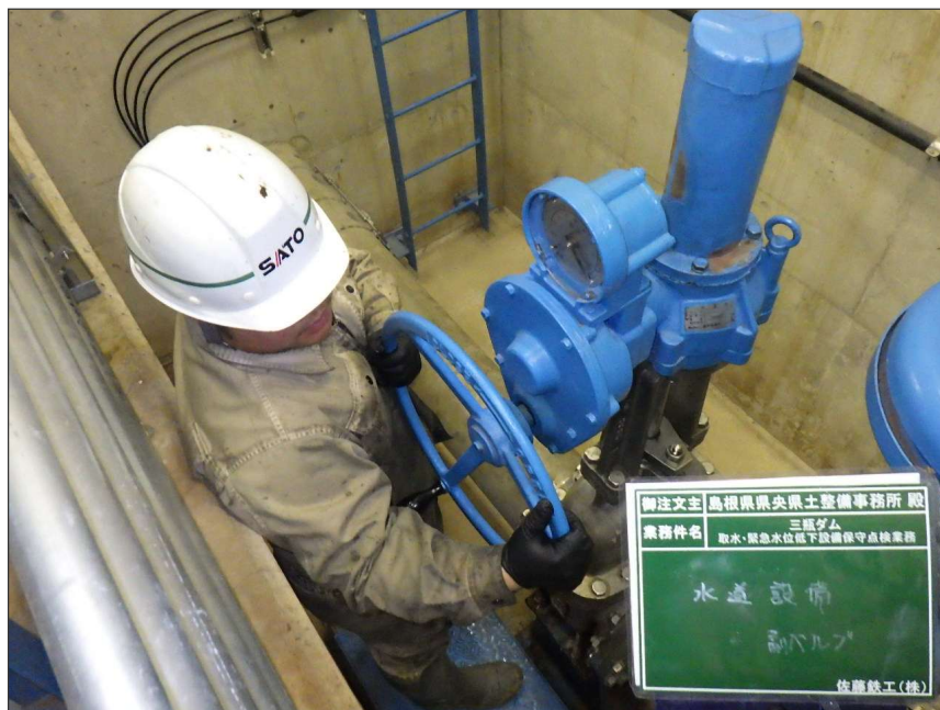
写真区分: 施工状況写真 工種: 水道設備 種別: 副バルブ 写真タイトル: 機能確認 撮影箇所: 手動ハンドル
