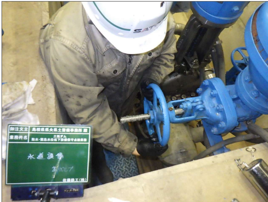
写真区分: 施工状況写真 工種: 水道設備 種別: 主バルブ 細別: 充水装置 写真タイトル: 機能確認 撮影箇所: バルブハンドル
