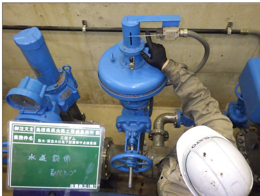
写真区分: 施工状況写真 工種: 水道設備 種別: 副バルブ 細別: 充水装置 写真タイトル: 機能確認 撮影箇所: リミットスイッチ
