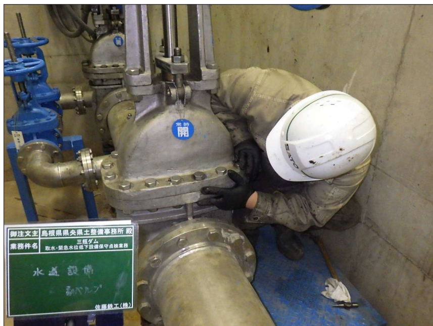
写真区分: 施工状況写真 工種: 水道設備 種別: 副バルブ 写真タイトル: 外観点検状況 撮影箇所: ボンネット
