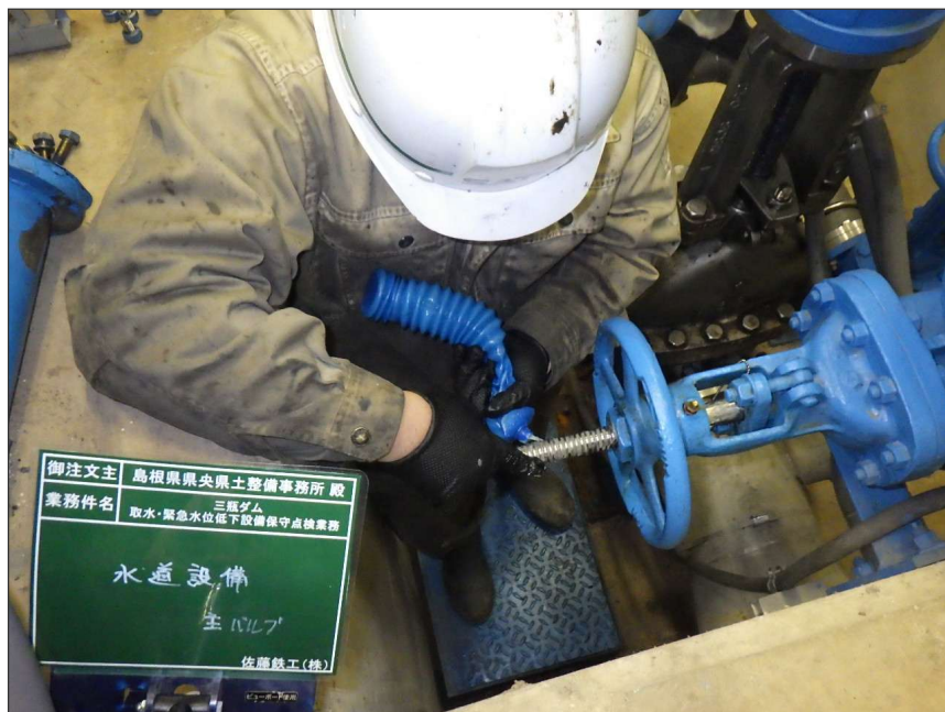
写真区分: 施工状況写真 工種: 水道設備 種別: 主バルブ 細別: 充水装置 写真タイトル: 給脂状況 撮影箇所: スピンドル
