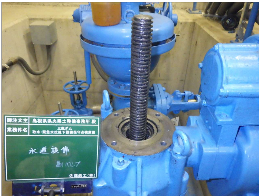
写真区分: 施工状況写真 工種: 水道設備 種別: 副バルブ 写真タイトル: 清掃前 撮影箇所: スピンドル
