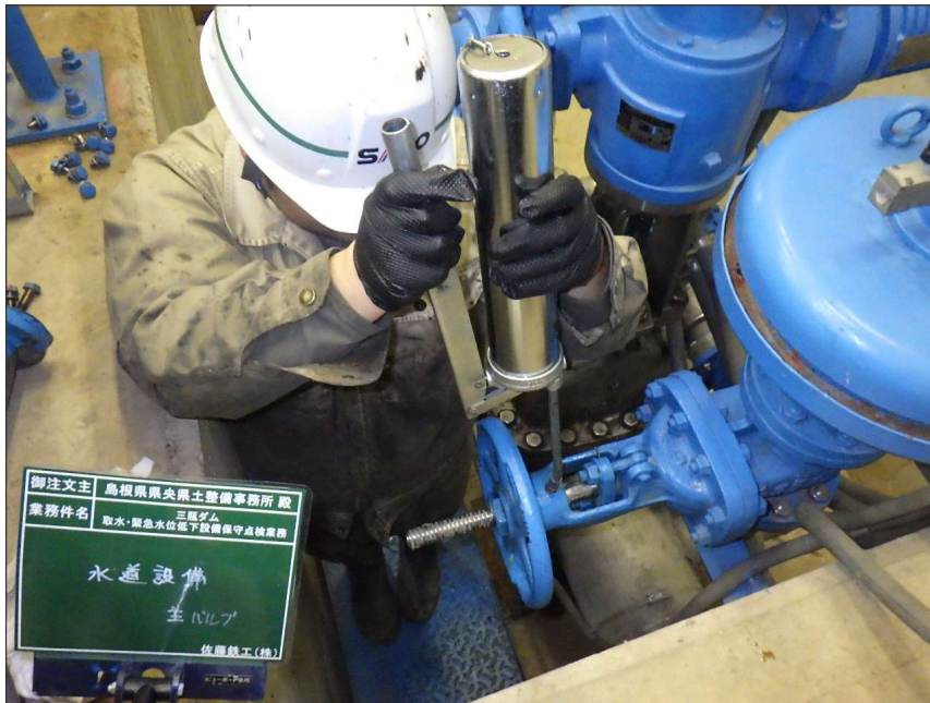
写真区分: 施工状況写真 工種: 水道設備 種別: 主バルブ 細別: 充水装置 写真タイトル: 給脂状況 撮影箇所: バルブハンドル
