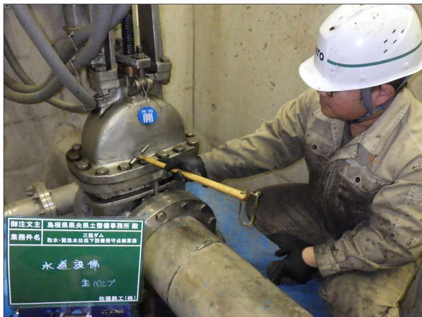
写真区分: 施工状況写真 工種: 水道設備 種別: 主バルブ 写真タイトル: ボルト緩み点 検状況 撮影箇所: ボンネット
