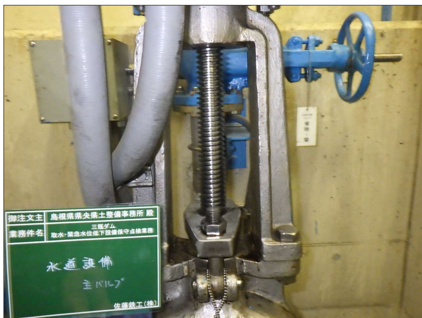
写真区分: 施工状況写真 工種: 水道設備 種別: 主バルブ 写真タイトル: 清掃完了 撮影箇所: スピンドル
