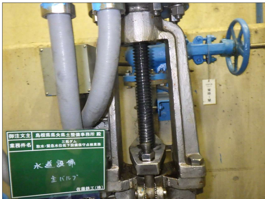
写真区分: 施工状況写真 工種: 水道設備 種別: 主バルブ 写真タイトル: 清掃前 撮影箇所: スピンドル
