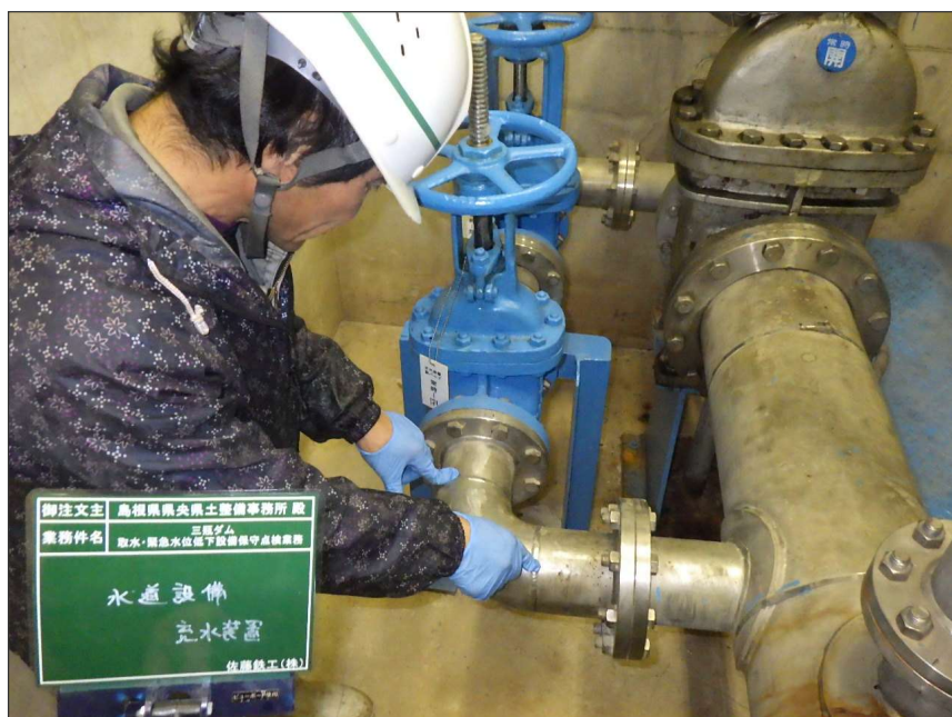
写真区分: 施工状況写真 工種: 水道設備 種別: 主バルブ 写真タイトル: 外観点検状況 撮影箇所: 取水管
