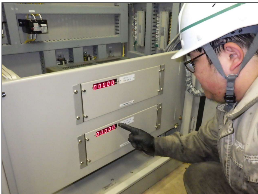
写真区分: 施工状況写真 工種: 水道設備 種別: 機側操作盤 写真タイトル: 外観点検状況 撮影箇所: 機側操作盤
