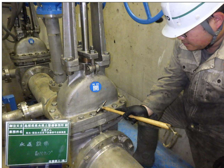
写真区分: 施工状況写真 工種: 水道設備 種別: 副バルブ 写真タイトル: ボルト緩み点 検状況 撮影箇所: ボンネット
