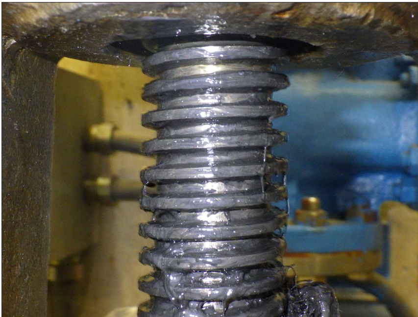
写真区分: 施工状況写真 工種: 水道設備 種別: 主バルブ 写真タイトル: 歯面確認 撮影箇所: スピンドル
