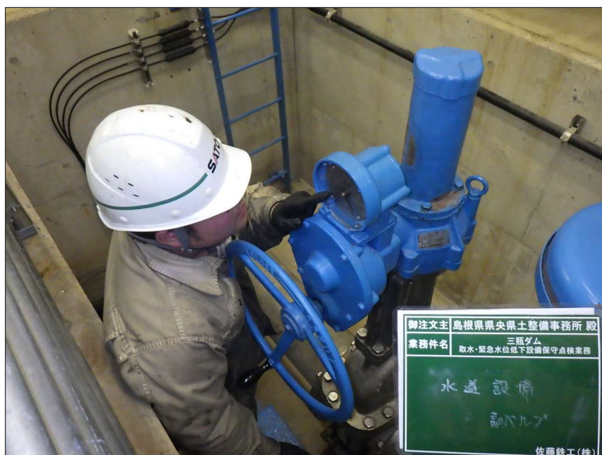
写真区分: 施工状況写真 工種: 水道設備 種別: 副バルブ 写真タイトル: 外観点検状況 撮影箇所: 開度計
