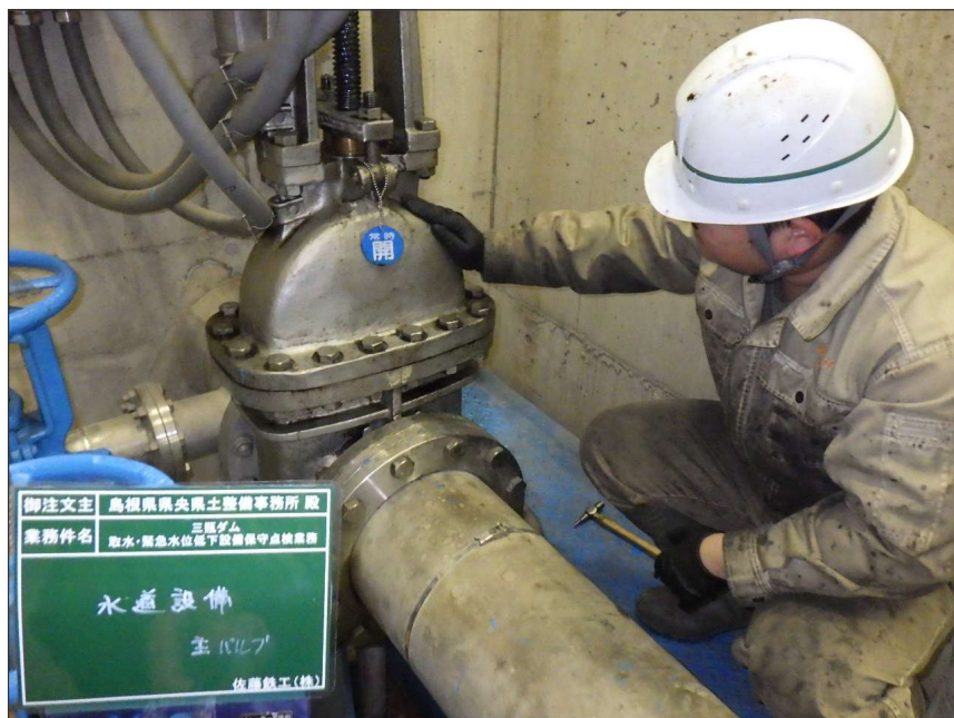
写真区分: 施工状況写真 工種: 水道設備 種別: 主バルブ 写真タイトル: 外観点検状況 撮影箇所: ボンネット
