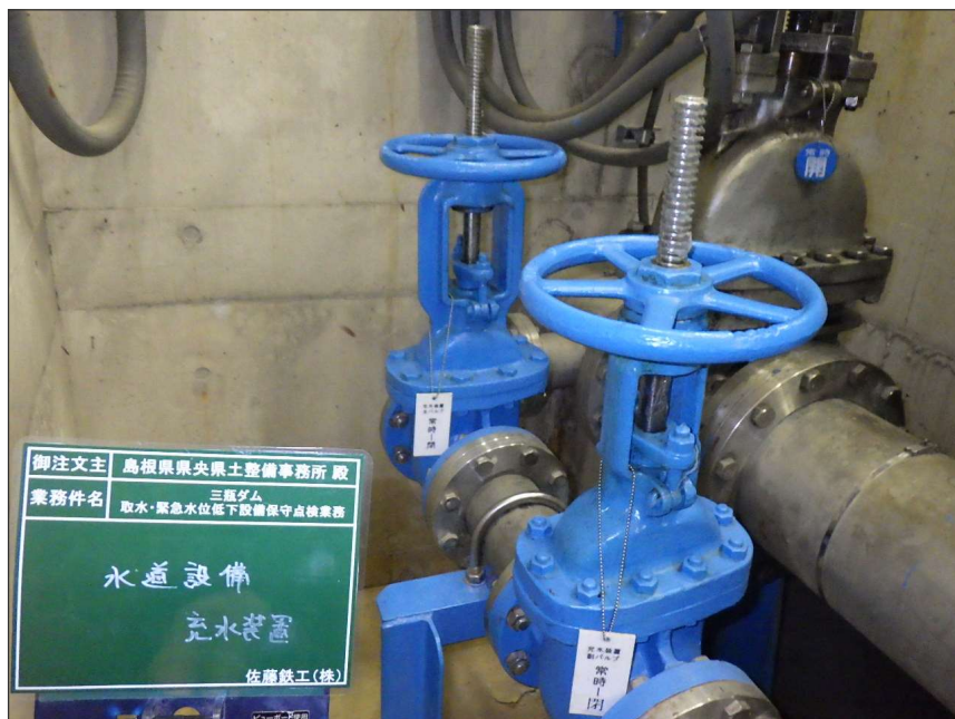
写真区分: 施工状況写真 工種: 水道設備 種別: 充水装置 写真タイトル: 給脂完了 撮影箇所: スピンドル
