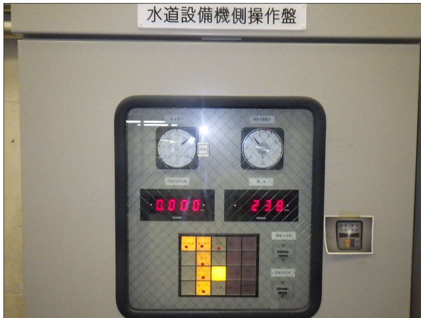
写真区分: 施工状況写真 工種: 水道設備 種別: 主バルブ 写真タイトル: 管理運転状況 撮影箇所: 機側操作盤
