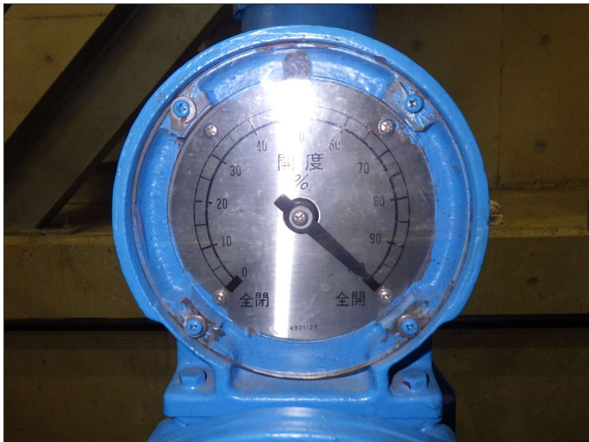
写真区分: 施工状況写真 工種: 水道設備 種別: 主バルブ 写真タイトル: 全開確認 撮影箇所: 開度計
