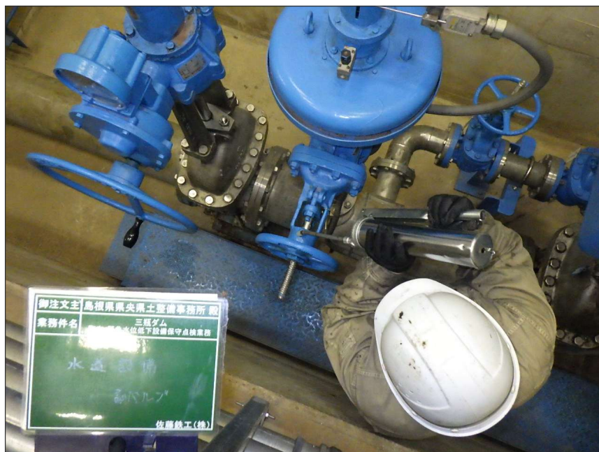
写真区分: 施工状況写真 工種: 水道設備 種別: 副バルブ 細別: 充水装置 写真タイトル: 給脂状況 撮影箇所: バルブハンドル
