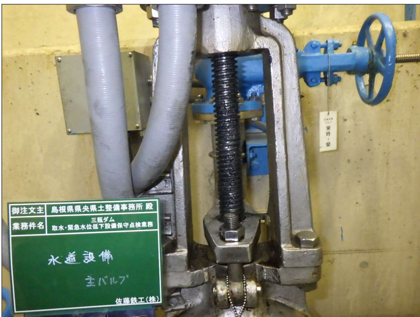
写真区分: 施工状況写真 工種: 水道設備 種別: 主バルブ 写真タイトル: 給脂完了 撮影箇所: スピンドル
