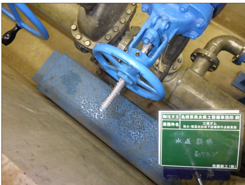
写真区分: 施工状況写真 工種: 水道設備 種別: 副バルブ 細別: 充水装置 写真タイトル: 給脂完了 撮影箇所: スピンドル
