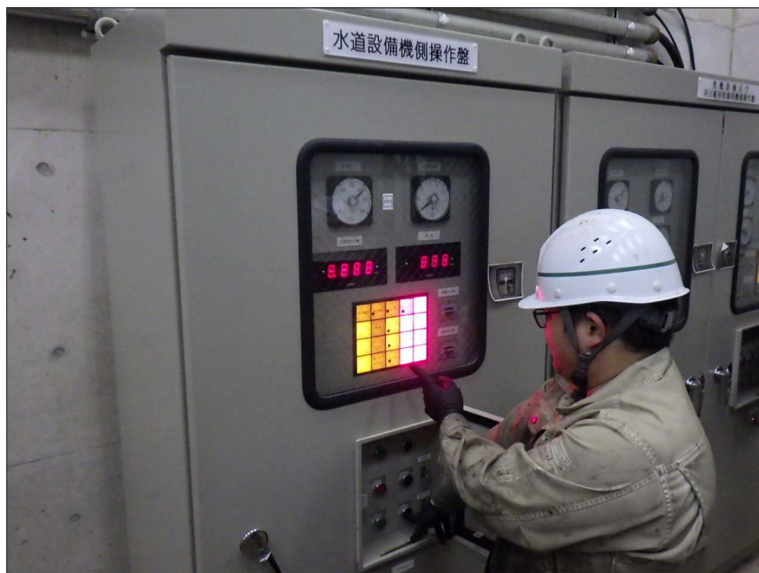
写真区分: 施工状況写真 工種: 水道設備 種別: 機側操作盤 写真タイトル: ランプテスト 確認状況 撮影箇所: 機側操作盤
