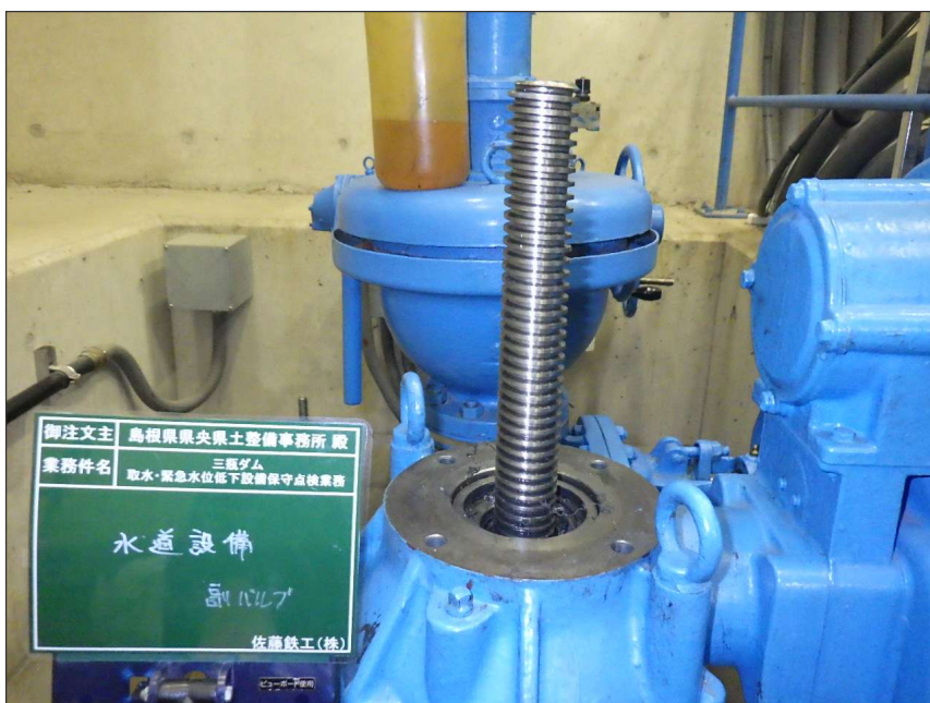
写真区分: 施工状況写真 工種: 水道設備 種別: 副バルブ 写真タイトル: 清掃完了 撮影箇所: スピンドル
