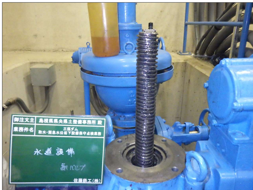
写真区分: 施工状況写真 工種: 水道設備 種別: 副バルブ 写真タイトル: 給脂完了 撮影箇所: スピンドル
