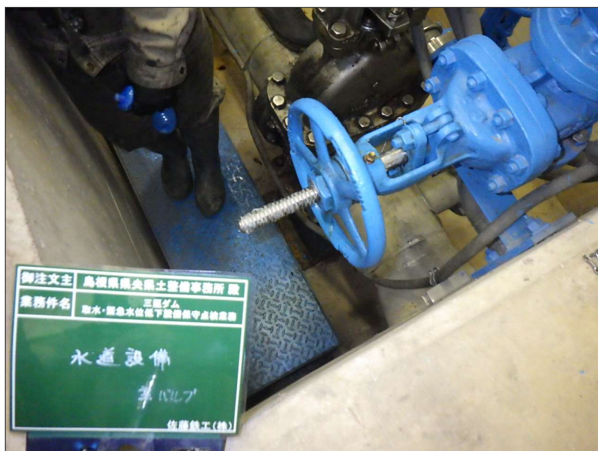
写真区分: 施工状況写真 工種: 水道設備 種別: 主バルブ 細別: 充水装置 写真タイトル: 給脂完了 撮影箇所: スピンドル
