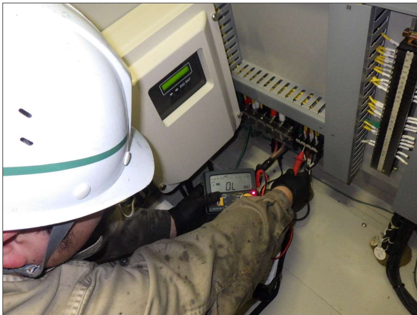
写真区分: 施工状況写真 工種: 水道設備 種別: 機側操作盤 写真タイトル: 絶縁抵抗測定 状況 撮影箇所: 機側操作盤
