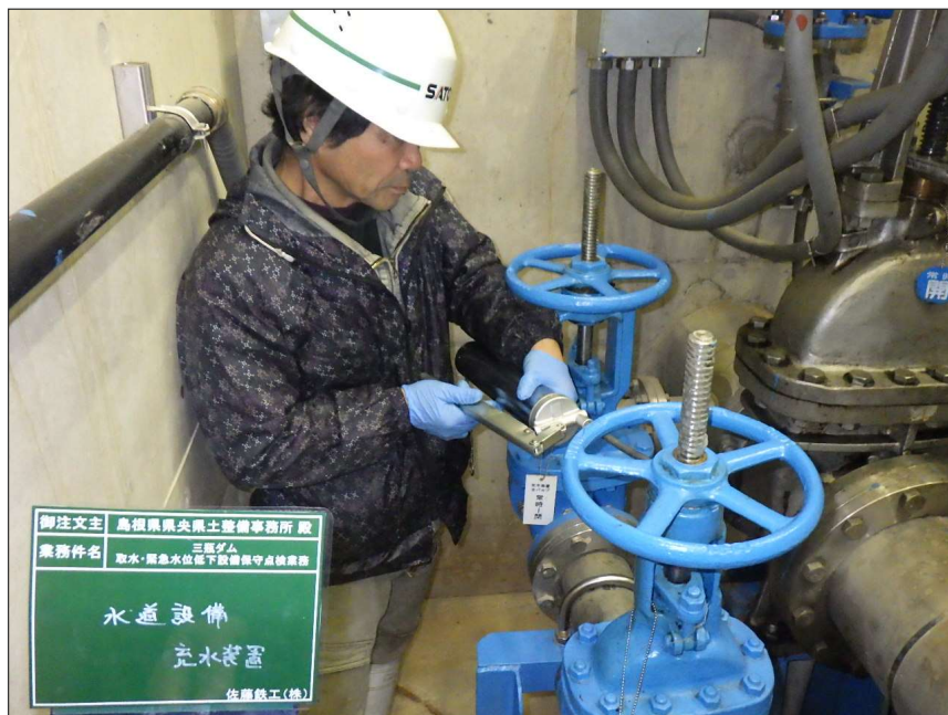
写真区分: 施工状況写真 工種: 水道設備 種別: 充水装置 写真タイトル: 給脂状況 撮影箇所: バルブハンドル
