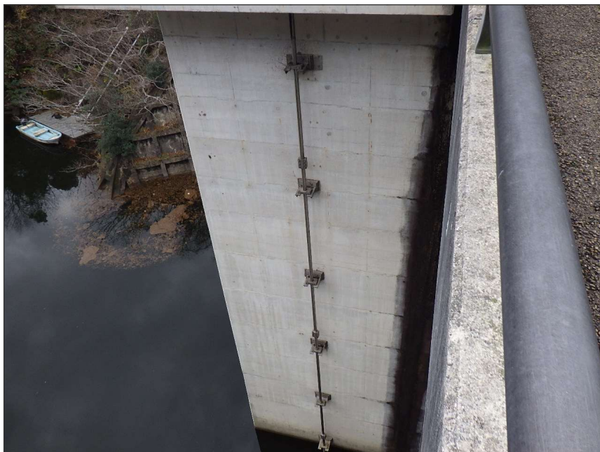
写真区分: 施工状況写真 工種: 緊急水位低下用ゲート 種別: 開閉装置 写真タイトル: 外観点検状況 撮影箇所: スピンドル
