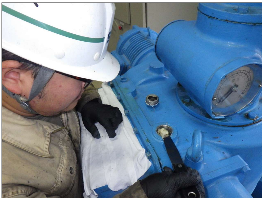
写真区分: 施工状況写真 工種: 緊急水位低下用ゲート 種別: 開閉装置 写真タイトル: 内部状態確認 撮影箇所: バルブコントロール内
