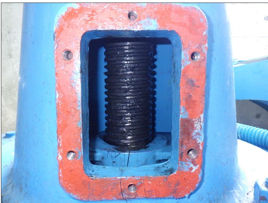
写真区分: 施工状況写真 工種: 緊急水位低下用ゲート 種別: 開閉装置 写真タイトル: 給脂完了 撮影箇所: スピンドル
