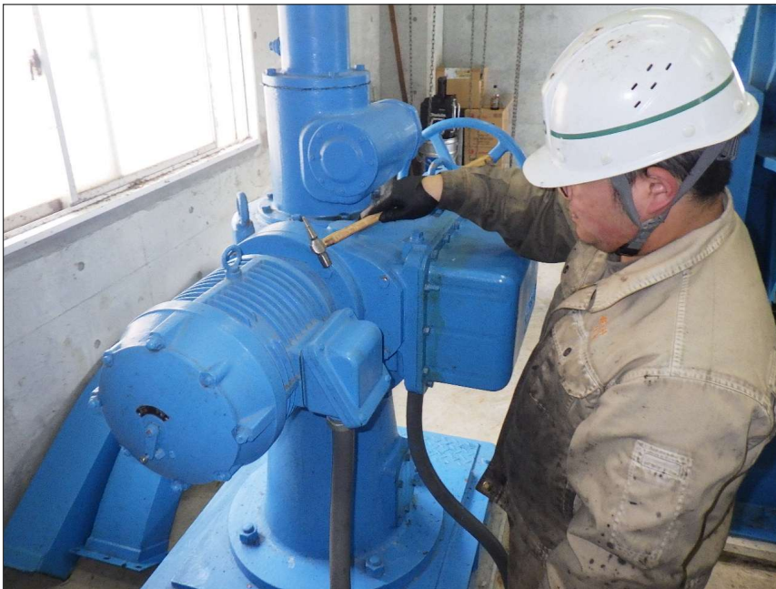
写真区分: 施工状況写真 工種: 緊急水位低下用ゲート 種別: 開閉装置 写真タイトル: ボルト緩み点 検状況 撮影箇所: 開閉装置
