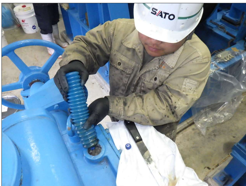
写真区分: 施工状況写真 工種: 緊急水位低下用ゲート 種別: 開閉装置 写真タイトル: 給脂状況 撮影箇所: バルブコントロール内
