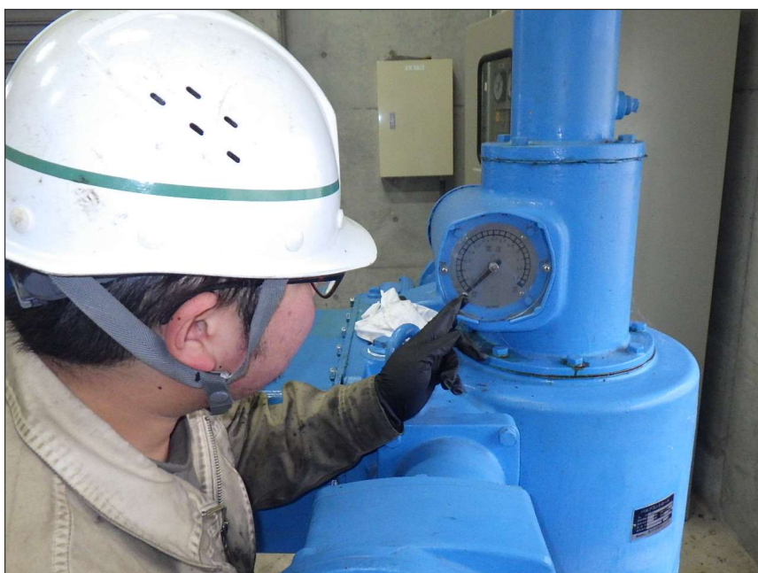
写真区分: 施工状況写真 工種: 緊急水位低下用ゲート 種別: 開閉装置 写真タイトル: 外観点検状況 撮影箇所: 開度計
