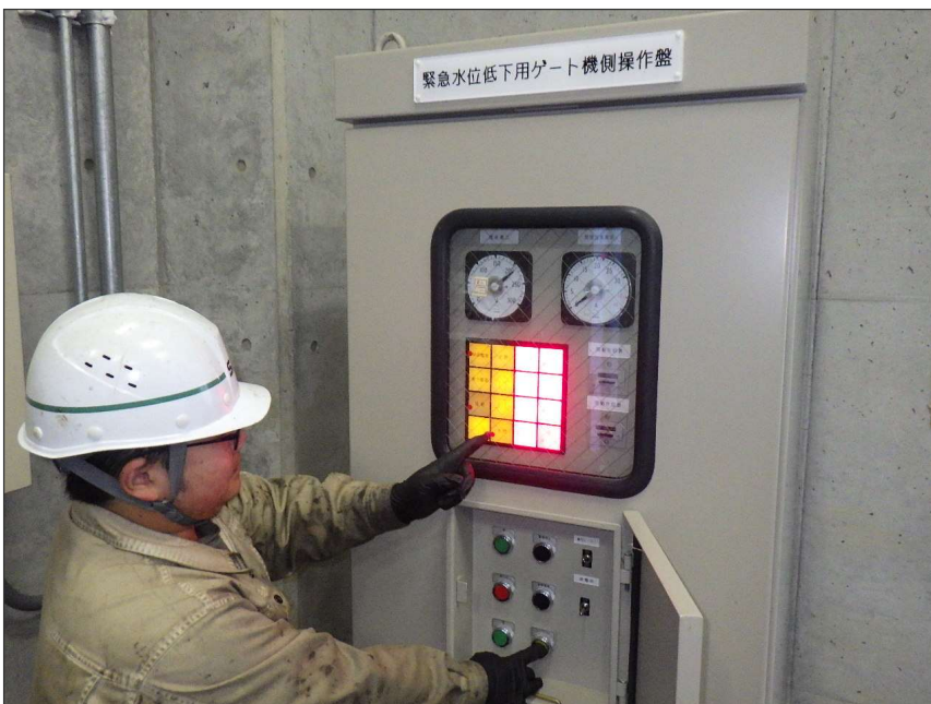
写真区分: 施工状況写真 工種: 緊急水位低下用ゲート 種別: 機側操作盤 写真タイトル: ランプテスト 確認状況 撮影箇所: 機側操作盤
