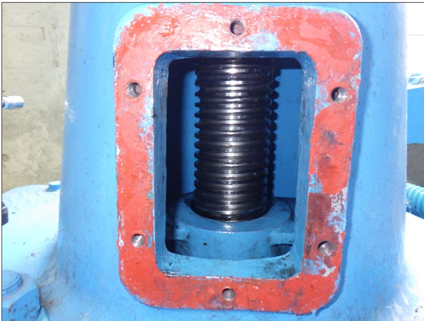
写真区分: 施工状況写真 工種: 緊急水位低下用ゲート 種別: 開閉装置 写真タイトル: 清掃完了 撮影箇所: スピンドル
