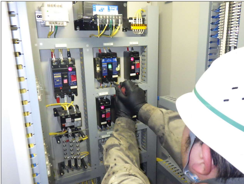
写真区分: 施工状況写真 工種: 緊急水位低下用ゲート 種別: 機側操作盤 写真タイトル: 端子緩み点検状況 撮影箇所: 機側操作盤
