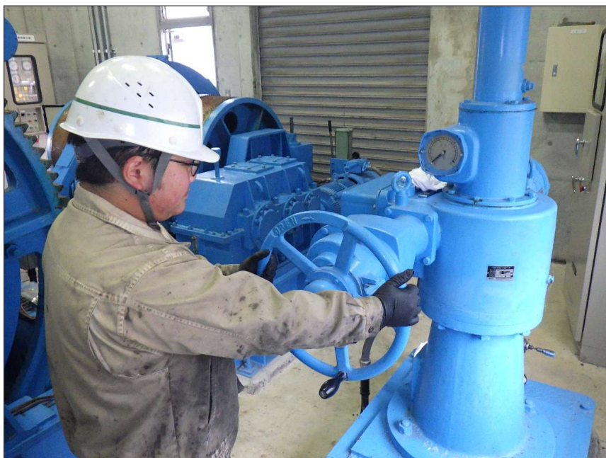
写真区分: 施工状況写真 工種: 緊急水位低下用ゲート 種別: 開閉装置 写真タイトル: 機能確認 撮影箇所: 手動ハンドル
