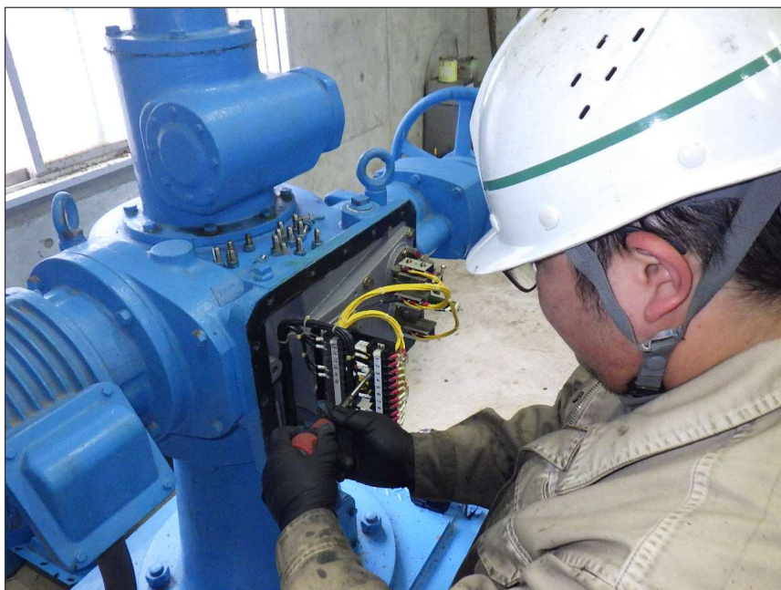
写真区分: 施工状況写真 工種: 緊急水位低下用ゲート 種別: 開閉装置 写真タイトル: 端子緩み点検 状況 撮影箇所: 制限開閉器
