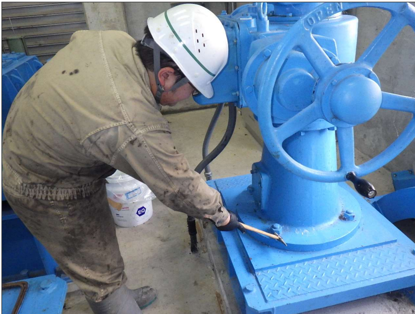
写真区分: 施工状況写真 工種: 緊急水位低下用ゲート 種別: 開閉装置 写真タイトル: ボルト緩み点 検状況 撮影箇所: 開閉装置架台
