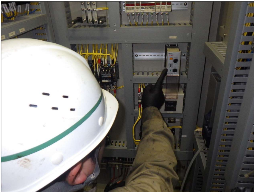
写真区分: 施工状況写真 工種: 緊急水位低下用ゲート 種別: 機側操作盤 写真タイトル: 設定値確認状況 撮影箇所: 機側操作盤
