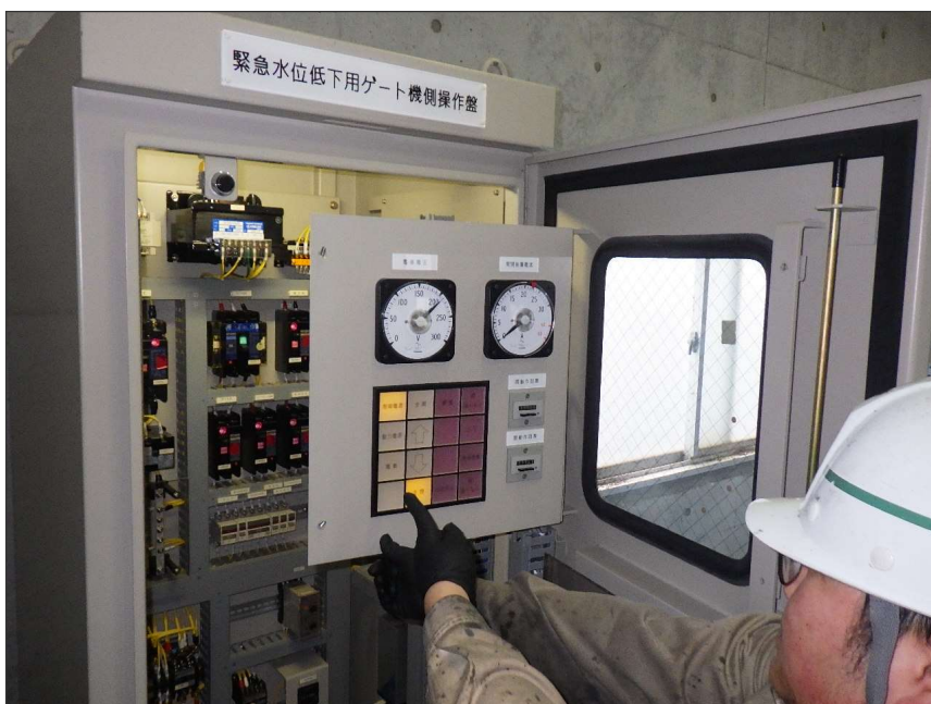
写真区分: 施工状況写真 工種: 緊急水位低下用ゲート 種別: 開閉装置 写真タイトル: 機能確認 撮影箇所: 手動切替装置
