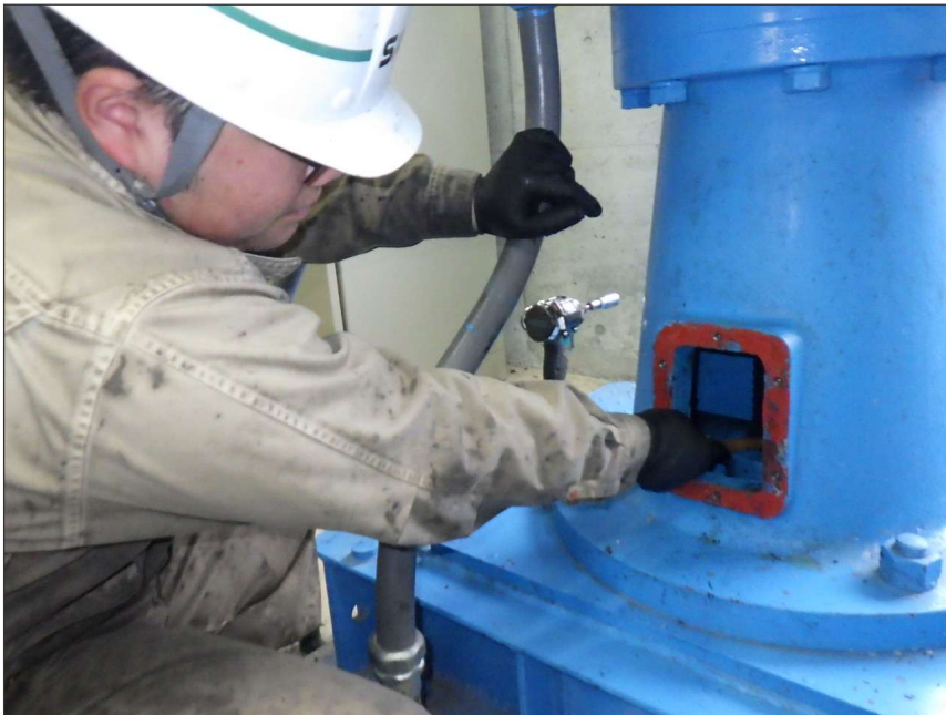
写真区分: 施工状況写真 工種: 緊急水位低下用ゲート 種別: 開閉装置 写真タイトル: 給脂状況 撮影箇所: スピンドル
