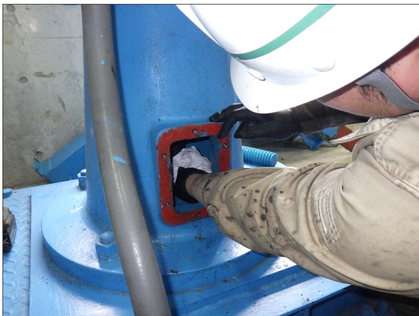
写真区分: 施工状況写真 工種: 緊急水位低下用ゲート 種別: 開閉装置 写真タイトル: 清掃状況 撮影箇所: スピンドル
