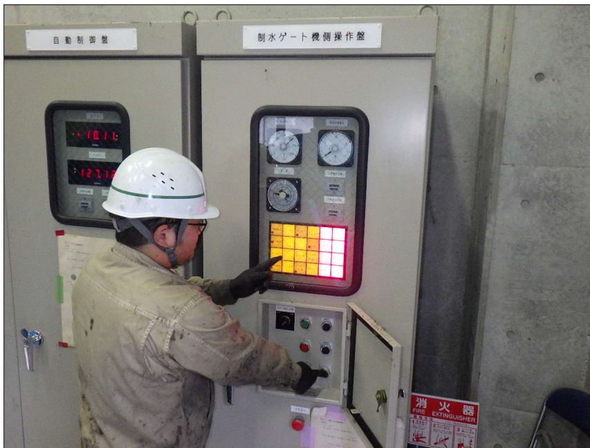
写真区分: 施工状況写真 工種: 制水ゲート 種別: 開閉装置 写真タイトル: ランプテスト 確認状況 撮影箇所: 機側操作盤
