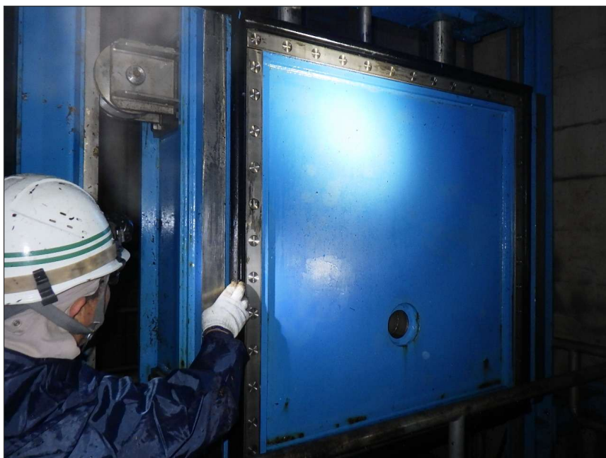
写真区分: 施工状況写真 工種: 制水ゲート 種別: 扉体 写真タイトル: 外観点検状況 撮影箇所: 側部水密ゴム
