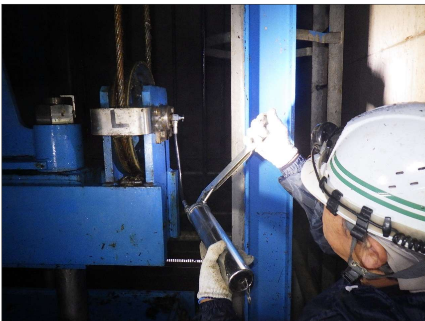
写真区分: 施工状況写真 工種: 制水ゲート 種別: 扉体 細別: リフティングビーム 写真タイトル: 給脂状況 撮影箇所: シーブ
