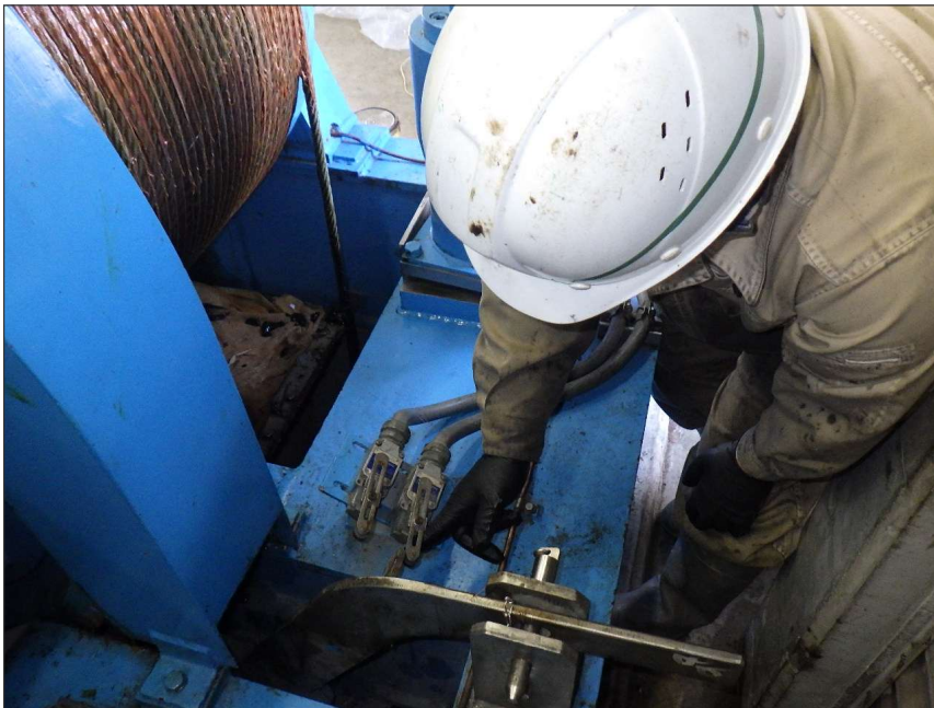
写真区分: 施工状況写真 工種: 制水ゲート 種別: 開閉装置 細別: 休止装置 写真タイトル: 機能確認 撮影箇所: リミットスイッチ
