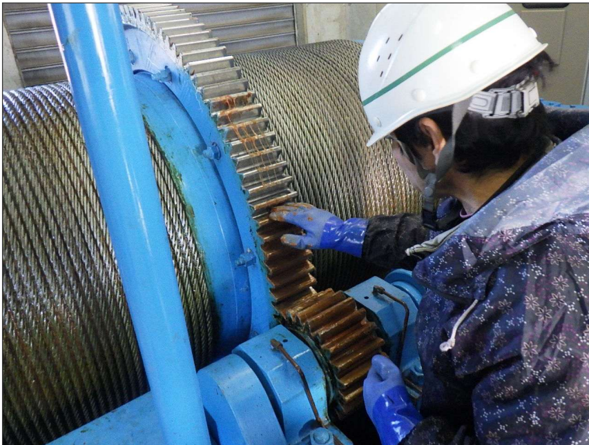
写真区分: 施工状況写真 工種: 制水ゲート 種別: 開閉装置 写真タイトル: 給脂状況 撮影箇所: ドラムギヤ
