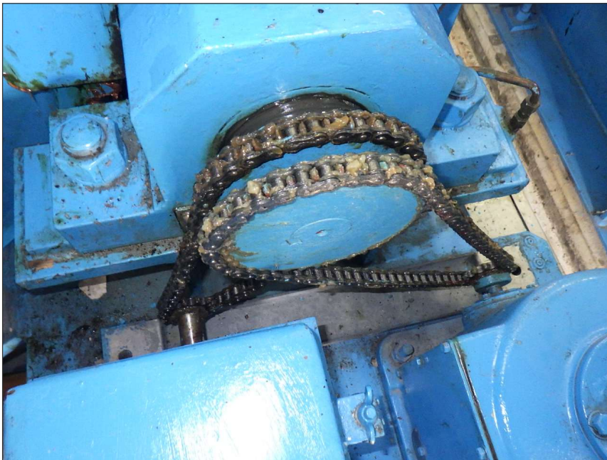
写真区分: 施工状況写真 工種: 制水ゲート 種別: 開閉装置 細別: 開度計・制限開閉器 写真タイトル: 清掃前 撮影箇所: チェーン
