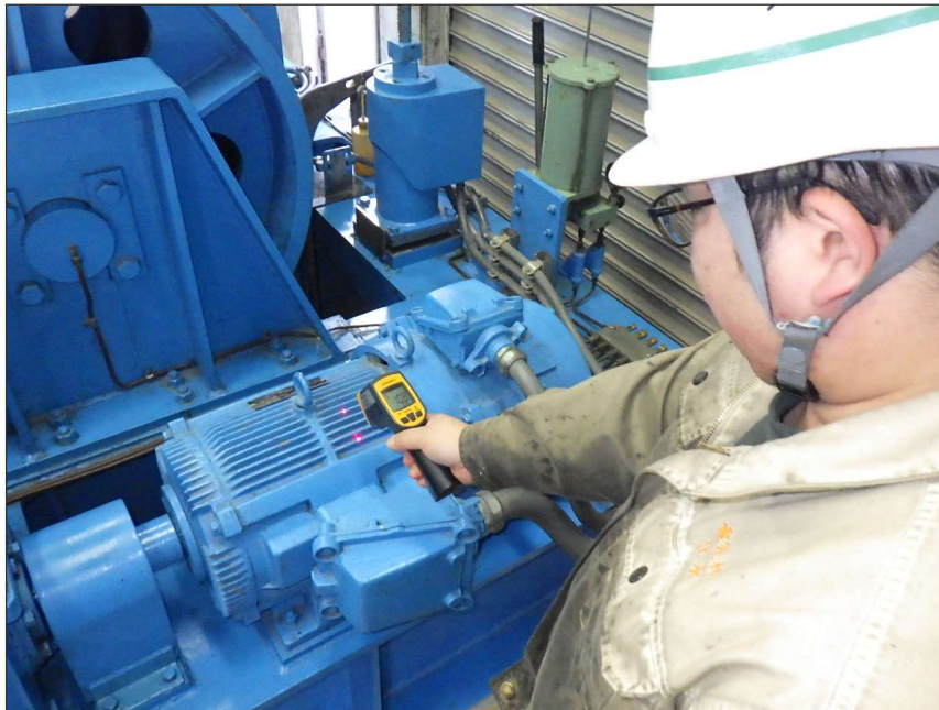
写真区分: 施工状況写真 工種: 制水ゲート 種別: 開閉装置 写真タイトル: 管理運転状況 撮影箇所: 電動機
