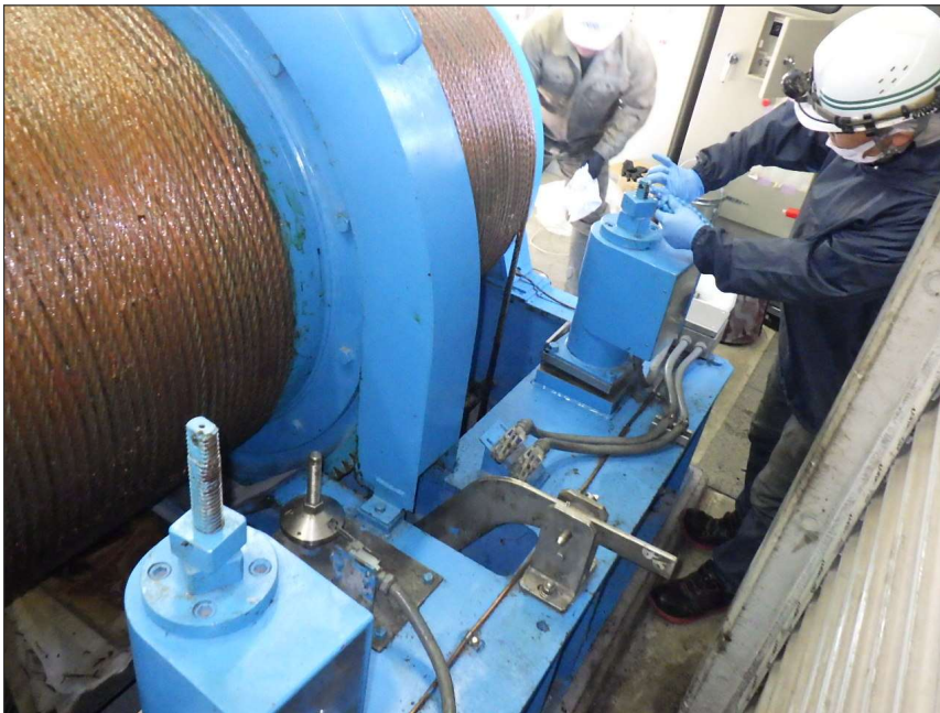
写真区分: 施工状況写真 工種: 制水ゲート 種別: 開閉装置 細別: ゲートロボ 写真タイトル: 清掃完了 撮影箇所: スピンドル
