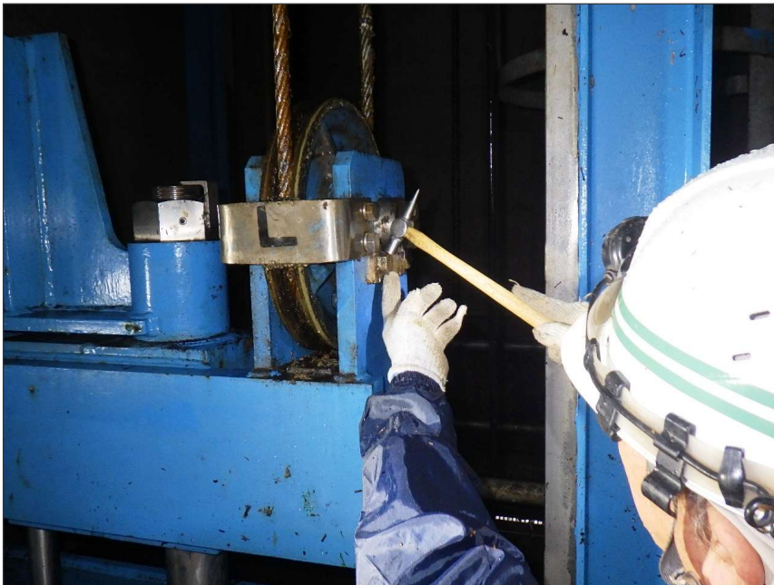
写真区分: 施工状況写真 工種: 制水ゲート 種別: 扉体 細別: リフティングビーム 写真タイトル: ボルト緩み点 検状況 撮影箇所: シーブ
