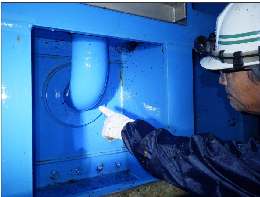
写真区分: 施工状況写真 工種: 制水ゲート 種別: 扉体 写真タイトル: 外観点検状況 撮影箇所: 充水管
