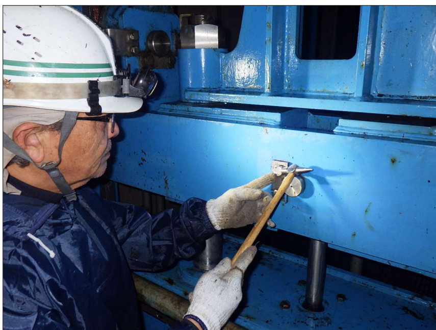
写真区分: 施工状況写真 工種: 制水ゲート 種別: 扉体 細別: リフティングビーム 写真タイトル: ボルト緩み点 検状況 撮影箇所: リフティングビーム
