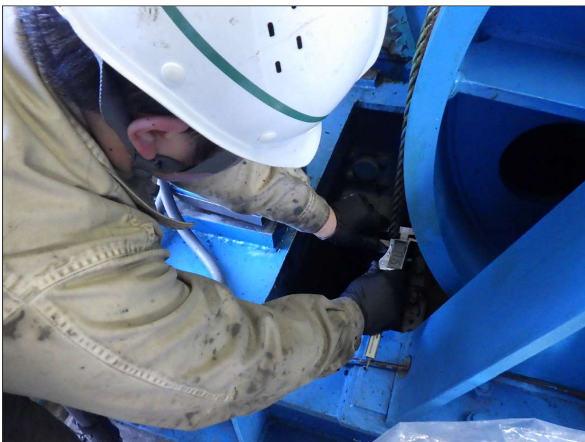
写真区分: 施工状況写真 工種: 制水ゲート 種別: 開閉装置 写真タイトル: 計測状況 撮影箇所: ワイヤロープ径
