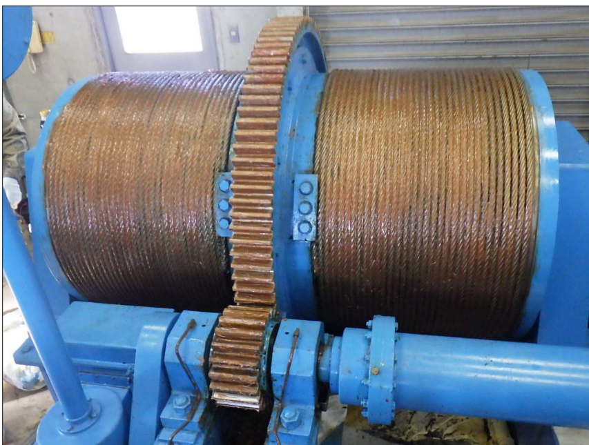
写真区分: 施工状況写真 工種: 制水ゲート 種別: 開閉装置 写真タイトル: 給脂完了 撮影箇所: ワイヤロープ・ド ラムギヤ
