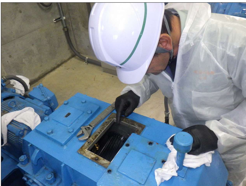
写真区分: 施工状況写真 工種: 制水ゲート 種別: 開閉装置 細別: 減速機 写真タイトル: 歯面確認 撮影箇所: 減速機
