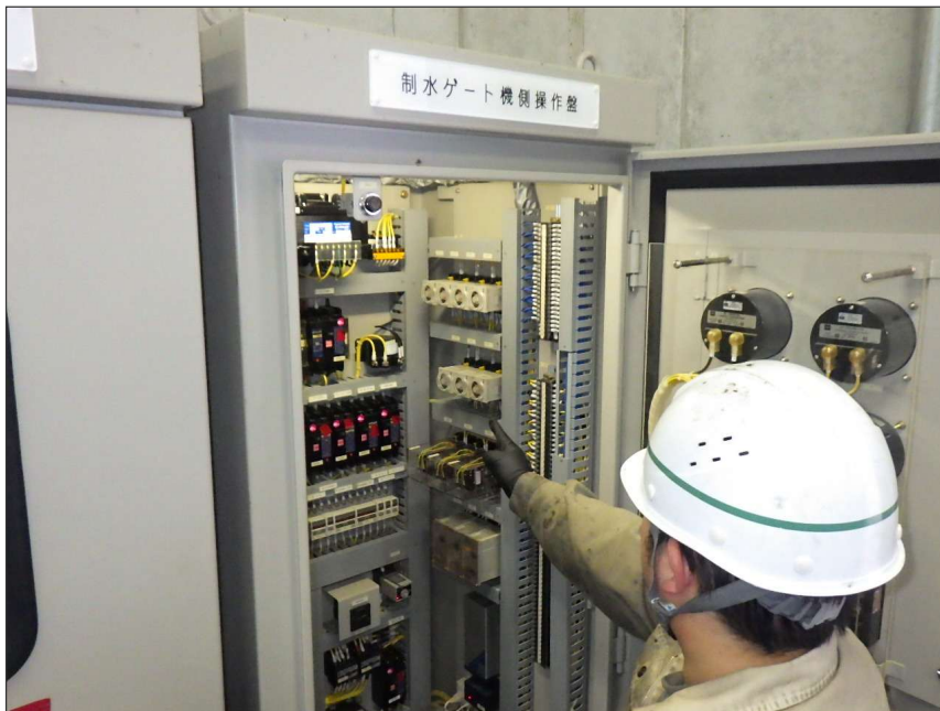
写真区分: 施工状況写真 工種: 制水ゲート 種別: 開閉装置 写真タイトル: 外観点検状況 撮影箇所: 機側操作盤
