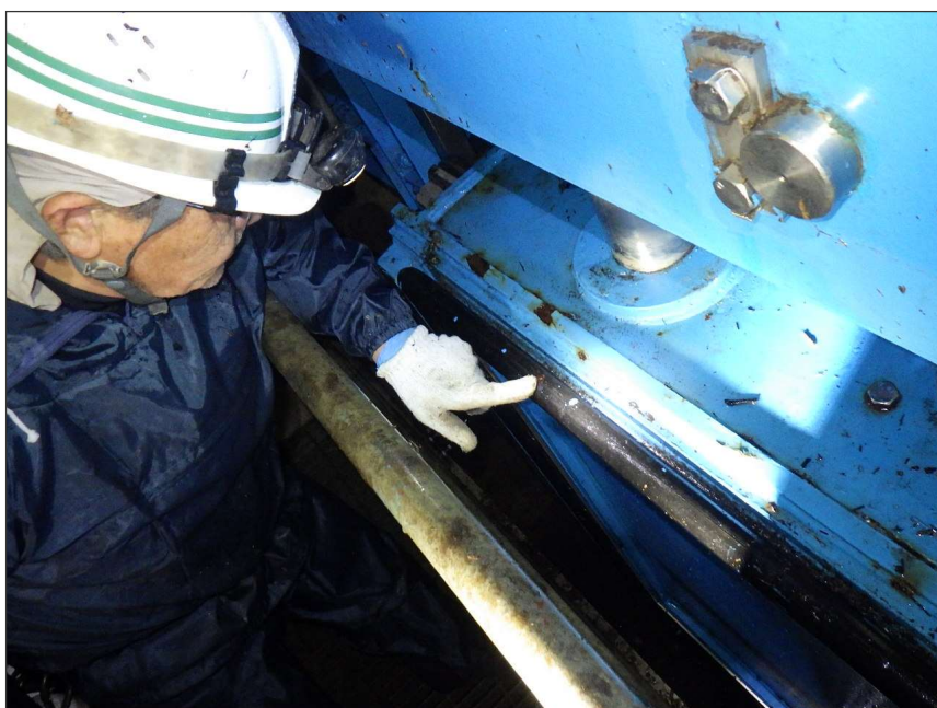
写真区分: 施工状況写真 工種: 制水ゲート 種別: 扉体 写真タイトル: 外観点検状況 撮影箇所: 上部水密ゴム
