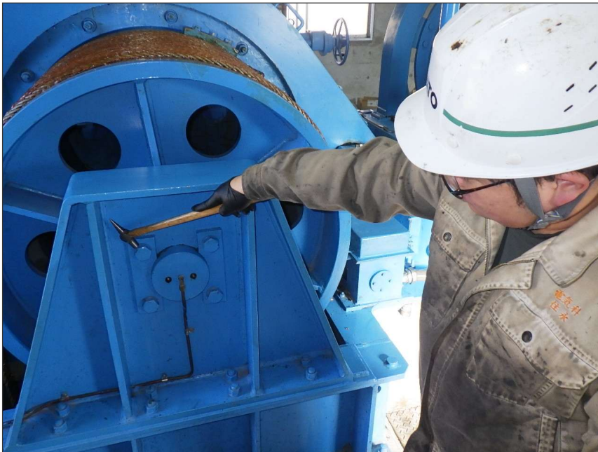
写真区分: 施工状況写真 工種: 制水ゲート 種別: 開閉装置 写真タイトル: ボルト緩み点 検状況 撮影箇所: キーププレート
