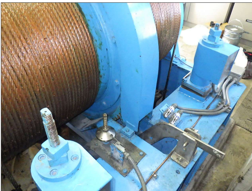
写真区分: 施工状況写真 工種: 制水ゲート 種別: 開閉装置 細別: ゲートロボ 写真タイトル: 清掃前 撮影箇所: スピンドル
