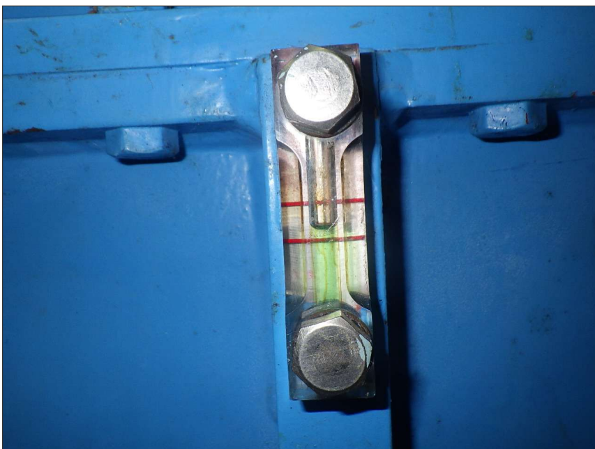
写真区分: 施工状況写真 工種: 制水ゲート 種別: 開閉装置 細別: 減速機 写真タイトル: 給油完了 撮影箇所: 減速機
