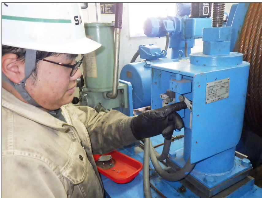
写真区分: 施工状況写真 工種: 制水ゲート 種別: 開閉装置 細別: ゲートロボ 写真タイトル: 機能確認 撮影箇所: リミットスイッチ
