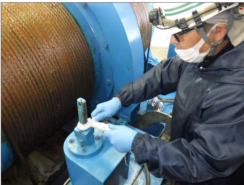
写真区分: 施工状況写真 工種: 制水ゲート 種別: 開閉装置 細別: ゲートロボ 写真タイトル: 清掃状況 撮影箇所: スピンドル
