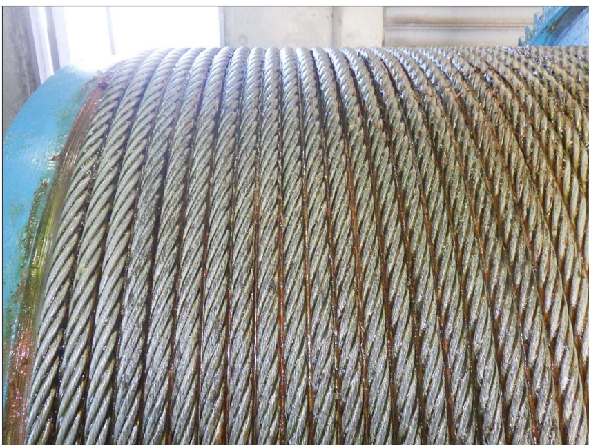
写真区分: 施工状況写真 工種: 制水ゲート 種別: 開閉装置 写真タイトル: 清掃完了 撮影箇所: ワイヤロープ
