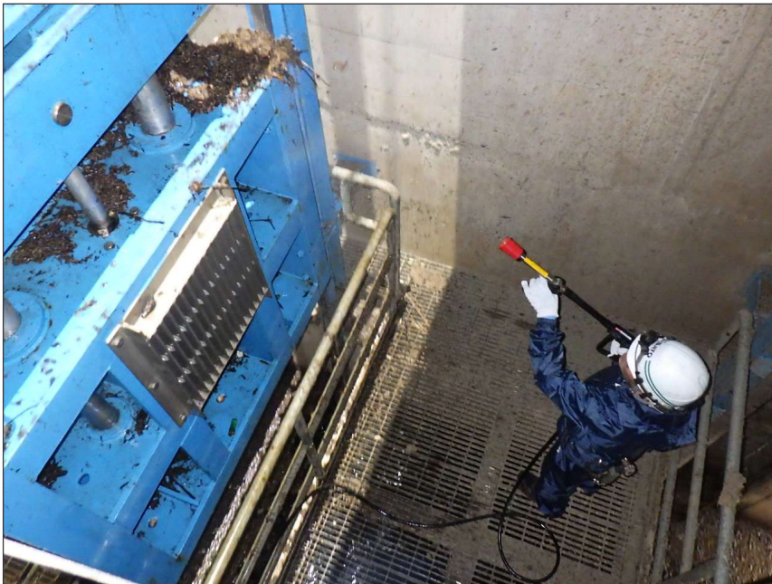
写真区分: 施工状況写真 工種: 制水ゲート 種別: 扉体 写真タイトル: 清掃状況 撮影箇所: 扉体桁
