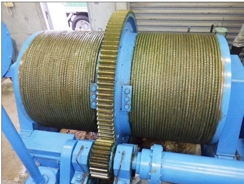
写真区分: 施工状況写真 工種: 制水ゲート 種別: 開閉装置 写真タイトル: 清掃前 撮影箇所: ワイヤロープ・ド ラムギヤ
