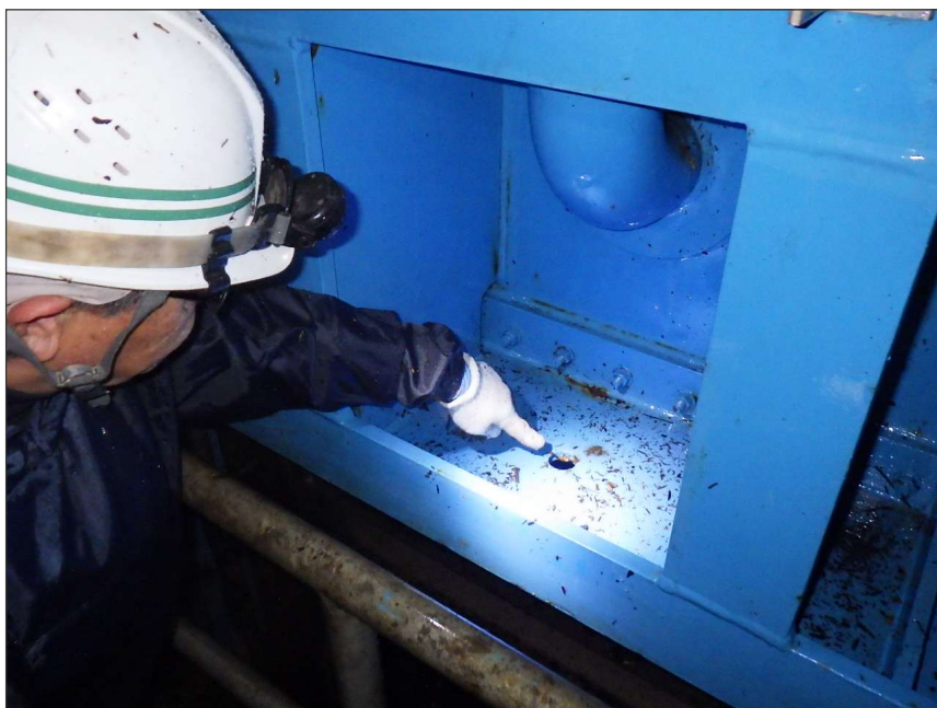
写真区分: 施工状況写真 工種: 制水ゲート 種別: 扉体 写真タイトル: 外観点検状況 撮影箇所: 水抜穴
