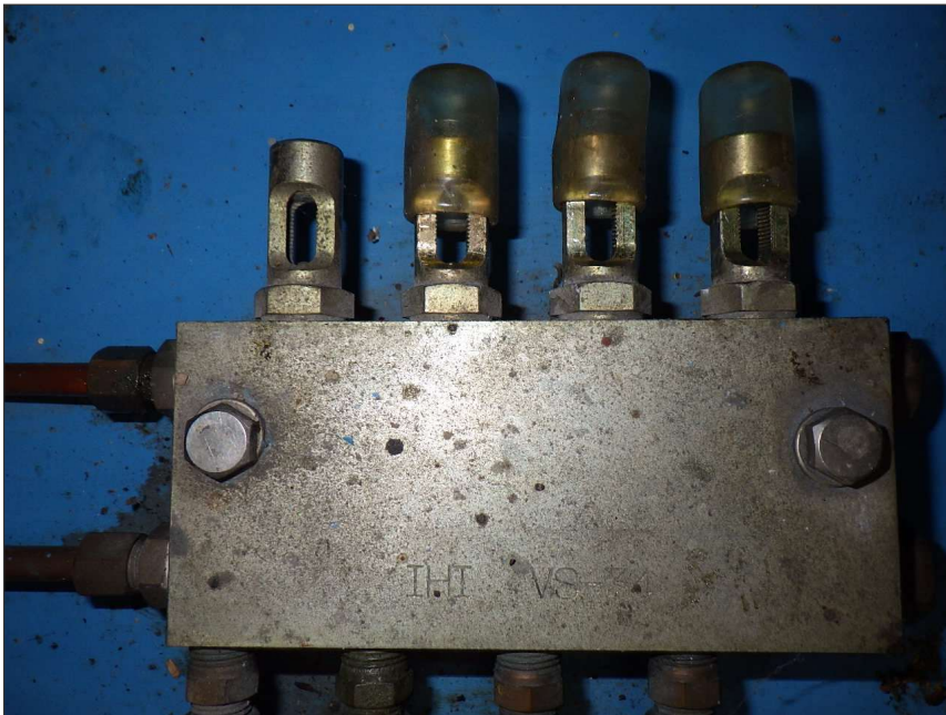
写真区分: 施工状況写真 工種: 制水ゲート 種別: 開閉装置 写真タイトル: 給脂前 撮影箇所: 集中給油装置
