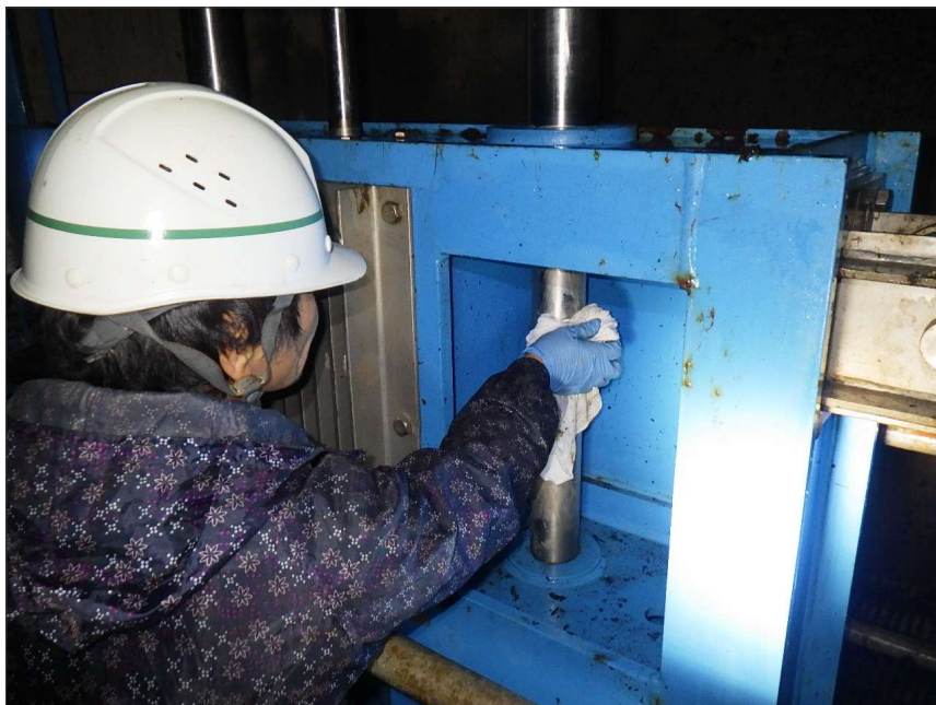
写真区分: 施工状況写真 工種: 制水ゲート 種別: 扉体 細別: リフティングビーム 写真タイトル: 清掃状況 撮影箇所: シリンダーロッド
