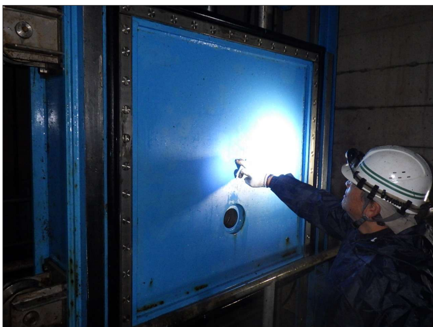
写真区分: 施工状況写真 工種: 制水ゲート 種別: 扉体 写真タイトル: 外観点検状況 撮影箇所: スキンプレート
