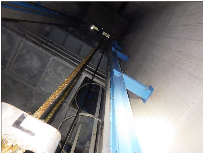
写真区分: 施工状況写真 工種: 制水ゲート 種別: 扉体 細別: 戸当り 写真タイトル: 外観点検状況 撮影箇所: 戸当り
