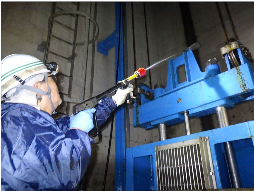
写真区分: 施工状況写真 工種: 制水ゲート 種別: 扉体 細別: リフティングビーム 写真タイトル: 清掃状況 撮影箇所: リフティングビーム
