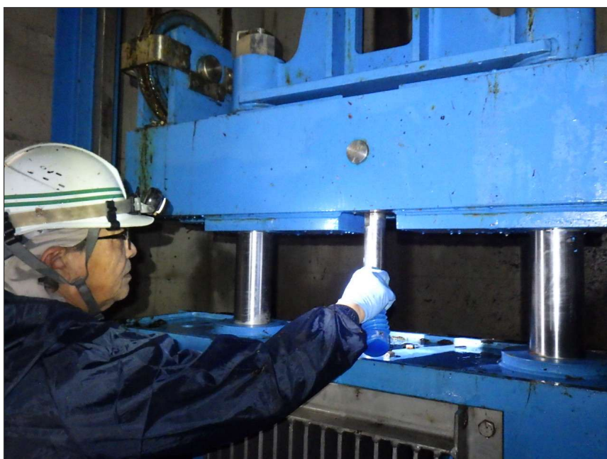
写真区分: 施工状況写真 工種: 制水ゲート 種別: 扉体 細別: リフティングビーム 写真タイトル: 給脂状況 撮影箇所: シリンダーロッド
