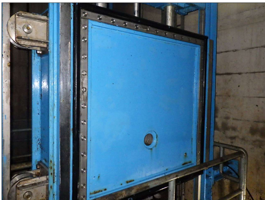
写真区分: 施工状況写真 工種: 制水ゲート 種別: 扉体 写真タイトル: 外観点検状況 撮影箇所: 全景
