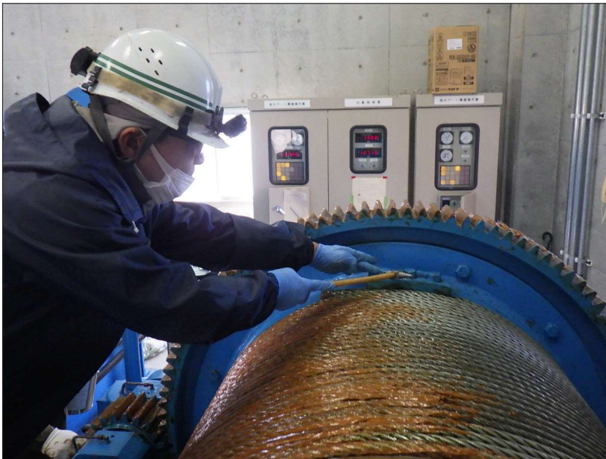
写真区分: 施工状況写真 工種: 制水ゲート 種別: 開閉装置 写真タイトル: ボルト緩み点 検状況 撮影箇所: ロープ端末締付ボ ルト
