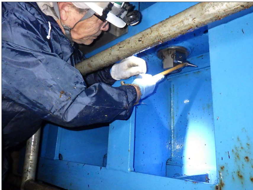
写真区分: 施工状況写真 工種: 制水ゲート 種別: 扉体 細別: リフティングビーム 写真タイトル: ボルト緩み点 検状況 撮影箇所: シリンダーロッド
