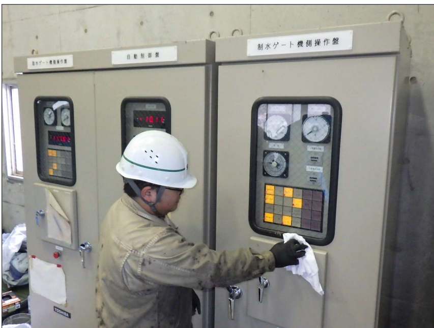
写真区分: 施工状況写真 工種: 制水ゲート 種別: 開閉装置 写真タイトル: 清掃状況 撮影箇所: 機側操作盤
