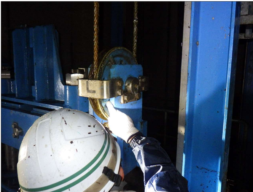
写真区分: 施工状況写真 工種: 制水ゲート 種別: 扉体 細別: リフティングビーム 写真タイトル: 外観点検状況 撮影箇所: シーブ
