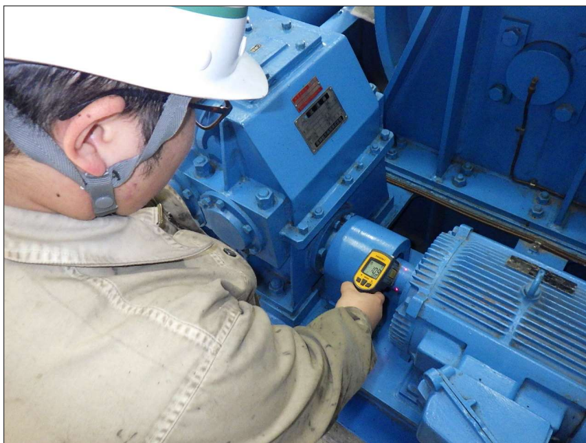
写真区分: 施工状況写真 工種: 制水ゲート 種別: 開閉装置 写真タイトル: 管理運転状況 撮影箇所: 減速機
