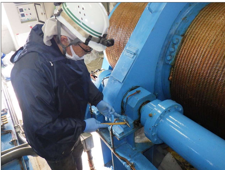
写真区分: 施工状況写真 工種: 制水ゲート 種別: 開閉装置 写真タイトル: ボルト緩み点 検状況 撮影箇所: 軸受
