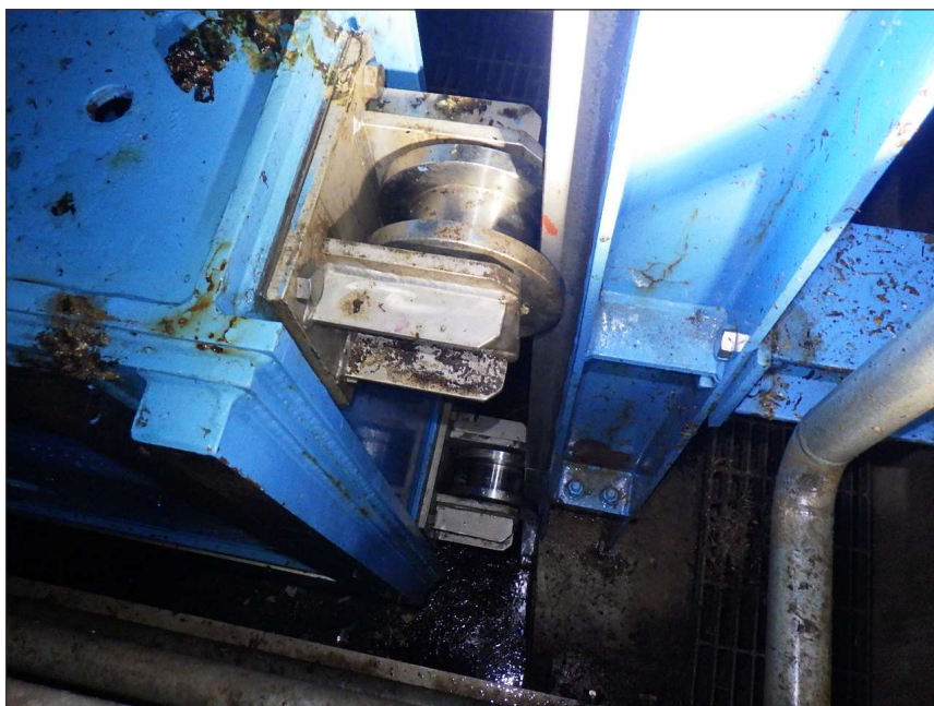
写真区分: 施工状況写真 工種: 制水ゲート 種別: 扉体 写真タイトル: 外観点検状況 撮影箇所: サイドローラ
