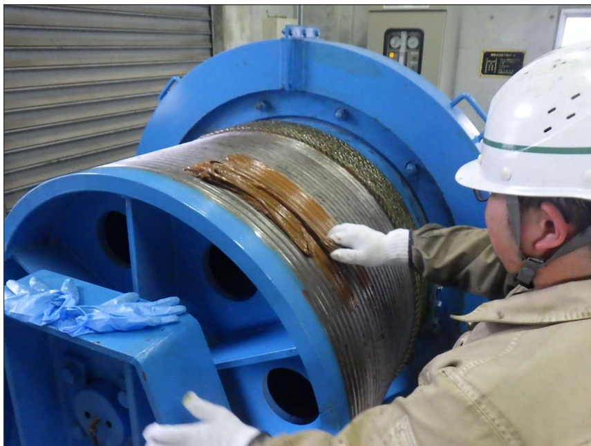
写真区分: 施工状況写真 工種: 制水ゲート 種別: 開閉装置 写真タイトル: 給脂状況 撮影箇所: ワイヤドラム
