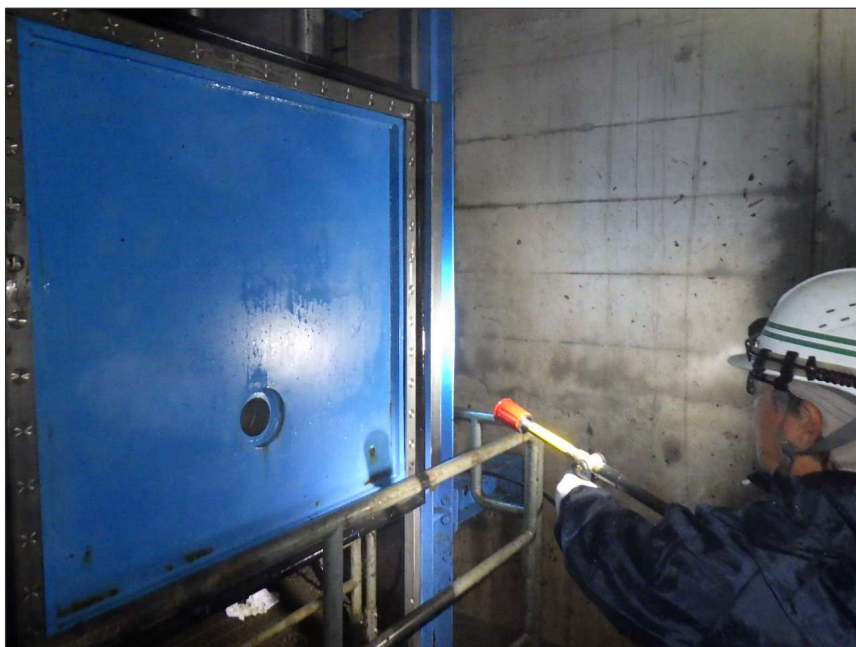
写真区分: 施工状況写真 工種: 制水ゲート 種別: 扉体 写真タイトル: 清掃状況 撮影箇所: スキンプレート
