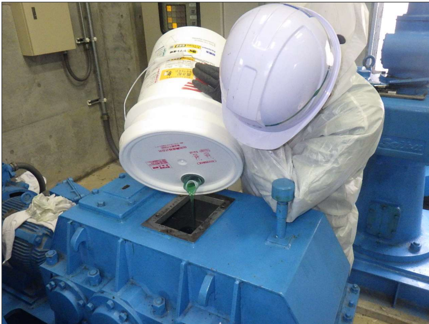
写真区分: 施工状況写真 工種: 制水ゲート 種別: 開閉装置 細別: 減速機 写真タイトル: 給油状況 撮影箇所: 減速機
