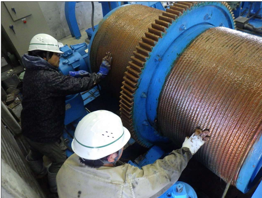
写真区分: 施工状況写真 工種: 制水ゲート 種別: 開閉装置 写真タイトル: 給脂状況 撮影箇所: ワイヤロープ
