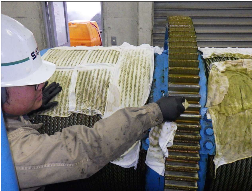
写真区分: 施工状況写真 工種: 制水ゲート 種別: 開閉装置 写真タイトル: 清掃状況 撮影箇所: ドラムギヤ
