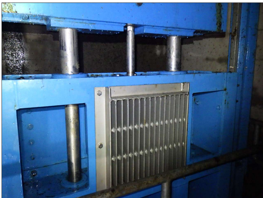
写真区分: 施工状況写真 工種: 制水ゲート 種別: 扉体 細別: リフティングビーム 写真タイトル: 清掃前 撮影箇所: シリンダーロッド
