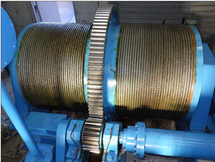
写真区分: 施工状況写真 工種: 制水ゲート 種別: 開閉装置 写真タイトル: 清掃完了 撮影箇所: ワイヤロープ・ド ラムギヤ
