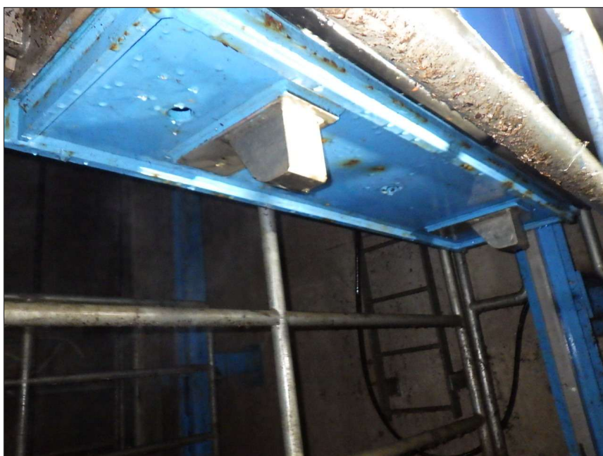
写真区分: 施工状況写真 工種: 制水ゲート 種別: 扉体 写真タイトル: 外観点検状況 撮影箇所: 扉体下部
