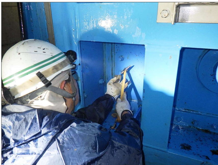
写真区分: 施工状況写真 工種: 制水ゲート 種別: 扉体 写真タイトル: ボルト緩み点 検状況 撮影箇所: 側部水密ゴム押え
