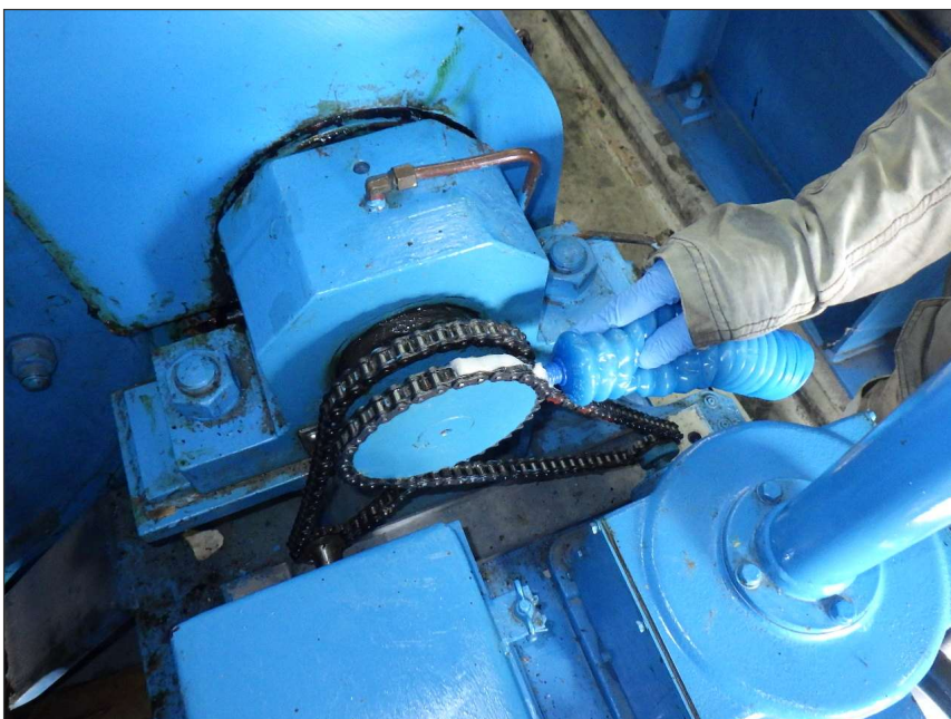
写真区分: 施工状況写真 工種: 制水ゲート 種別: 開閉装置 細別: 開度計・制限開閉器 写真タイトル: 給脂状況 撮影箇所: チェーン
