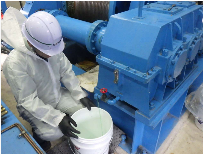
写真区分: 施工状況写真 工種: 制水ゲート 種別: 開閉装置 細別: 減速機 写真タイトル: 抜油状況 撮影箇所: 減速機
