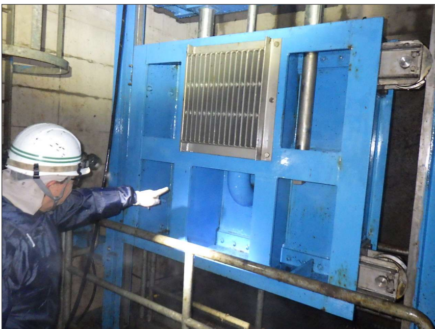
写真区分: 施工状況写真 工種: 制水ゲート 種別: 扉体 写真タイトル: 外観点検状況 撮影箇所: 扉体桁
