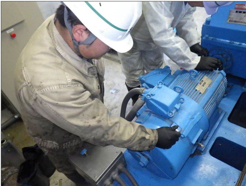
写真区分: 施工状況写真 工種: 制水ゲート 種別: 開閉装置 細別: 電動機 写真タイトル: 計測状況 撮影箇所: ブレーキ隙間
