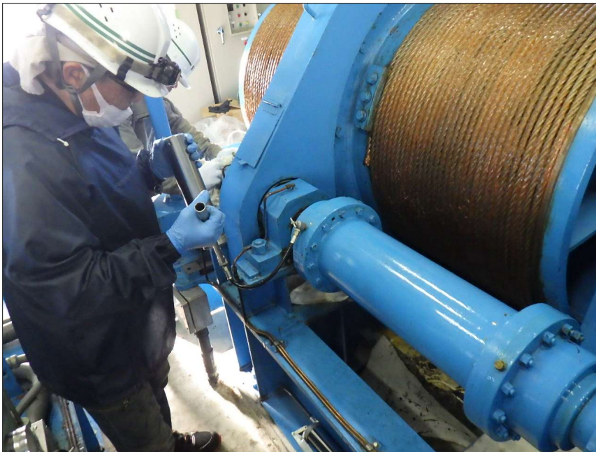
写真区分: 施工状況写真 工種: 制水ゲート 種別: 開閉装置 写真タイトル: 集中給油装置 撮影箇所: ギヤカップリング
