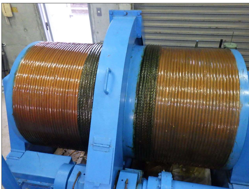
写真区分: 施工状況写真 工種: 制水ゲート 種別: 開閉装置 写真タイトル: 給脂完了 撮影箇所: ワイヤドラム
