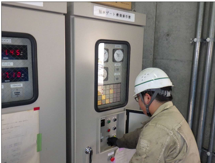
写真区分: 施工状況写真 工種: 制水ゲート 種別: 開閉装置 写真タイトル: 管理運転状況 撮影箇所: 機側操作盤
