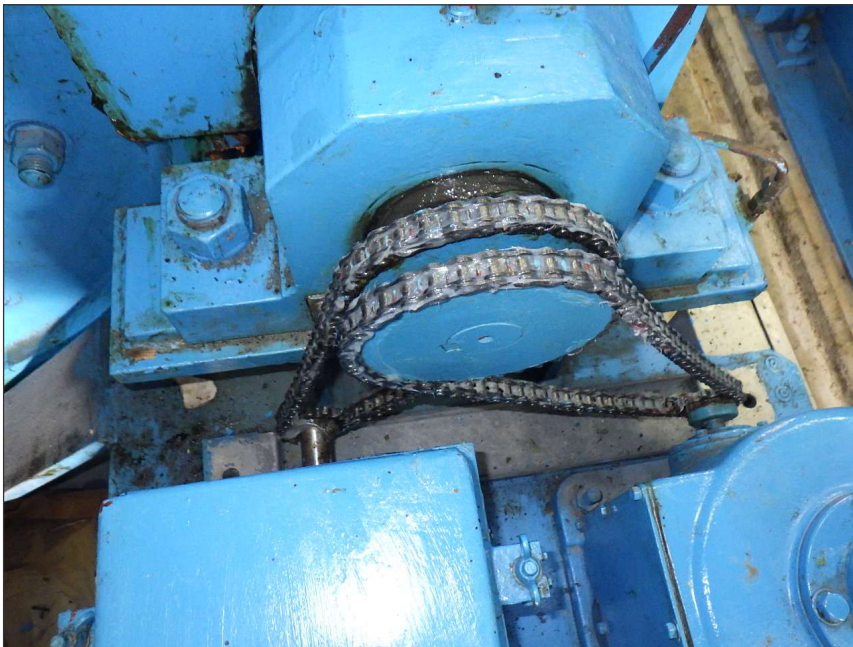
写真区分: 施工状況写真 工種: 制水ゲート 種別: 開閉装置 細別: 開度計・制限開閉器 写真タイトル: 給脂完了 撮影箇所: チェーン
