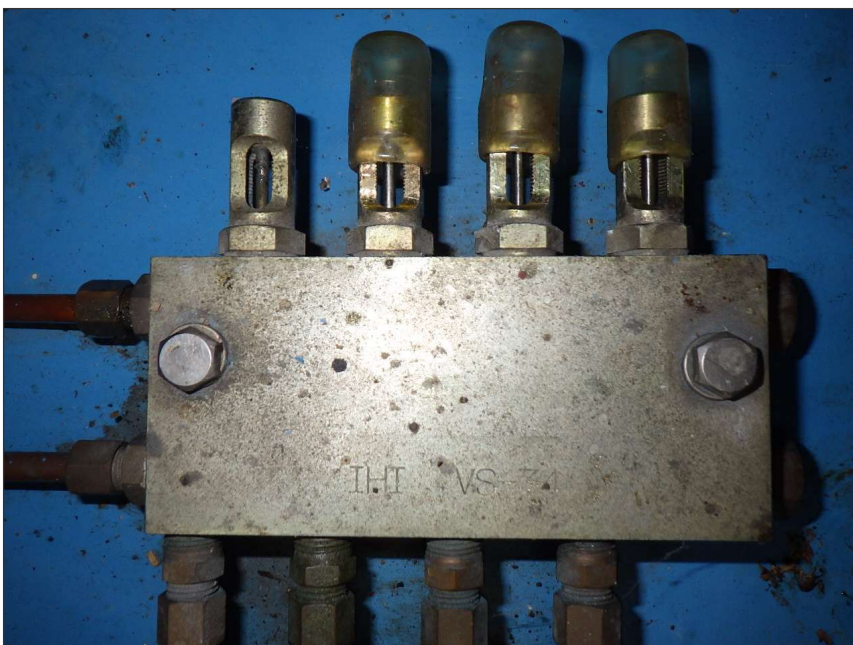
写真区分: 施工状況写真 工種: 制水ゲート 種別: 開閉装置 写真タイトル: 給脂完了 撮影箇所: 集中給油装置
