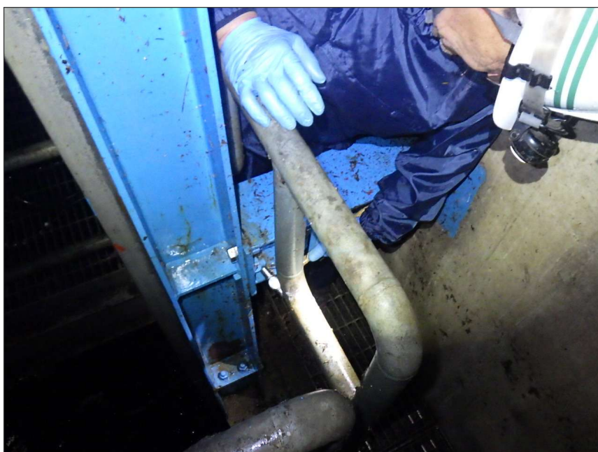
写真区分: 施工状況写真 工種: 制水ゲート 種別: 扉体 細別: 戸当り 写真タイトル: ボルト緩み点 検状況 撮影箇所: 戸当り
