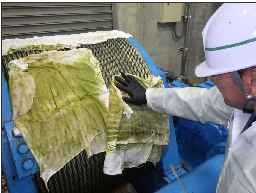
写真区分: 施工状況写真 工種: 制水ゲート 種別: 開閉装置 写真タイトル: 清掃状況 撮影箇所: ワイヤロープ
