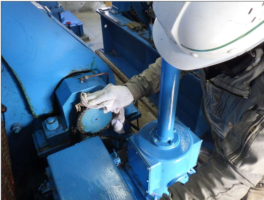
写真区分: 施工状況写真 工種: 制水ゲート 種別: 開閉装置 細別: 開度計・制限開閉器 写真タイトル: 清掃状況 撮影箇所: チェーン
