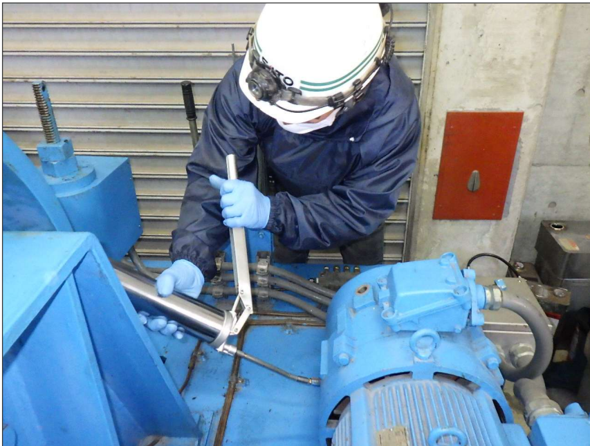
写真区分: 施工状況写真 工種: 制水ゲート 種別: 開閉装置 写真タイトル: 給脂状況 撮影箇所: 電動機
