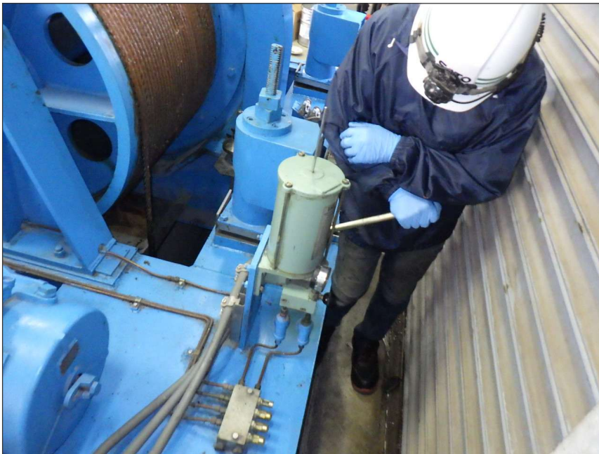
写真区分: 施工状況写真 工種: 制水ゲート 種別: 開閉装置 写真タイトル: 機能確認 撮影箇所: 集中給油装置
