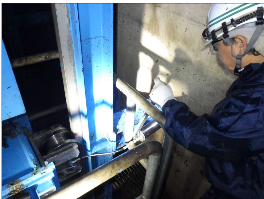
写真区分: 施工状況写真 工種: 制水ゲート 種別: 扉体 写真タイトル: 給脂状況 撮影箇所: サイドローラ
