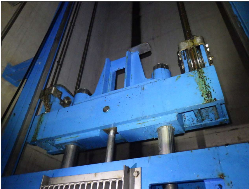
写真区分: 施工状況写真 工種: 制水ゲート 種別: 扉体 細別: リフティングビーム 写真タイトル: 外観点検状況 撮影箇所: リフティングビーム
