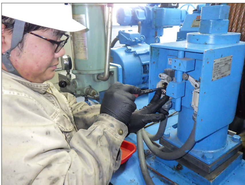
写真区分: 施工状況写真 工種: 制水ゲート 種別: 開閉装置 細別: ゲートロボ 写真タイトル: 端子緩み点検 状況 撮影箇所: リミットスイッチ
