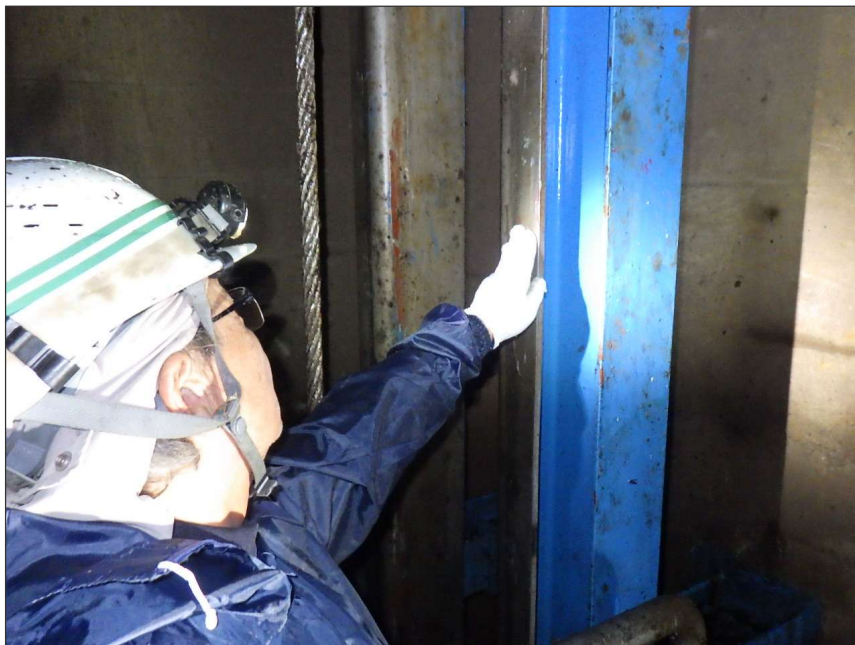
写真区分: 施工状況写真 工種: 取水ゲート 種別: 戸当り 写真タイトル: 外観点検状況 撮影箇所: 戸当り
