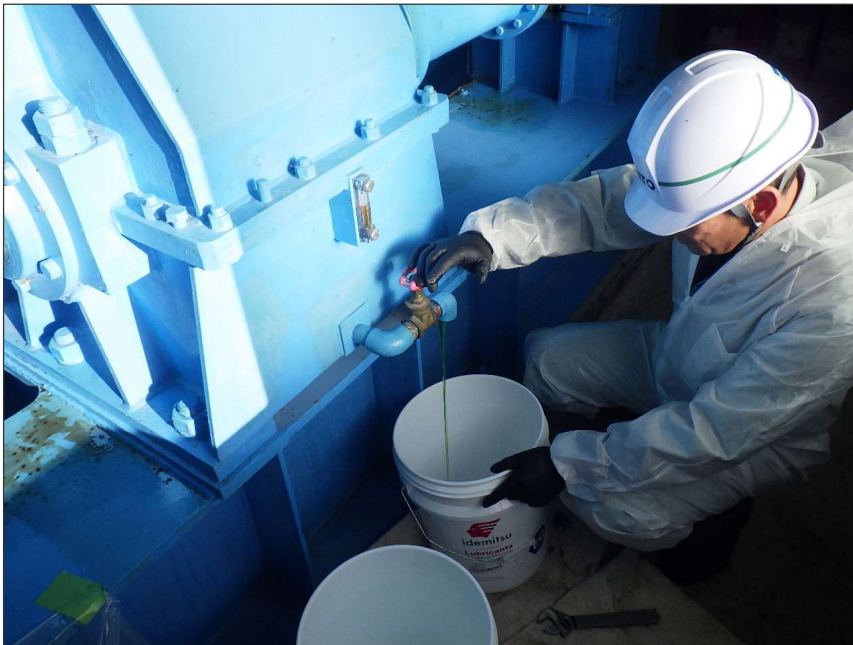
写真区分: 施工状況写真 工種: 取水ゲート 種別: 開閉装置 細別: 減速機 写真タイトル: 抜油状況 撮影箇所: 減速機
