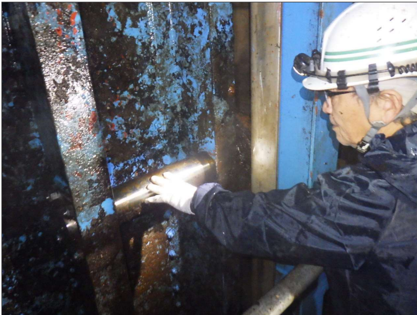
写真区分: 施工状況写真 工種: 取水ゲート 種別: 扉体 写真タイトル: 外観点検状況 撮影箇所: 主ローラ軸
