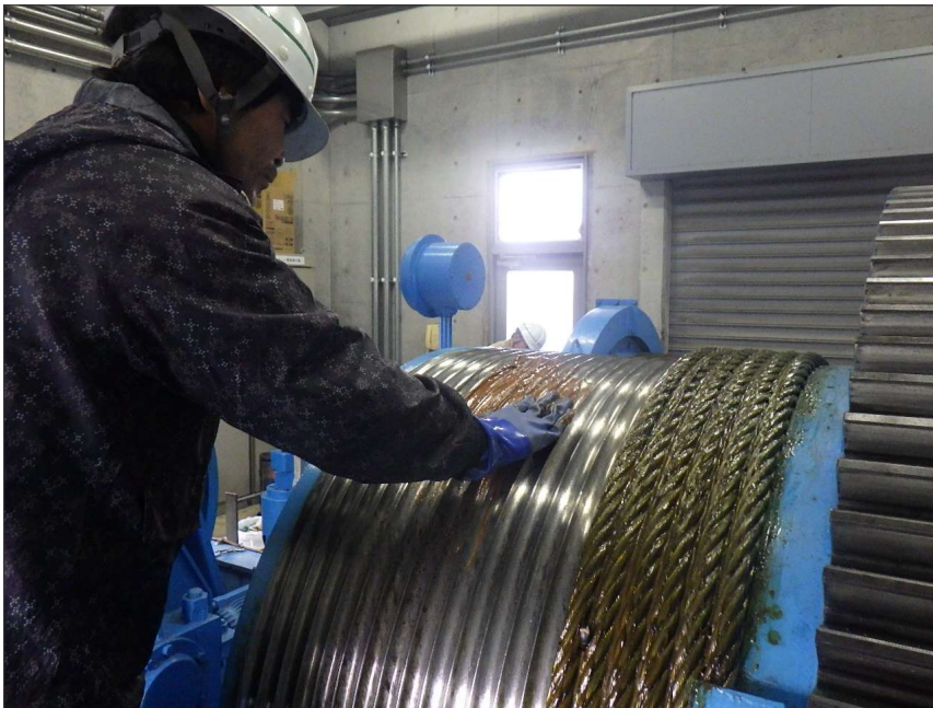
写真区分: 施工状況写真 工種: 取水ゲート 種別: 開閉装置 写真タイトル: 給脂状況 撮影箇所: ワイヤドラム
