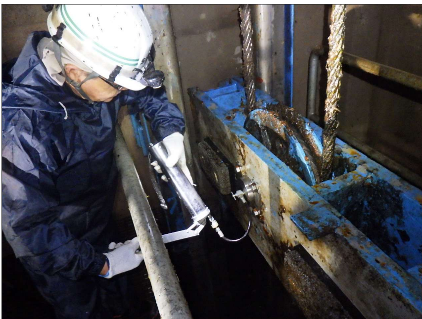
写真区分: 施工状況写真 工種: 取水ゲート 種別: リフティングビーム 写真タイトル: 給脂状況 撮影箇所: シーブ軸
