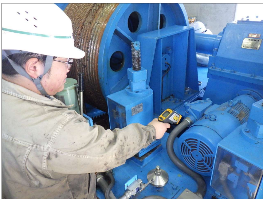
写真区分: 施工状況写真 工種: 取水ゲート 種別: 開閉装置 写真タイトル: 管理運転状況 撮影箇所: 電動機
