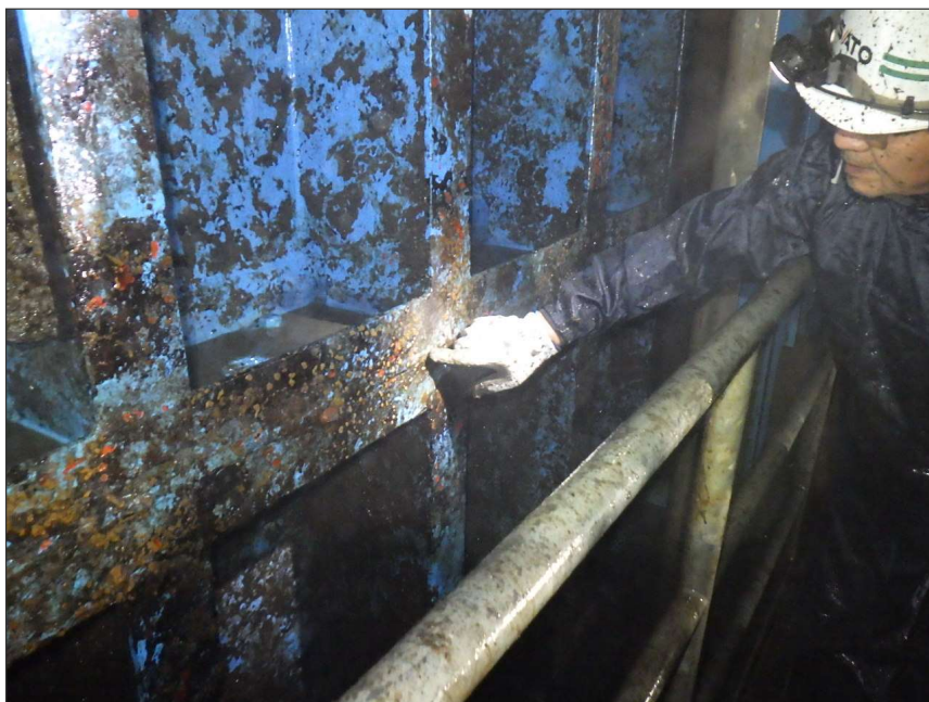
写真区分: 施工状況写真 工種: 取水ゲート 種別: 扉体 写真タイトル: 外観点検状況 撮影箇所: 溶接部
