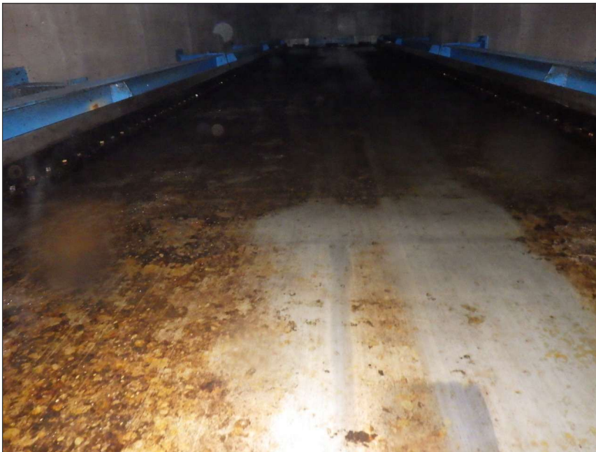
写真区分: 施工状況写真 工種: 取水ゲート 種別: 扉体 写真タイトル: 外観点検状況 撮影箇所: スキンプレート
