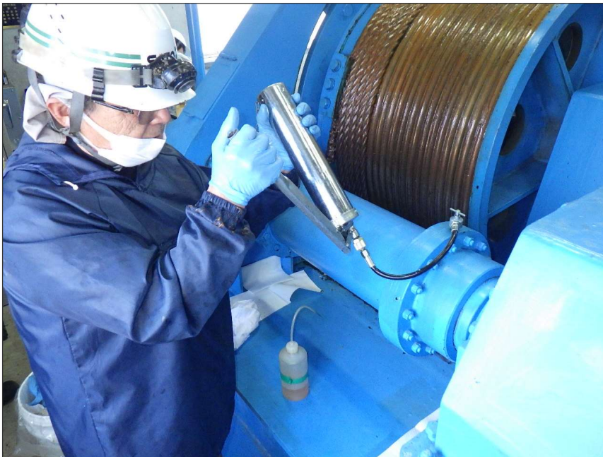
写真区分: 施工状況写真 工種: 取水ゲート 種別: 開閉装置 写真タイトル: 給脂状況 撮影箇所: ギヤカップリング
