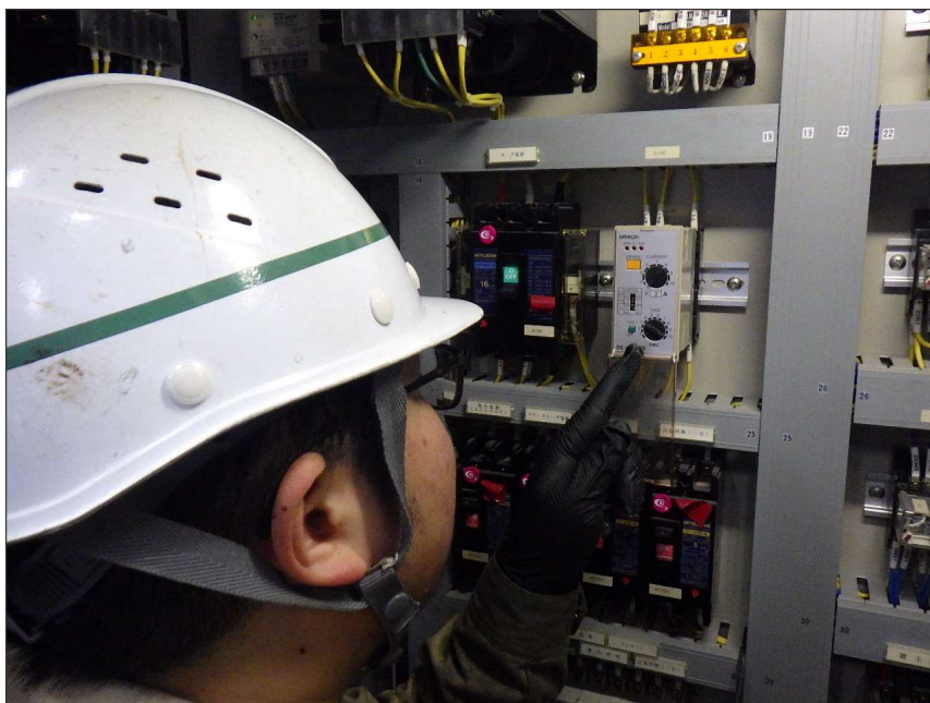
写真区分: 施工状況写真 工種: 取水ゲート 種別: 開閉装置 写真タイトル: 設定値確認状況 撮影箇所: 3Eリレー
