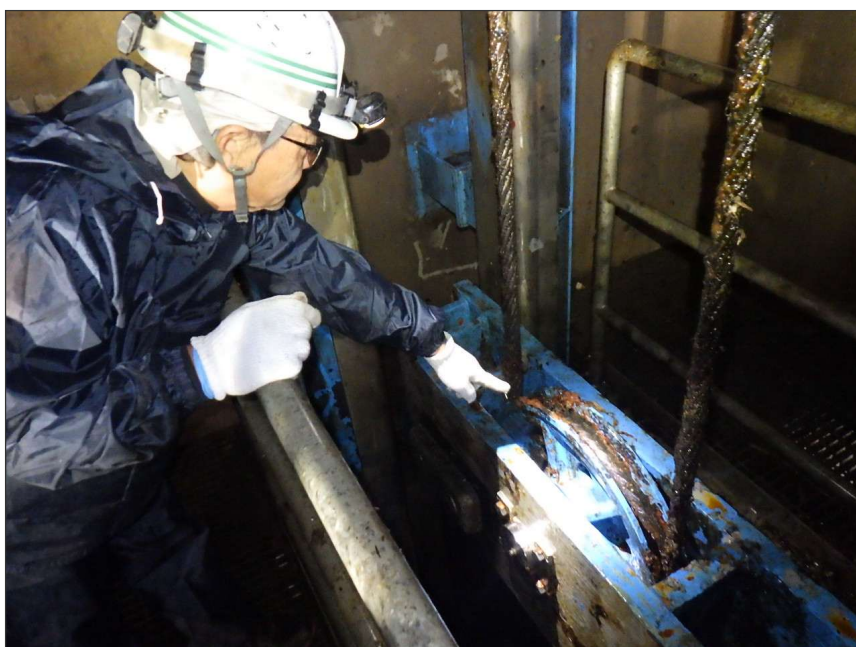
写真区分: 施工状況写真 工種: 取水ゲート 種別: リフティングビーム 写真タイトル: 外観点検状況 撮影箇所: シーブ
