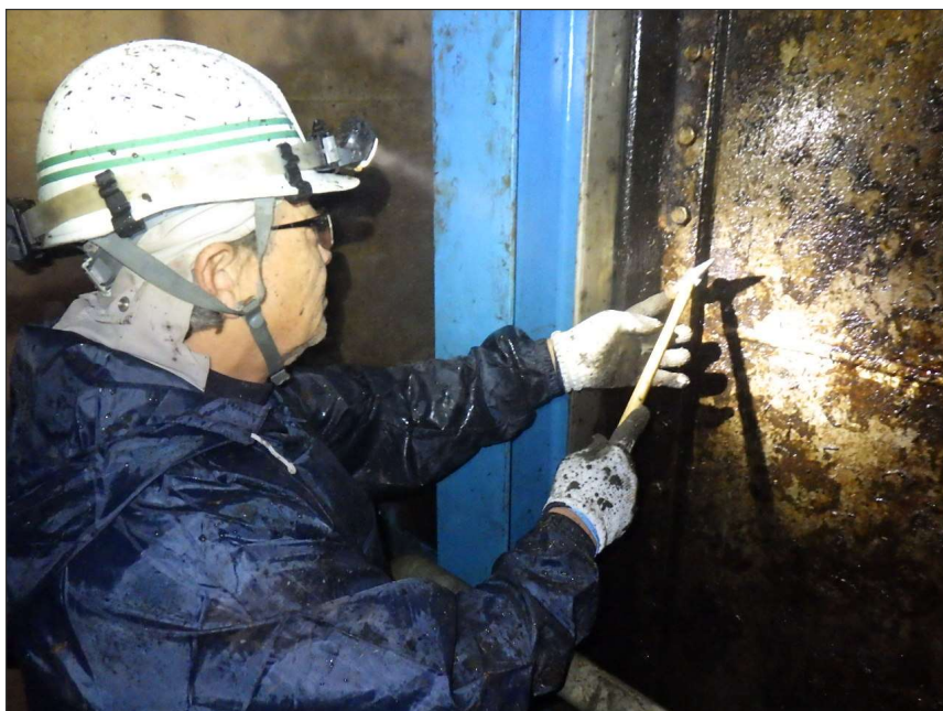
写真区分: 施工状況写真 工種: 取水ゲート 種別: 扉体 写真タイトル: ボルト緩み点 検状況 撮影箇所: 側部水密ゴム押え
