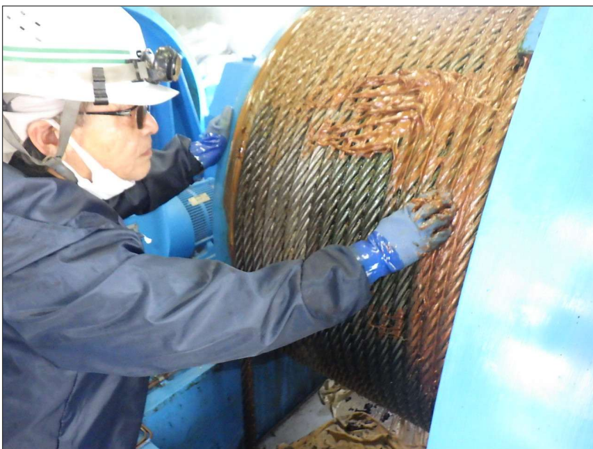
写真区分: 施工状況写真 工種: 取水ゲート 種別: 開閉装置 写真タイトル: 給脂状況 撮影箇所: ワイヤロープ
