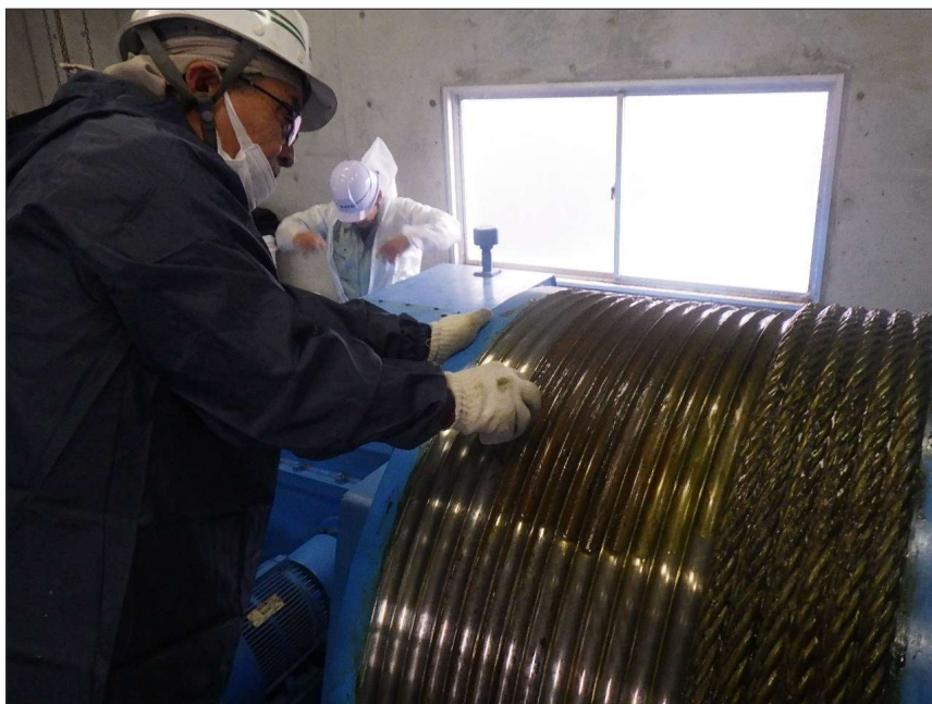
写真区分: 施工状況写真 工種: 取水ゲート 種別: 開閉装置 写真タイトル: 清掃状況 撮影箇所: ワイヤドラム
