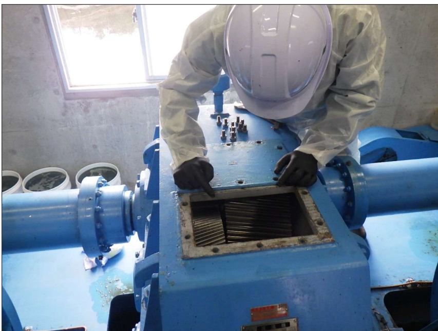
写真区分: 施工状況写真 工種: 取水ゲート 種別: 開閉装置 細別: 減速機 写真タイトル: 歯面確認 撮影箇所: 減速機
