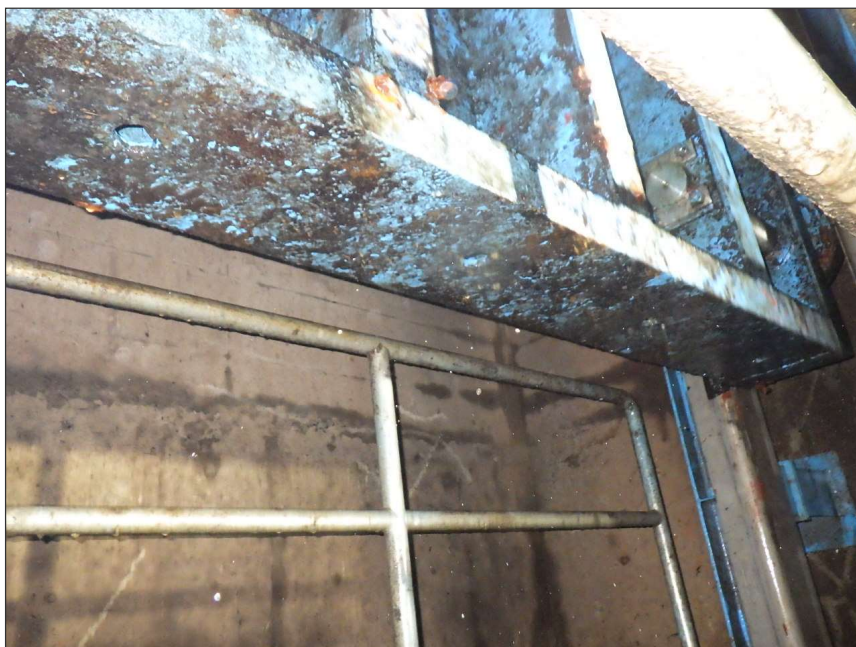
写真区分: 施工状況写真 工種: 取水ゲート 種別: 扉体 写真タイトル: 外観点検状況 撮影箇所: 扉体下部
