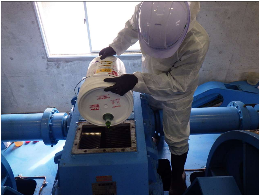
写真区分: 施工状況写真 工種: 取水ゲート 種別: 開閉装置 細別: 減速機 写真タイトル: 給油状況 撮影箇所: 減速機
