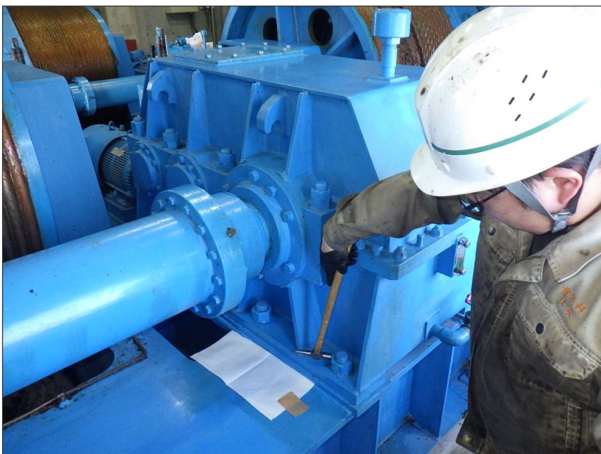
写真区分: 施工状況写真 工種: 取水ゲート 種別: 開閉装置 写真タイトル: ボルト緩み点 検状況 撮影箇所: 減速機架台
