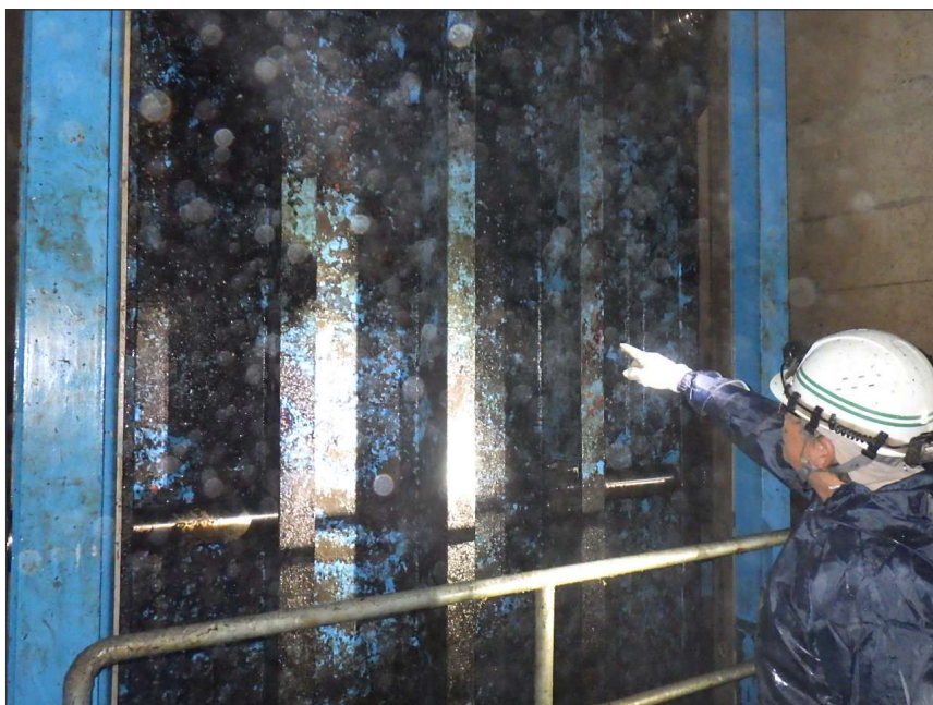
写真区分: 施工状況写真 工種: 取水ゲート 種別: 扉体 写真タイトル: 外観点検状況 撮影箇所: 扉体桁
