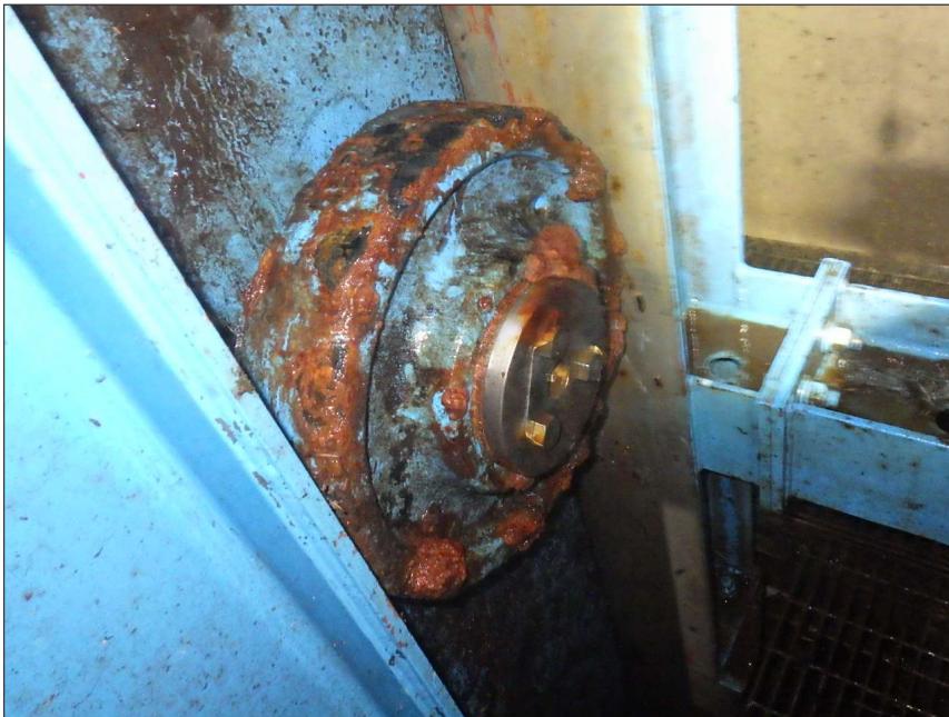
写真区分: 施工状況写真 工種: 取水ゲート 種別: 扉体 写真タイトル: 外観点検状況 撮影箇所: 主ローラ
