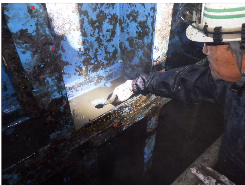
写真区分: 施工状況写真 工種: 取水ゲート 種別: 扉体 写真タイトル: 外観点検状況 撮影箇所: 水抜穴
