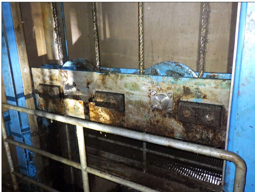
写真区分: 施工状況写真 工種: 取水ゲート 種別: リフティングビーム 写真タイトル: 外観点検状況 撮影箇所: リフティングビーム
