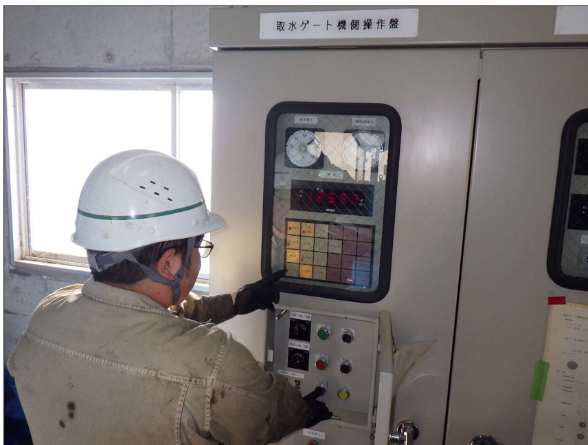
写真区分: 施工状況写真 工種: 取水ゲート 種別: 開閉装置 写真タイトル: 管理運転状況 撮影箇所: 機側操作盤
