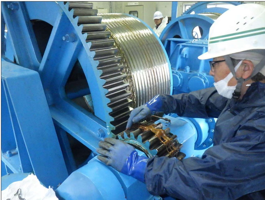
写真区分: 施工状況写真 工種: 取水ゲート 種別: 開閉装置 写真タイトル: 給脂状況 撮影箇所: ドラムギヤ
