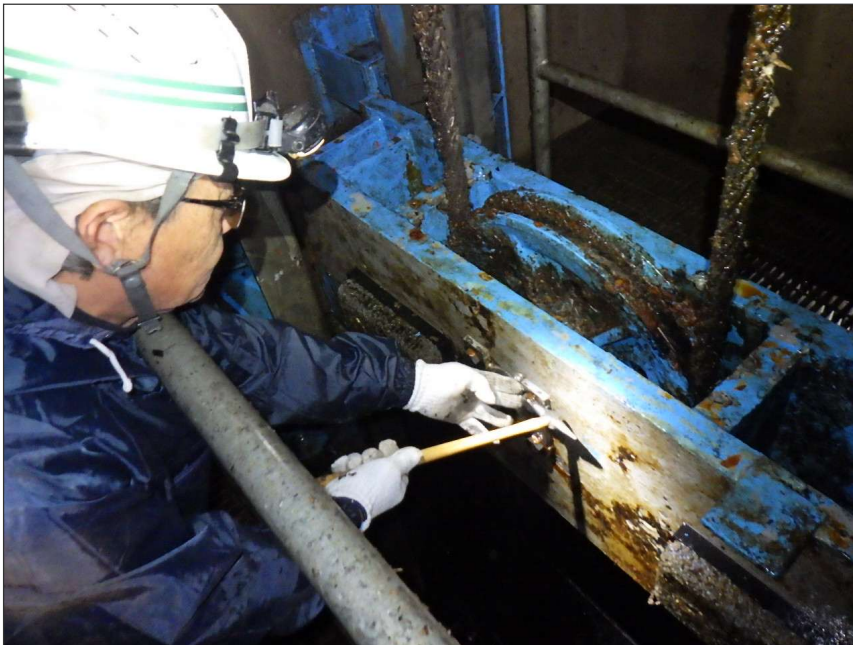
写真区分: 施工状況写真 工種: 取水ゲート 種別: リフティングビーム 写真タイトル: ボルト緩み点 検状況 撮影箇所: シーブ軸
