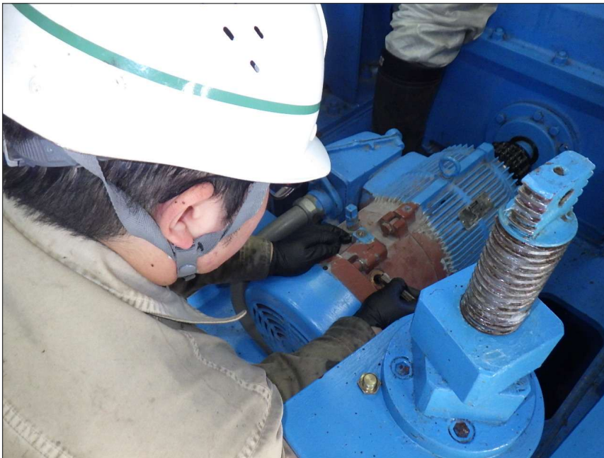
写真区分: 施工状況写真 工種: 取水ゲート 種別: 開閉装置 細別: 電動機 写真タイトル: 計測状況 撮影箇所: ブレーキ隙間
