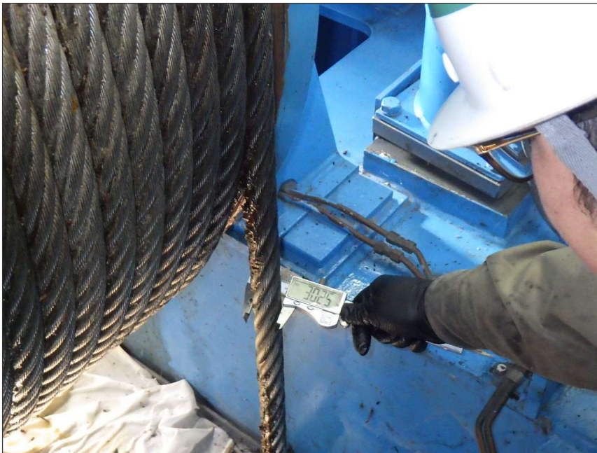
写真区分: 施工状況写真 工種: 取水ゲート 種別: 開閉装置 写真タイトル: 計測状況 撮影箇所: ワイヤロープ径
