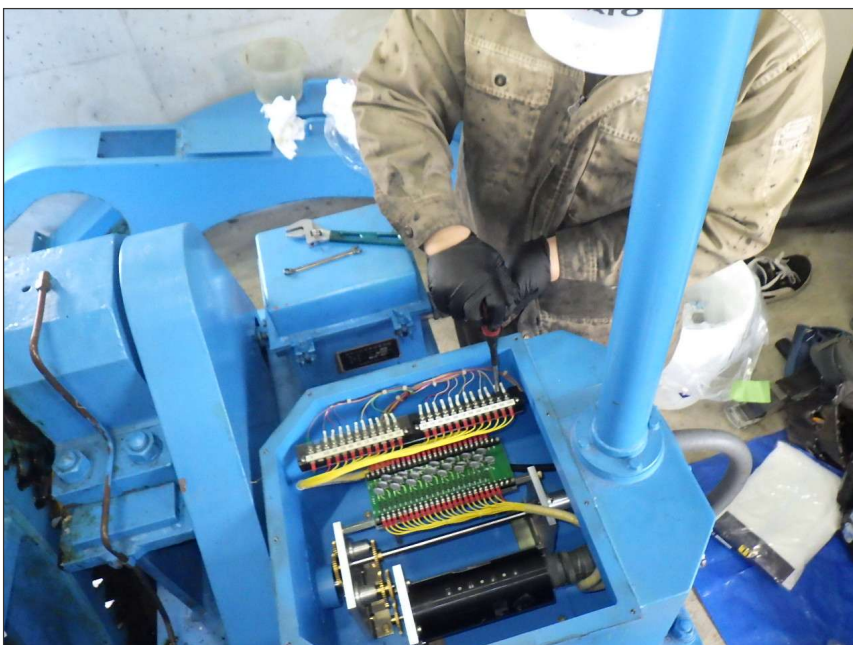
写真区分: 施工状況写真 工種: 取水ゲート 種別: 開閉装置 細別: 制限開閉器 写真タイトル: 外観点検状況 撮影箇所: 端子緩み点検状況
