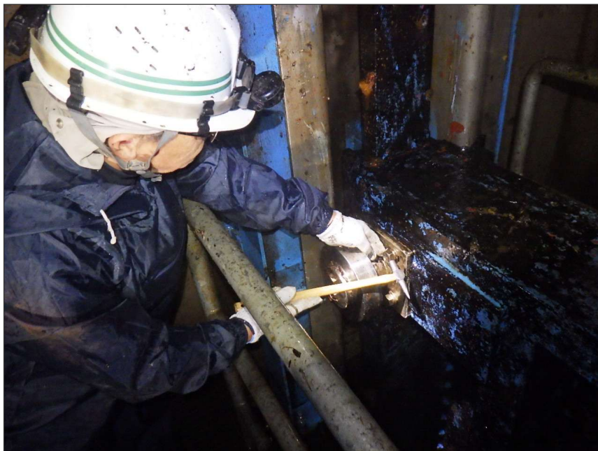
写真区分: 施工状況写真 工種: 取水ゲート 種別: 扉体 写真タイトル: ボルト緩み点 検状況 撮影箇所: サイドローラ
