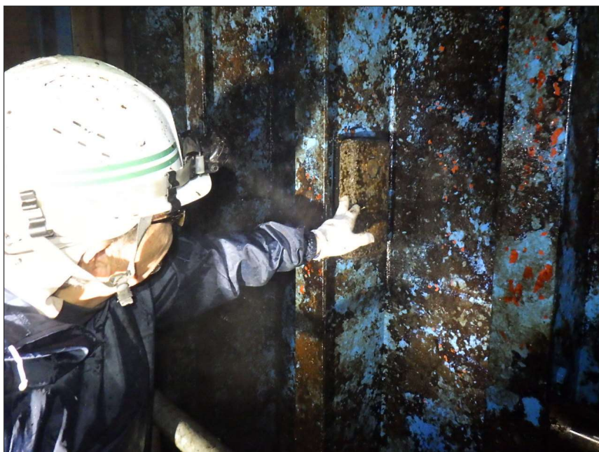
写真区分: 施工状況写真 工種: 取水ゲート 種別: 扉体 写真タイトル: 外観点検状況 撮影箇所: 犠牲陽極
