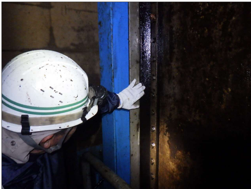
写真区分: 施工状況写真 工種: 取水ゲート 種別: 扉体 写真タイトル: 外観点検状況 撮影箇所: 側部水密ゴム
