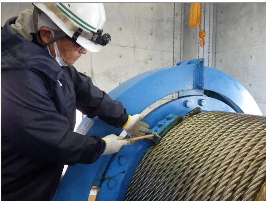
写真区分: 施工状況写真 工種: 取水ゲート 種別: 開閉装置 写真タイトル: ボルト緩み点 検状況 撮影箇所: ロープ端末締付ボ ルト
