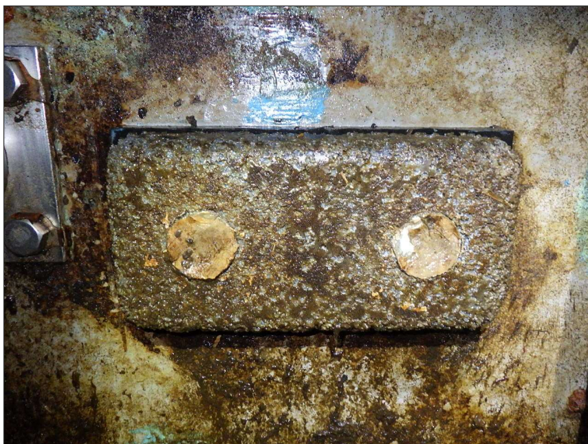
写真区分: 施工状況写真 工種: 取水ゲート 種別: リフティングビーム 写真タイトル: 外観点検状況 撮影箇所: 犠牲陽極
