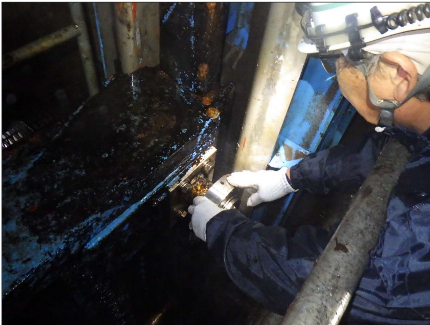
写真区分: 施工状況写真 工種: 取水ゲート 種別: 扉体 写真タイトル: 外観点検状況 撮影箇所: サイドローラ
