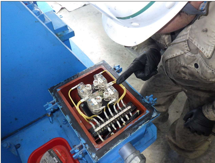
写真区分: 施工状況写真 工種: 取水ゲート 種別: 開閉装置 細別: 制限開閉器 写真タイトル: 外観点検状況 撮影箇所: 制限開閉器
