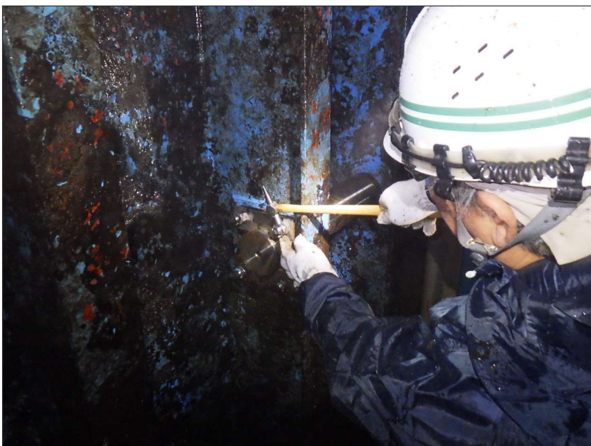
写真区分: 施工状況写真 工種: 取水ゲート 種別: 扉体 写真タイトル: ボルト緩み点 検状況 撮影箇所: 主ローラ軸
