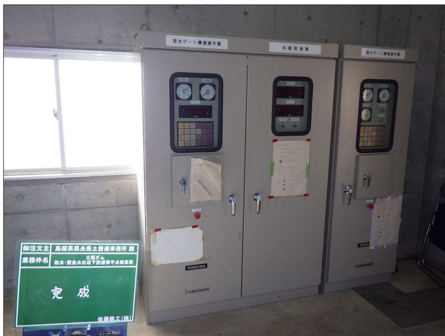
写真区分:着手前及び完成写真 工種:取水ゲート 写真タイトル:完成 撮影箇所:機側操作盤
