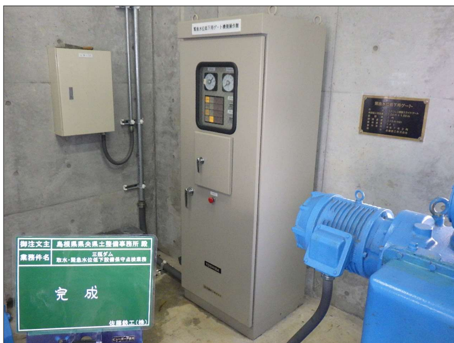
写真区分:着手前及び完成写真 工種:緊急水位低下用ゲート 写真タイトル:完成 撮影箇所:機側操作盤
