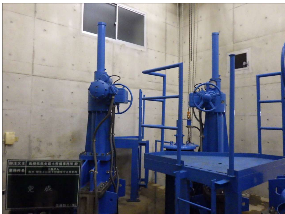
写真区分: 着手前及び完成写真 工種: 河川維持用設備 写真タイトル: 完成 撮影箇所: 開閉装置
