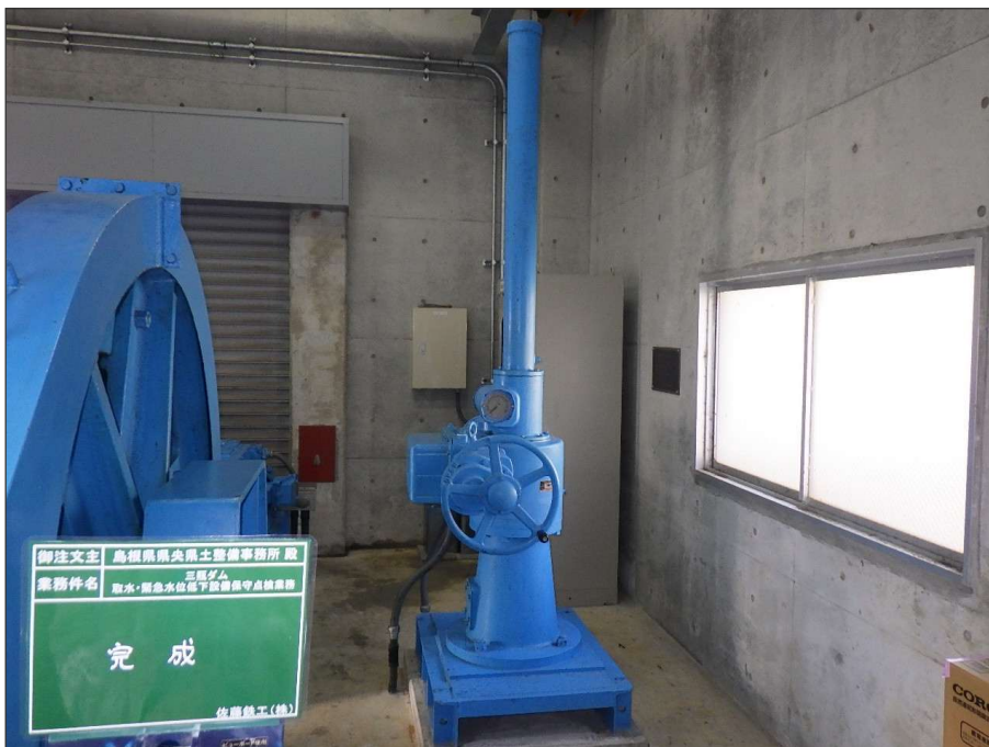
写真区分: 着手前及び完成写真 工種: 緊急水位低下用ゲート 写真タイトル: 完成 撮影箇所: 開閉装置
