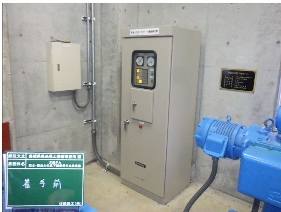
写真区分:着手前及び完成写真 工種:緊急水位低下用ゲート 写真タイトル:着手前 撮影箇所:機側操作盤
