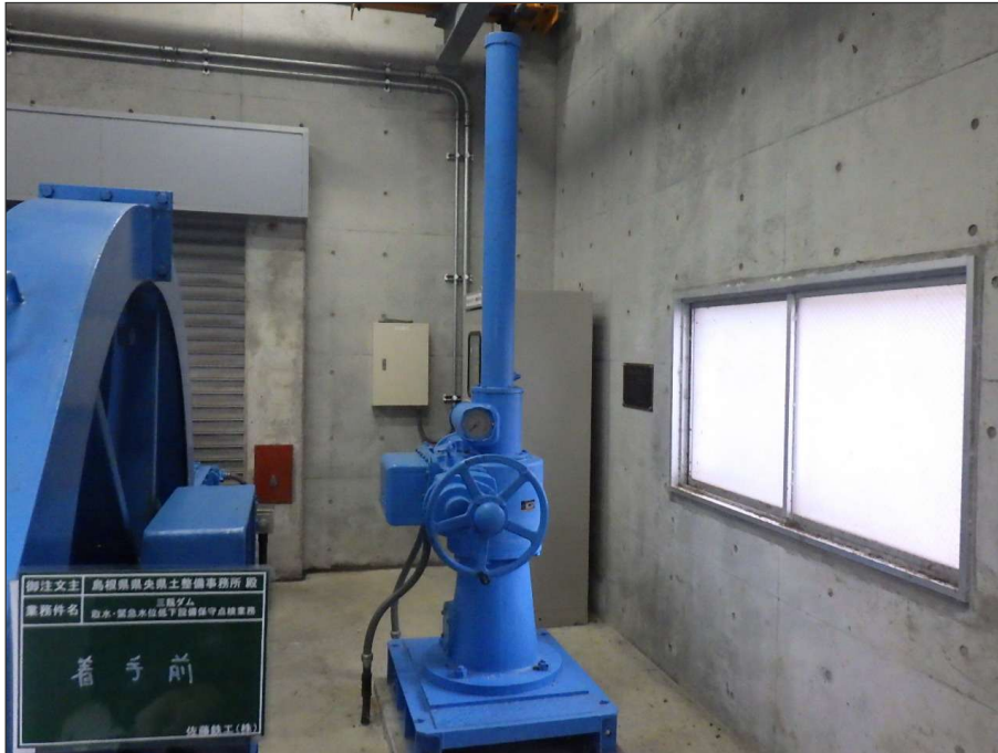
写真区分: 着手前及び完成写真 工種: 緊急水位低下用ゲート 写真タイトル: 着手前 撮影箇所: 開閉装置
