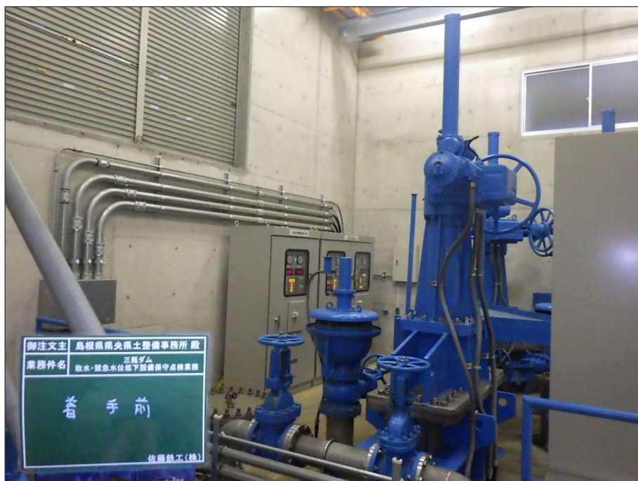
写真区分: 着手前及び完成写真 工種: 発電用制水バルブ 写真タイトル: 着手前 撮影箇所: 開閉装置
