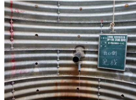
排水ボーリング(出口)完成
