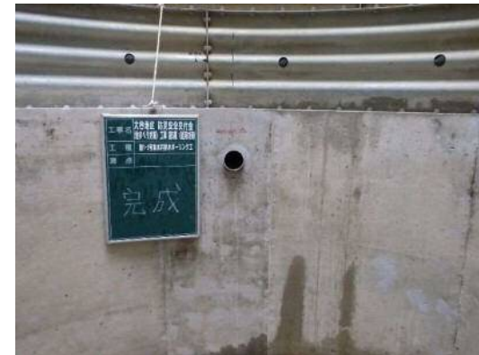
排水ボーリング(呑口)完成
