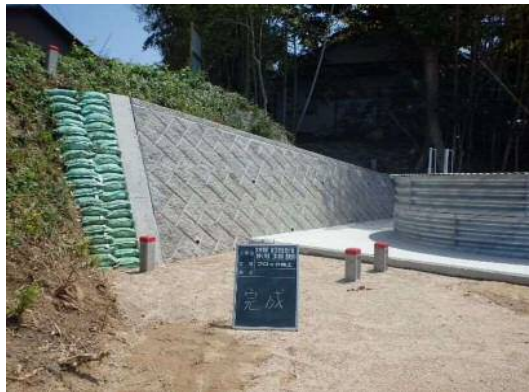
ブロック積完成
