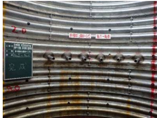
集水ボーリング(上段)完成
