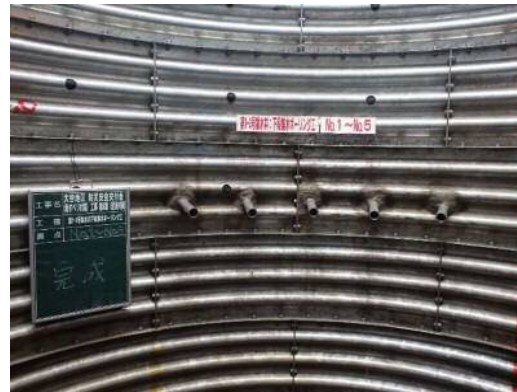
集水ボーリング(下段)完成
