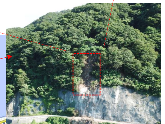
道路面から約70mの箇所が被災し、危険な状況
