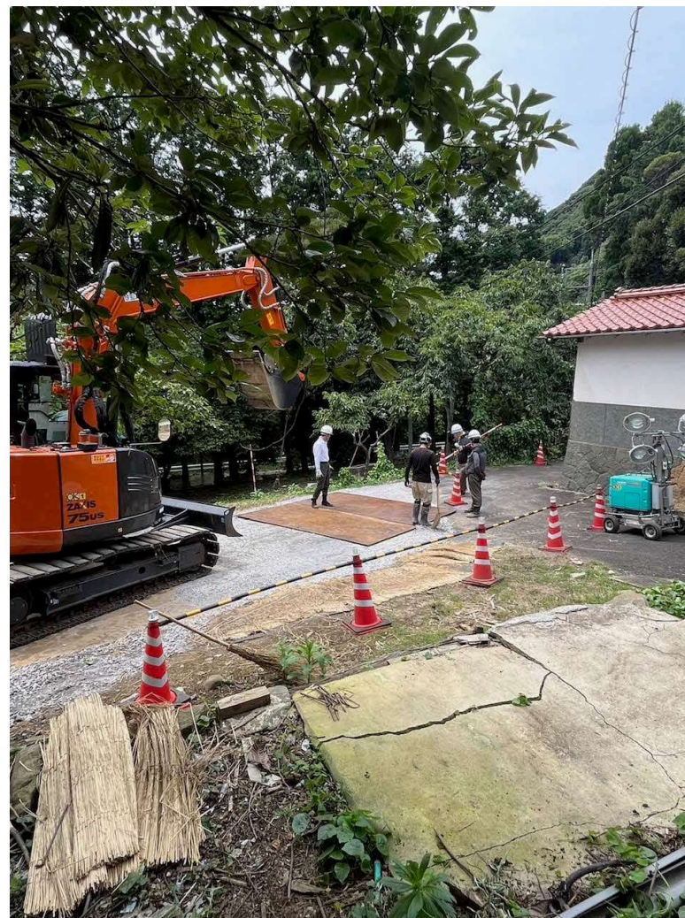
仮設迂回道路整備状況写真(令和6年7月25日 撮影)
