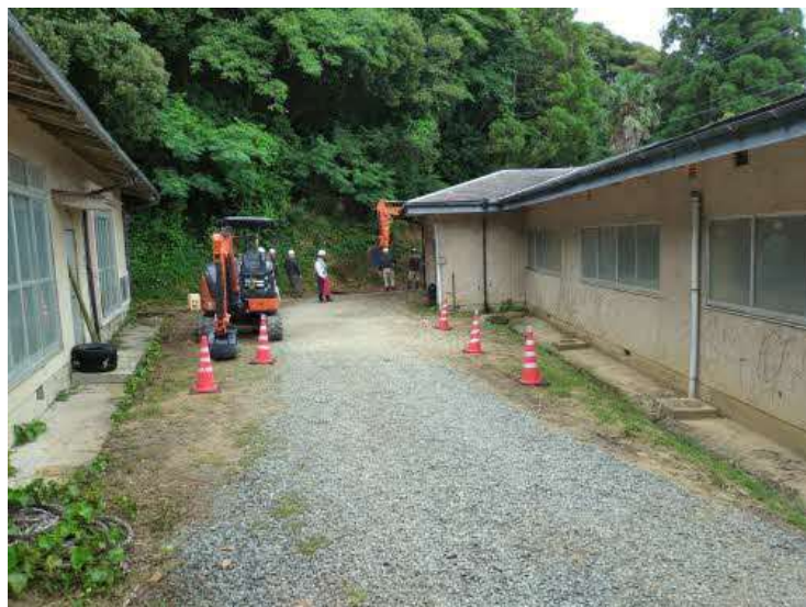
仮設迂回道路整備状況写真(令和6年7月24日 撮影)
