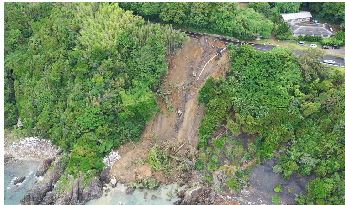
被災状況写真(R6.7.10 12:00ごろ撮影)
