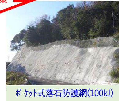
ポケット式落石防護網(100kJ)
