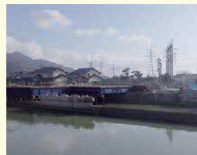
工事 前 の橋台・橋脚
