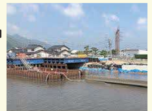
工事 中 の橋台・橋脚
