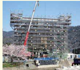
工事 中 の大鳥居
