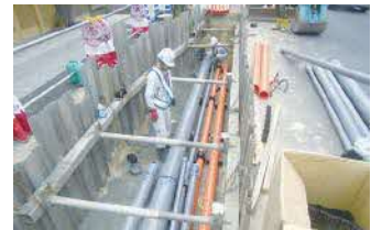
神門通り線1工区の電線共同溝設置工事の様子
