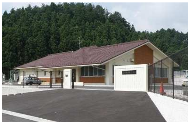
西郷浄化センター（隠岐の島町）
