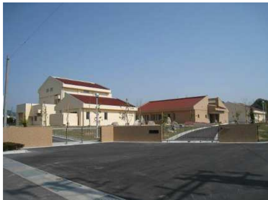
大田浄化センター（大田市）
