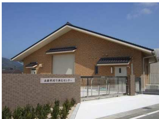
河下浄化センター（出雲市）
