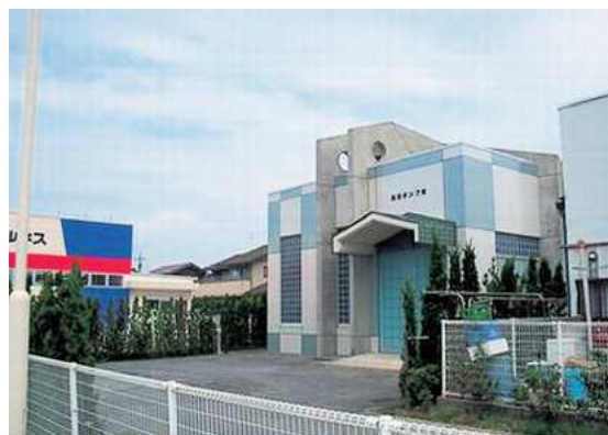
黒田中継ポンプ場（松江市）
