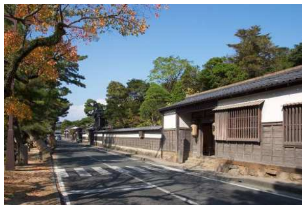
景観地区（松江市）
