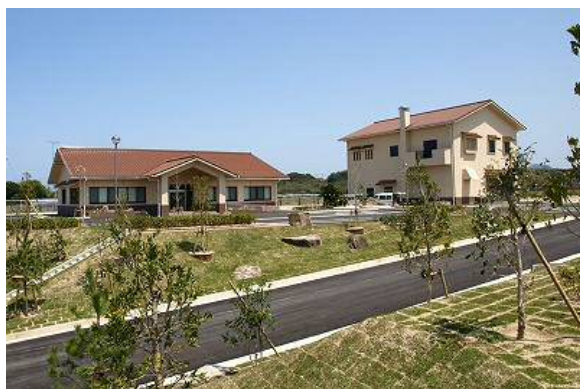
益田水質管理センター（益田市）
