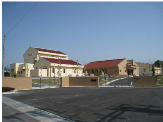
大田浄化センター（大田市）
