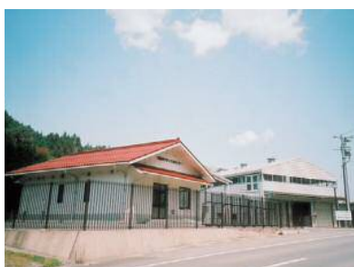
大田市リサイクルセンター (大田市)
