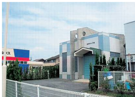
黒田中継ポンプ場（松江市）
