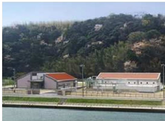
国府浄化センター（浜田市）
