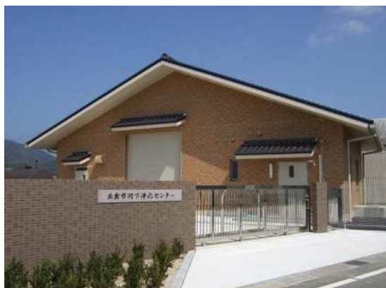
河下浄化センター（出雲市）
