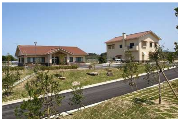
益田水質管理センター（益田市）
