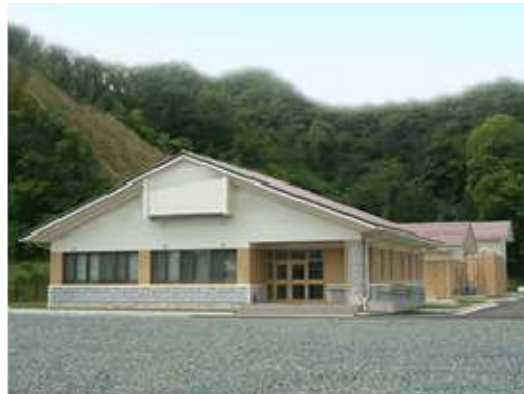
大東浄化センター（雲南市）
