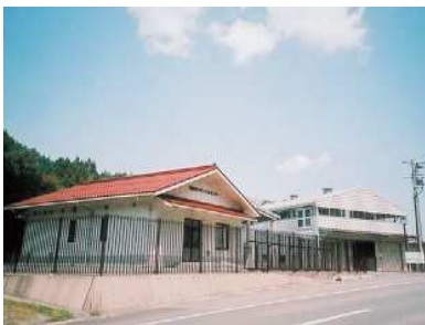
大田市リサイクルセンター（大田市）
