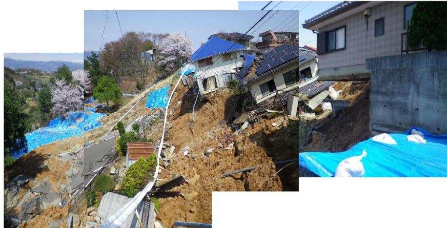
写 3-11 のり面の崩壊の例
