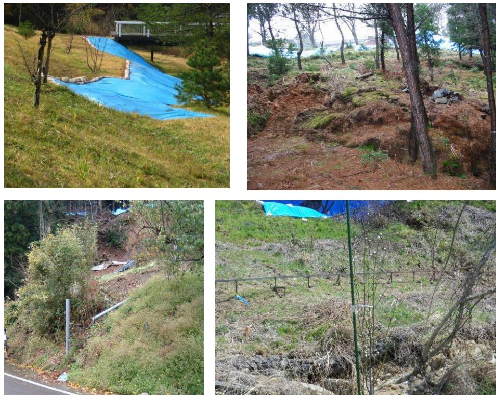
写3-9 のり面のハラミ・盤ぶくれの例
