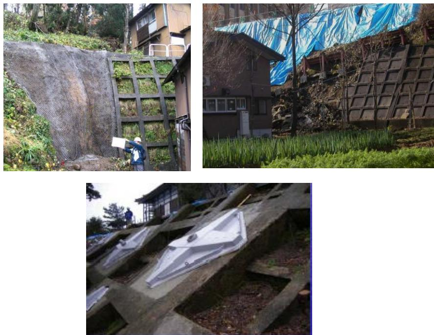
写 3-12 のり面保護工の変状の例
