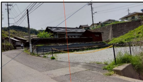
②川本合庁第2駐車場
