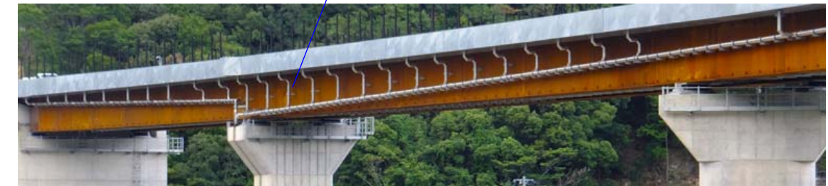
横引き排水管の国内事例 路面と異なる勾配の横引き排水管
