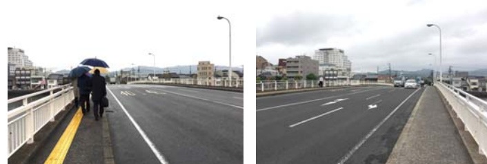
新大橋の現況
