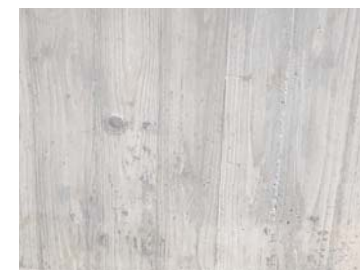
小幅板型枠による表面仕上げ
