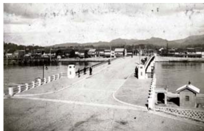
拡幅前の第2代新大橋 / 1934年（昭和9年）完成
