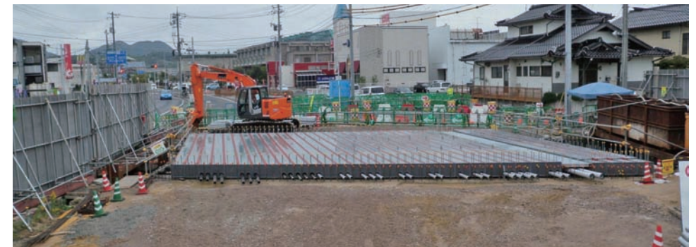
橋げたを西側からみた状況
