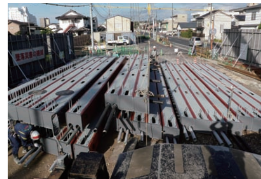
橋げたになる角型の鋼管
