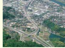
▲松江 JCT（山陰道・松江だんだん道路）
