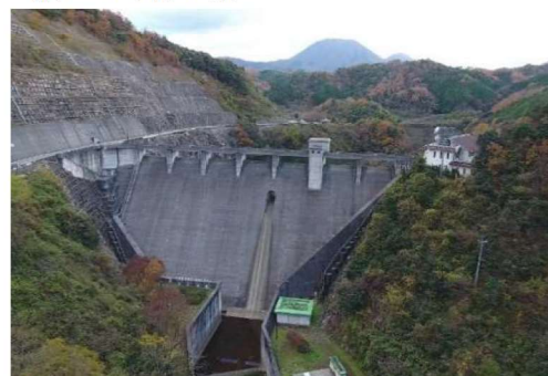
三瓶ダム本体全景
