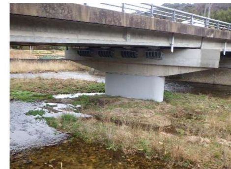
令和4年度完了 橋脚部
