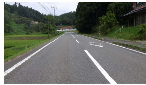
（主）温泉津川本線（井田工区） R5予定
