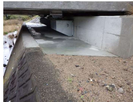
令和4年度完了 橋台部
