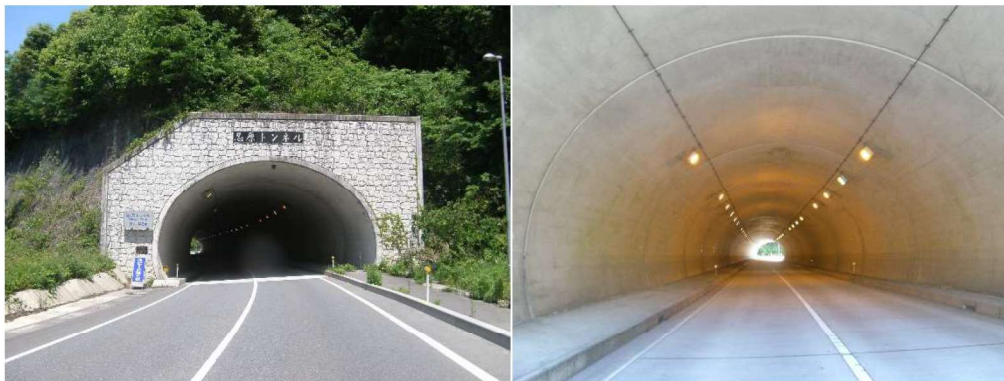
国道375号 忍原トンネル (R2年度完了)
