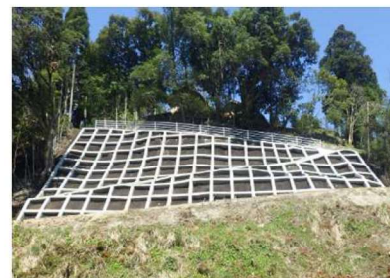
排土+法柱 (土砂を除去し斜面の安定を図る)
