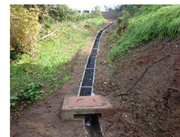
地表水排除工 (表面水の地下浸透を防ぐ：排水路)
