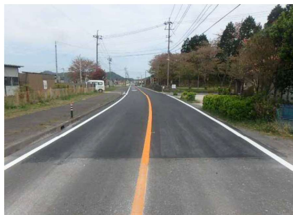
国道375号（吉永工区） R3完成
