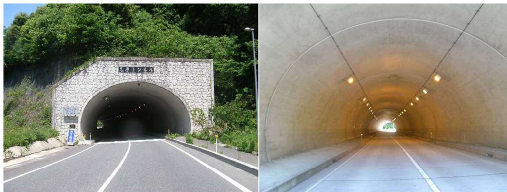
国道375号 忍原トンネル (R2年度完了)
