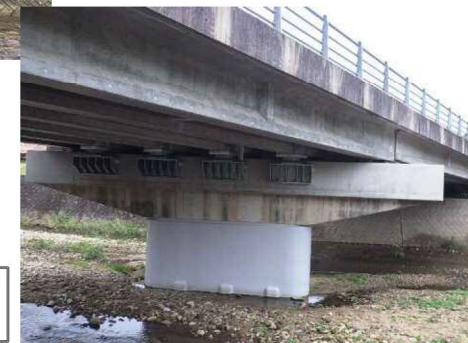
令和3年度完了 橋脚部
