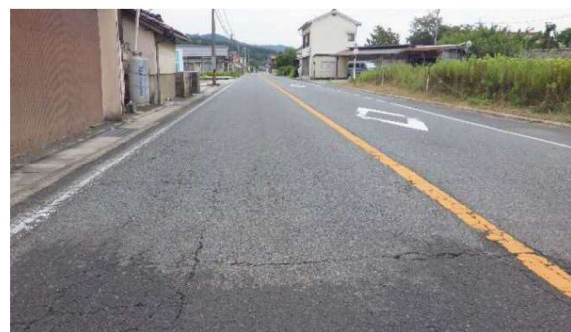
国道375号（川合工区） R4予定
