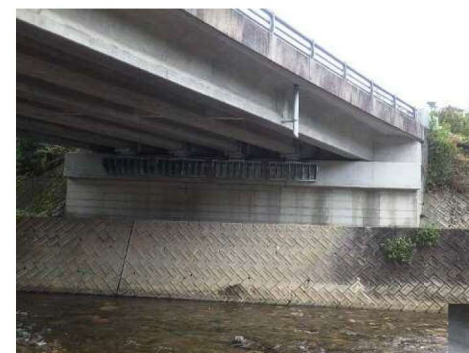
令和3年度完了 橋台部
