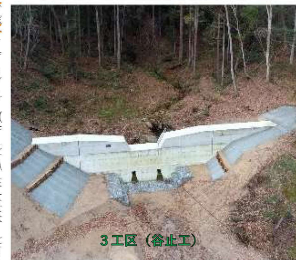
R4（2工区）2号谷止工
