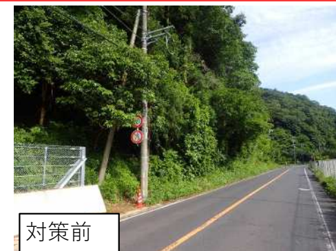
(主) 温泉津川本線 (福光2工区)
