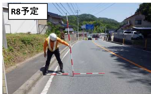
国道375号 (大田工区)
