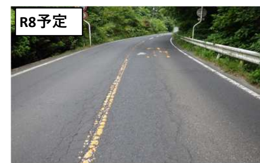
(主) 温泉津川本線 (福光工区)
