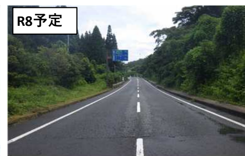
(主) 仁摩邑南線 (水上工区)
