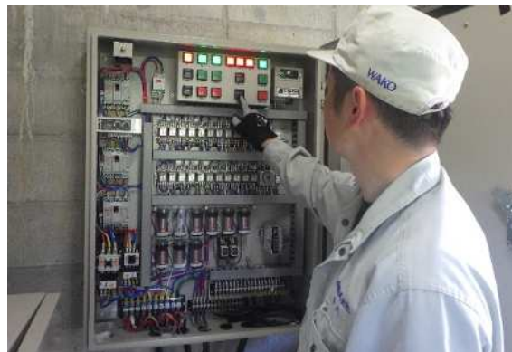
管理設備保守点検 サイレン制御盤点検
