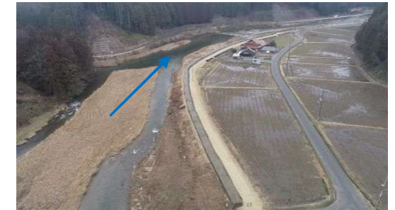
中間付近から終点付近を望む
