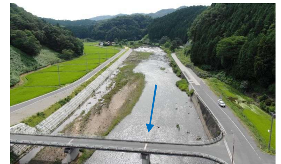
終点付近から中間付近を望む
