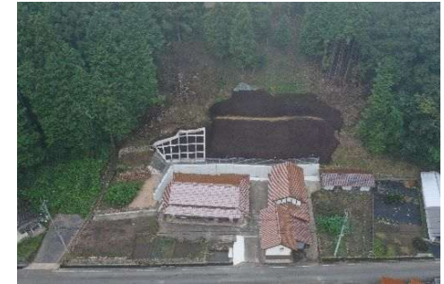
R7工事完了箇所
