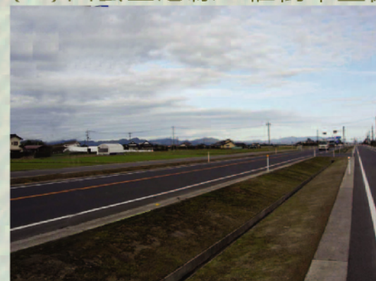
現況の道路 ソイルセメントによる防草対策
