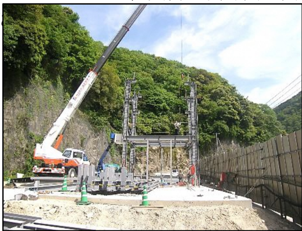
コンクリートプラント組立状況
