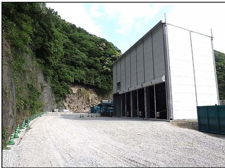
作業ヤードの様子(奥がトンネル入口)
