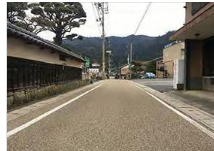
脱色アスファルト舗装 (原鉱業参照)
