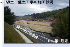
H30年5月末 切土・盛土工事の施工状況
