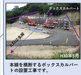
H30年5月 本線を横断するボックスカルバートの設置工事です。
