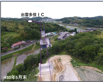
H30年5月末 橋桁が架設される予定です。
