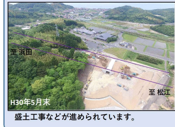
H30年5月末 盛土工事などが進められています。
