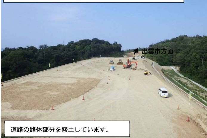
小田地区改良第 16 工事 【H29.7 月撮影】
