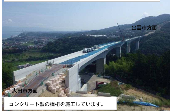
小田第 1 高架橋 PC 上部工事 【H29.7 月撮影】
