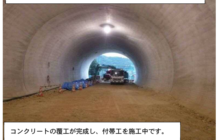
口田儀第 3 トンネル工事 【H29.7 月撮影】
