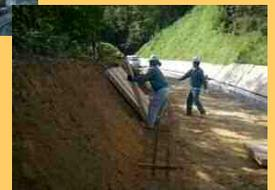
三坂小林線2工区では県産材による間伐材利用パネルを切土法面に設置することにより、防草効果による視距確保、丸太筋工や木柵工による盛土斜面の雨水・浸透水対策を行うなど、木材の特性に留意しながら適切な性能を発揮させている点が評価されました。
