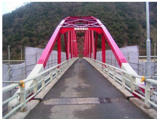
補修された三国橋の外観
