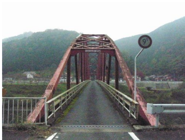
補修前の三国橋の外観
