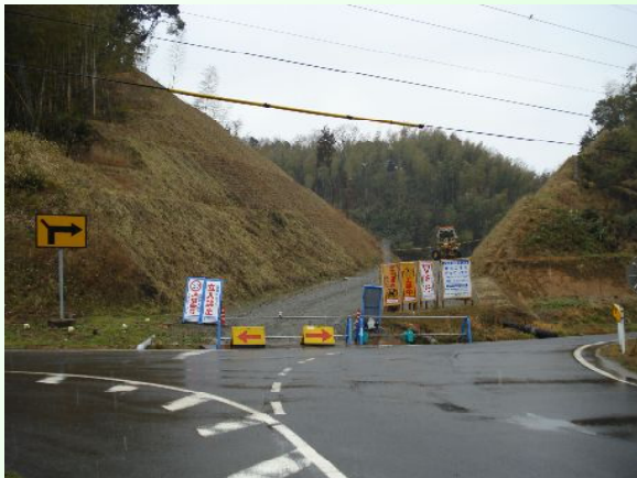
アスファルト舗装の下の路盤を敷いています (東谷地内)
