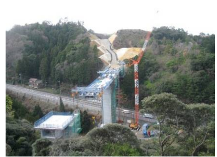
仁摩温泉津道路（小浜第3高架橋）
