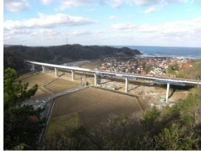
仁摩温泉津道路（福波第2高架橋）
