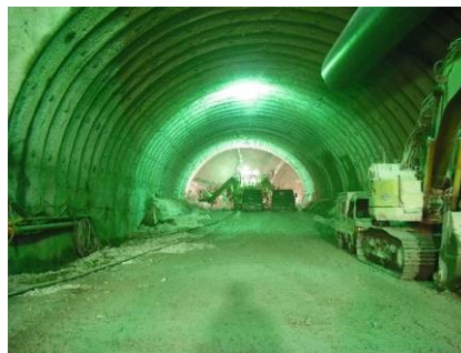
尾道松江線（大万木トンネル）
