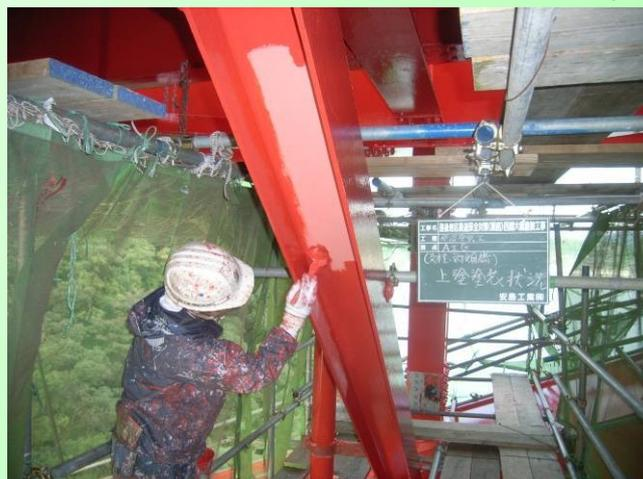
大きな橋ですが、機械で作業できないため手作業で塗り替えをしています。
