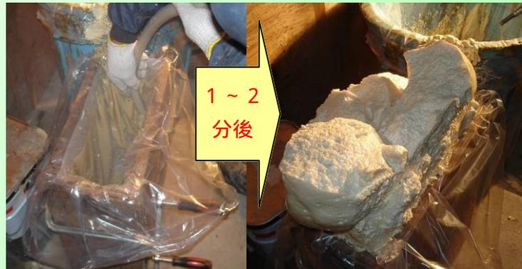
空洞に入れるのは、硬質発砲ウレタンです。これは、2つの液を混ぜて作る発泡スチロールのようなものです。混ぜると約40倍に膨らみ、2分くらいで固まります。
