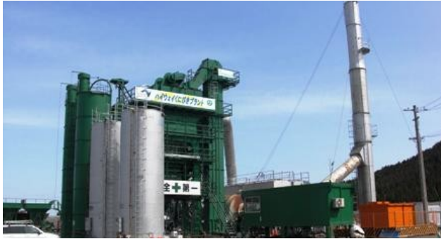
出雲市上塩冶町に建設された「くにびきハイウェイプラント」
