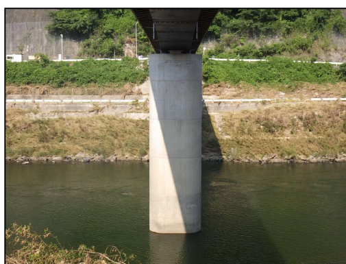
橋脚 RC 巻立て（施工前）
