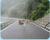
舗装の 陥没
