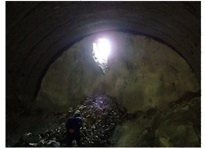
貫通時の状況 奥から光が差し込みました
