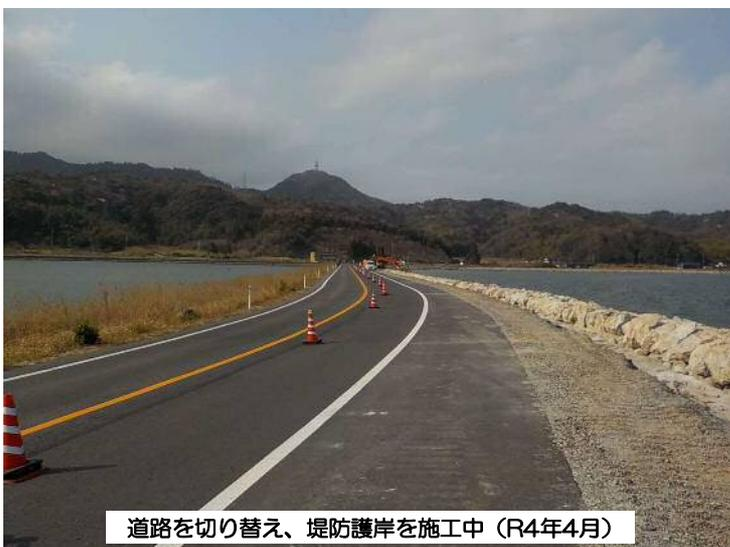
道路を切り替え、堤防護岸を施工中（R4年4月）
