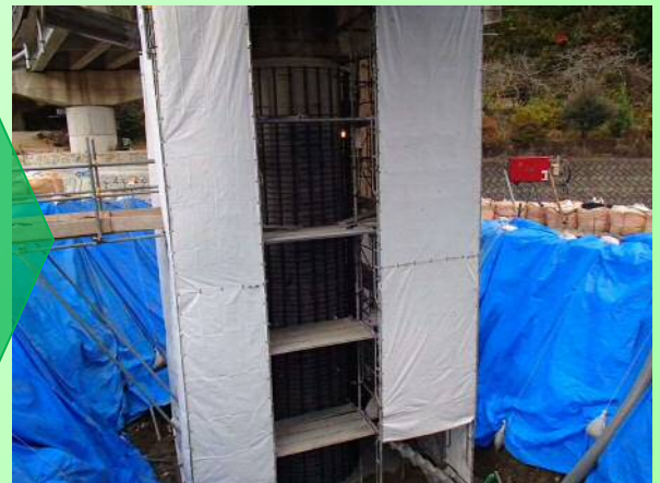
ただいま工事中
